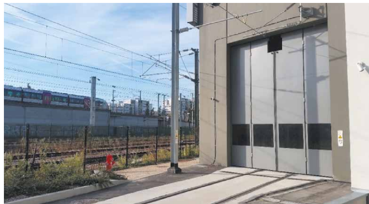
Figure 47. Entrée du terminal ferroviaire urbain (source : A. Heitz, 2019)
