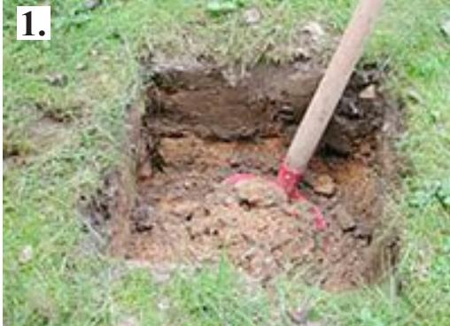
Eine Grube für jeden Pfosten ausheben.
