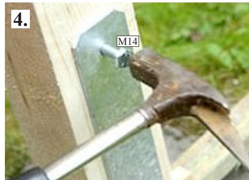
Eine Maschinenschraube vorsichtig durch die Öffnung des H-Pfostenankers einschlagen bis sie auf der anderen Seite wieder austritt.
