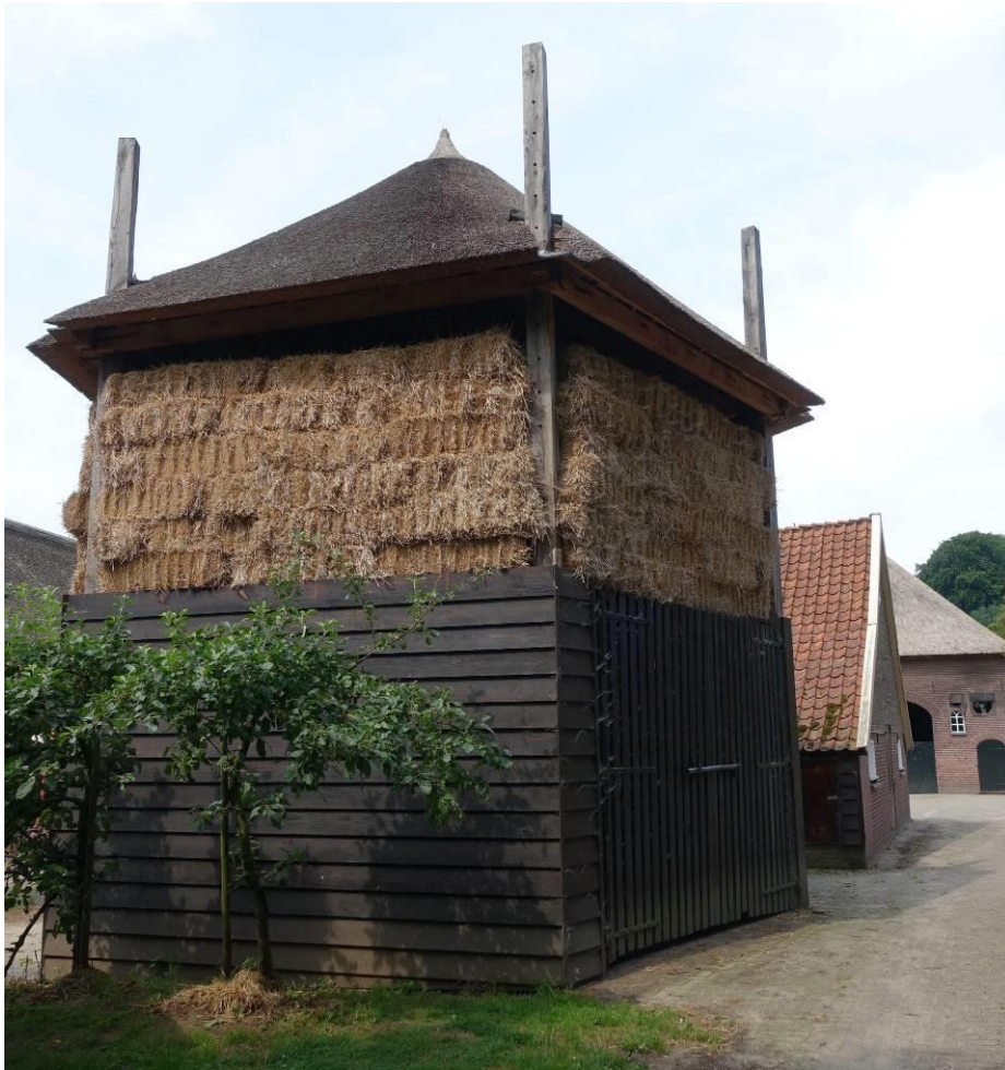
De vijfroedige schuurberg vanuit het oosten.
