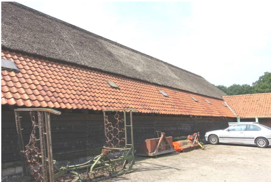
De noordgevel (overzicht) van de koeienstal.
