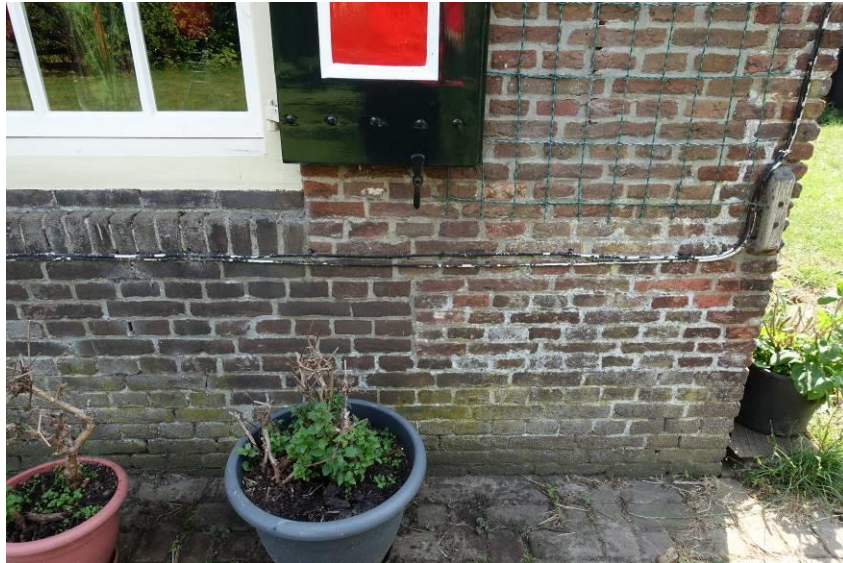
Detail van de rechter onderhoek van de voorgevel met rechts het oude metselwerk en links en in de plint metselwerk uit 1881.
