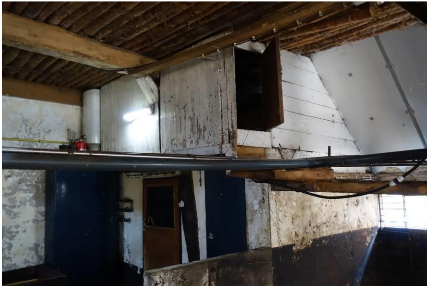
De deel met een restant van de hilde boven de speelkeuken naar het noordwesten.
