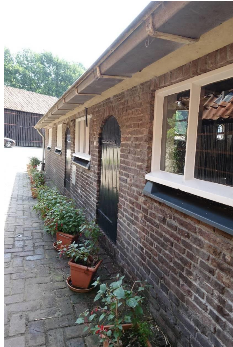
De linker zijgevel van het bedrijfs gedeelte van de boerderij naar het oosten.
