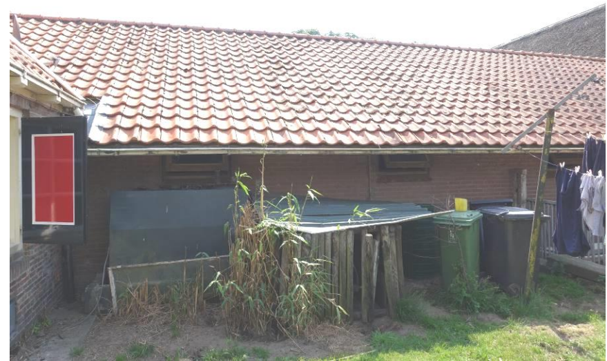
De westgevel van de melkstal.
