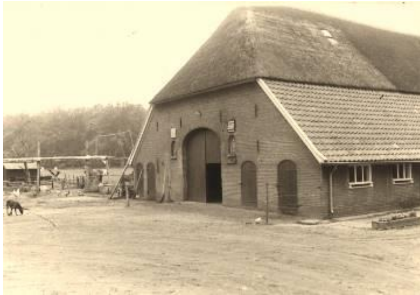
De achtergevel van boerderij Nieboer vanuit het noordoosten gezien in 1976 Archief Natuurmonumenten.
