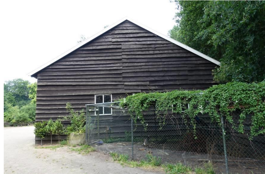
De zuidgevel van de werktuigenloods.
