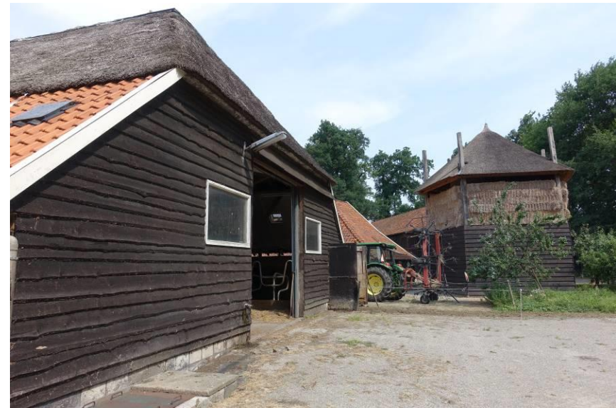
De oostgevel van de koeienstal naar het noorden gezien.
