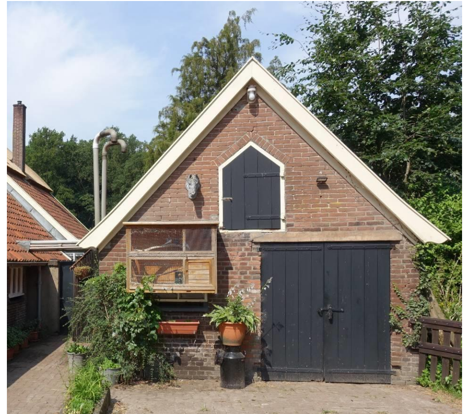
Achtergevel van het bakhuis.
