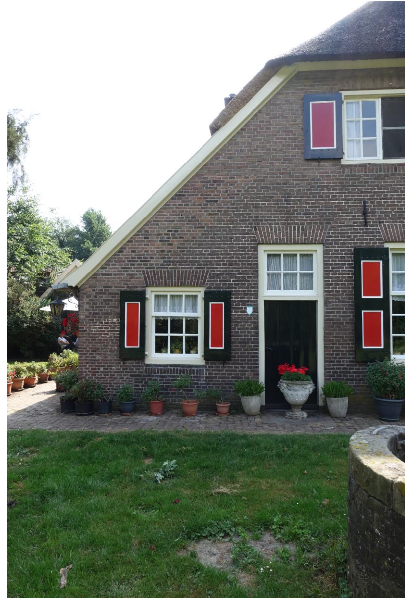
De linker zijde van de voorgevel (westgevel) van de boerderij.
