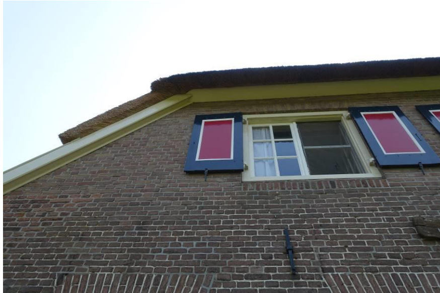
De linker bovenhoek van de voorgevel (westgevel) van de boerderij. Kort onder het venster begint het naoorlogse metselwerk.
