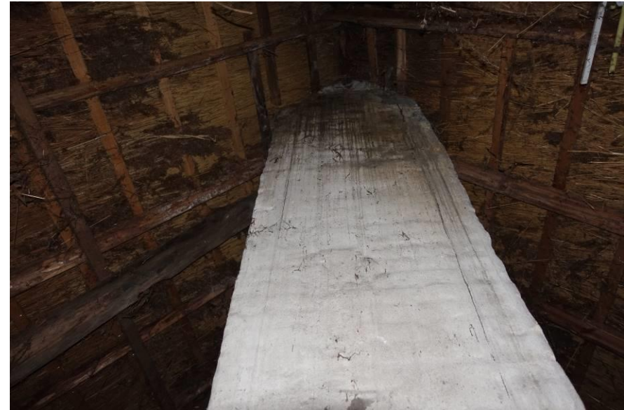
De vloering met het vermoedelijk na de oorlog in gewijzigde vorm herbouwde rookkanaal.
