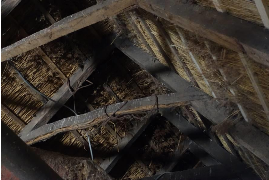
Detail van de oude nokconstructie met haanhout op de hooizolder naar het westen gezien.
