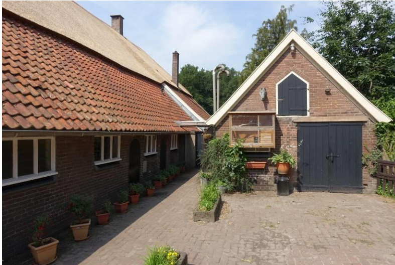
De linker zijgevel van het bedrijfsgedeelte van de boerderij naar het westen gezien met rechts het bakhuis.
