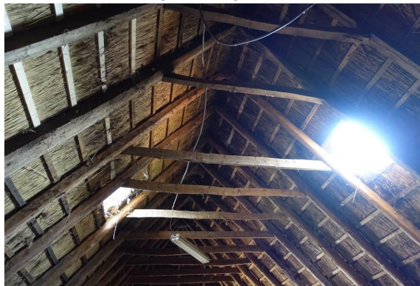
De nokconstructie van de hooizolder naar het oosten gezien. De haanhouten van de uitbreiding uit 1926 liggen lager dan die van de oude kap.
