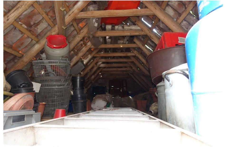
Bakhuis, zicht in de zolder naar het westen.
