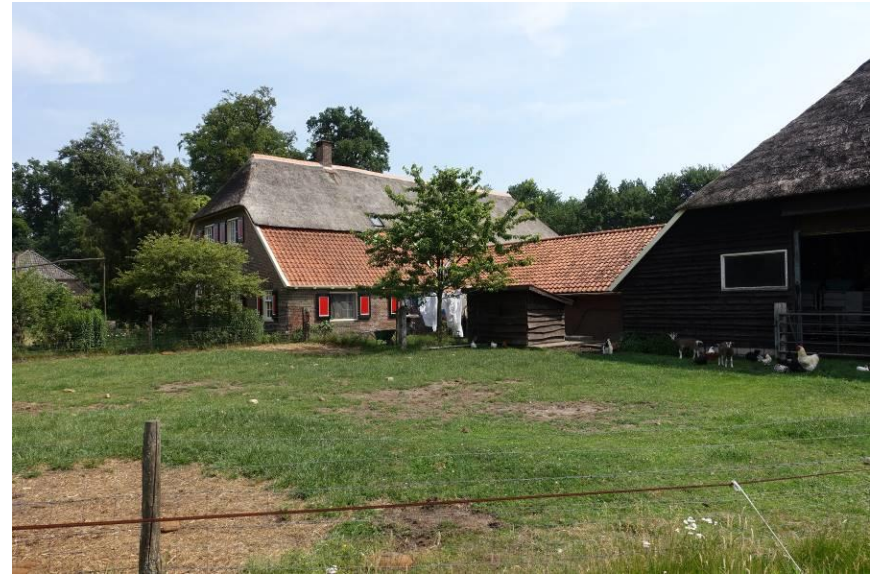
De boerderij en het schuurcomplex uit 1977 vanuit het zuidwesten gezien.
