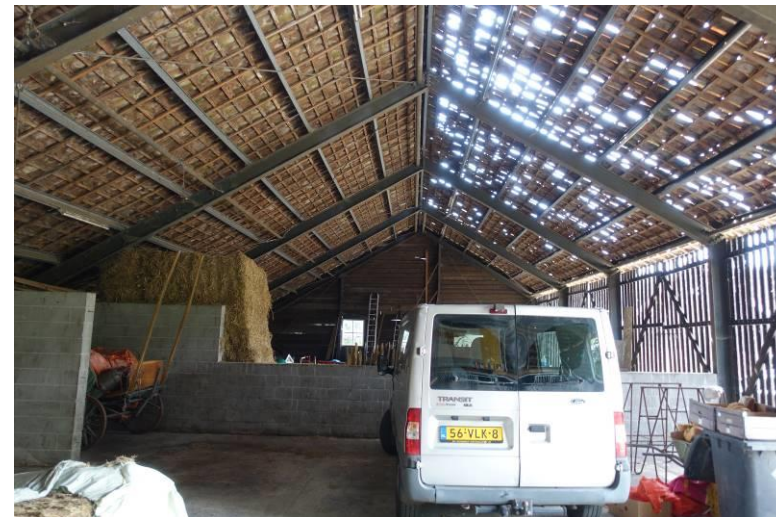
Interieur van de werktuigenloods met stalen spanten naar het zuiden gezien.
