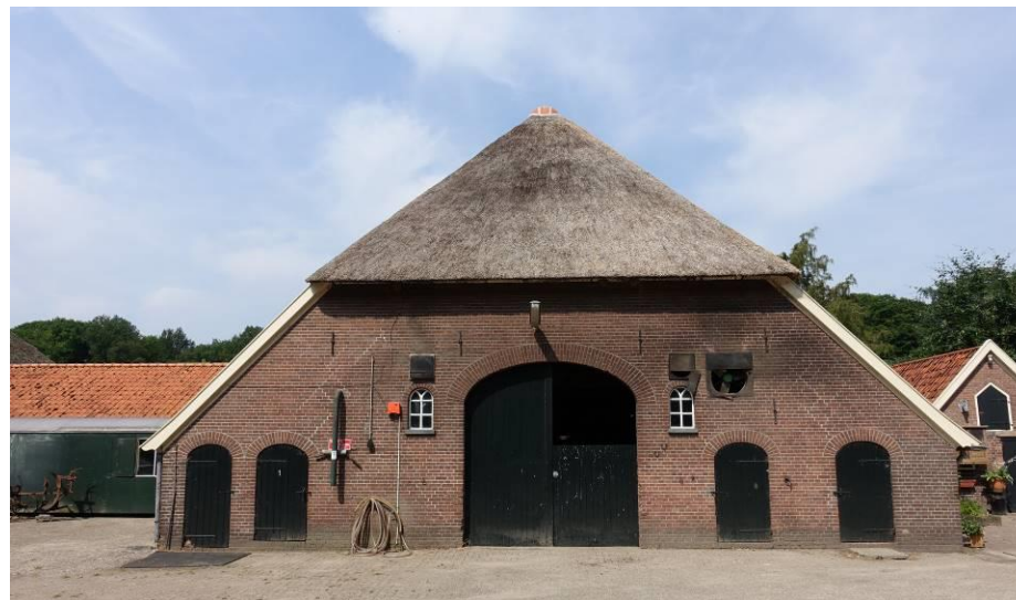
De in 1926 gebouwde achtergevel, uitgevoerd in traditionele vormen.
