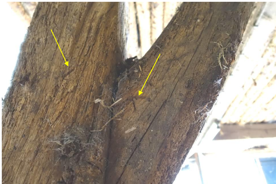
De gele pijlen wijzen naar de gehakte V (Romeins cijfer 5) op de westzijde van de noordelijke gebintstijl van het vijfde gebint.
