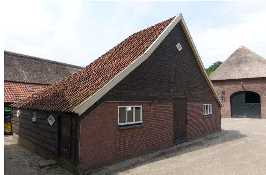
Linker zijgevel en voorgevel van de jongveeschuur.
