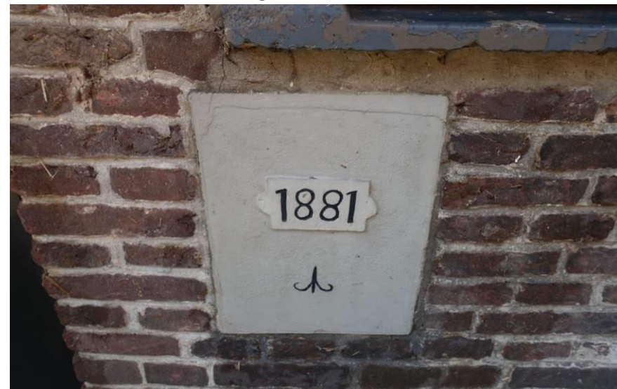
De steen met jaartal 1881 rechts van de linker mestdeur in de linker zijgevel van het bedrijfsgedeelte van de boerderij.
