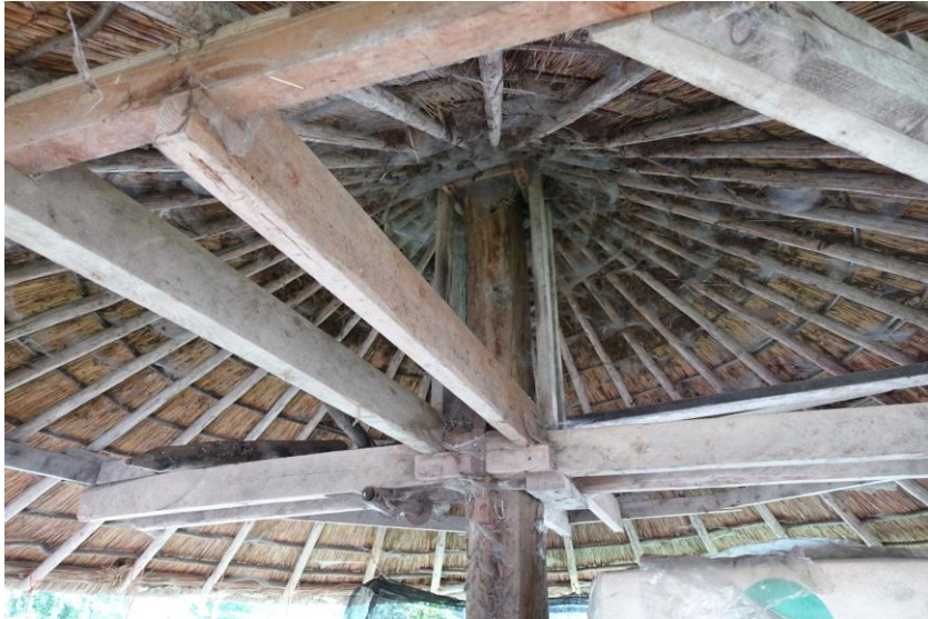
Overzicht dakconstructie van de éénroedige kapberg.
