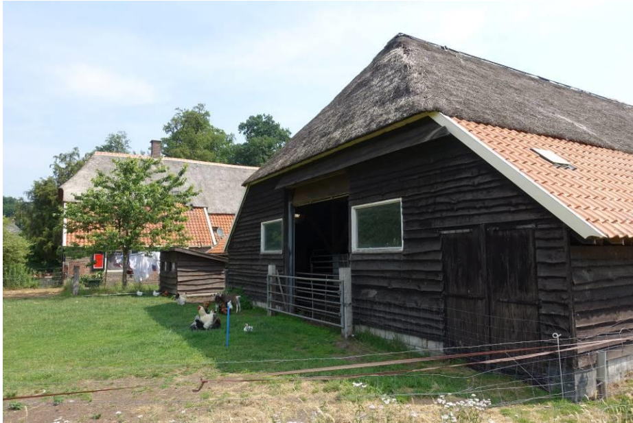
De westgevel (overzicht) van de koeienstal.
