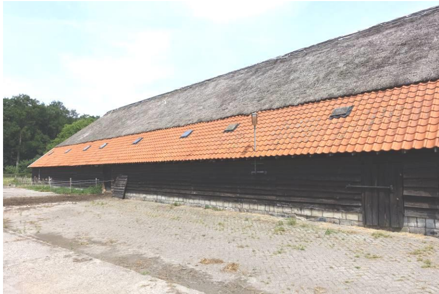
De zuidgevel (overzicht) van de koeienstal.
