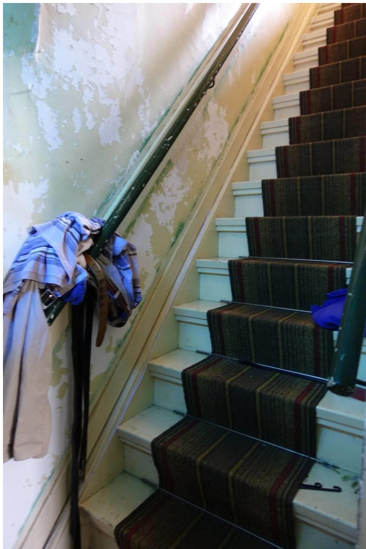
De trap naar de zolderverdieping boven het voorhuis.
