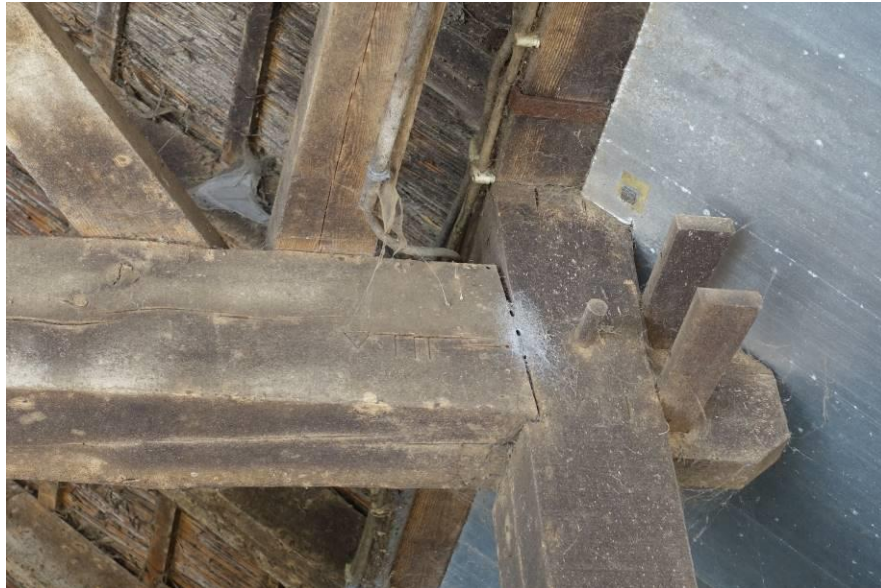
Bovendeel van gebint VIII met telmerk op de ankerbalk.
