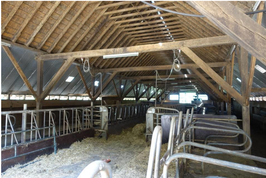
Zicht door de grote veeschuur met gebinten en sporenkap. De inrichting dateert van 1996.
