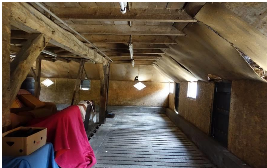
Jongveeschuur, zicht door zuidelijke zijbeuk naar het oosten. Links het oude ankerbalkgebint.
