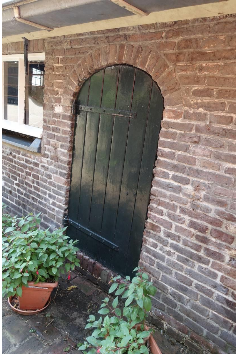
De middelste mestdeur in de linker zijgevel van het bedrijfsgedeelte van de boerderij.
