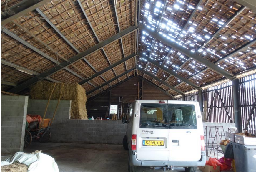
De werktuigenloods, interieur naar het zuiden gezien.
