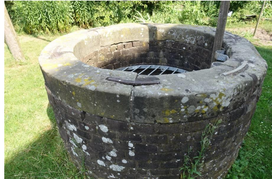
De bakstenen put met Bentheimer zandstenen bovenring.
