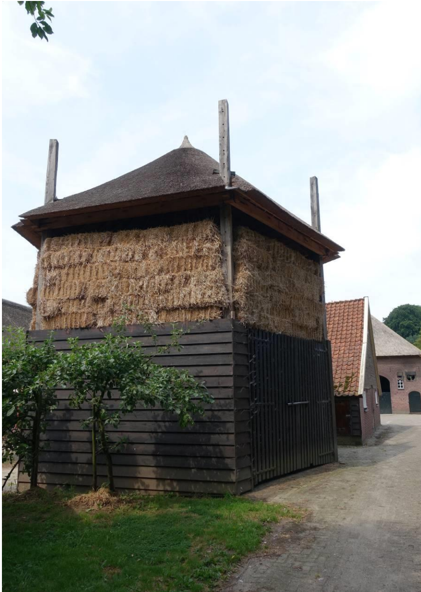
De herbouwde vijfroedige schuurberg vanuit het oosten gezien.
