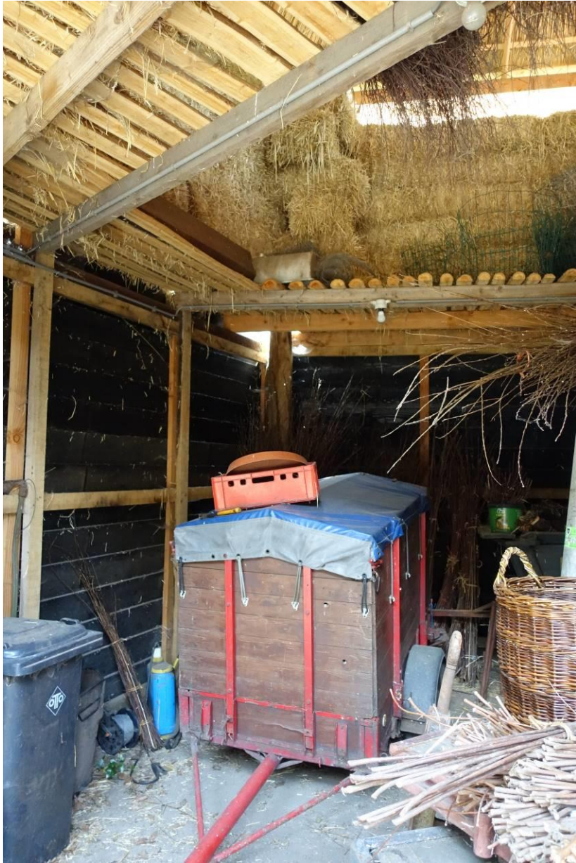
De zijwanden en rondgaande vloerconstructie in de vijfroedige schuurberg.
