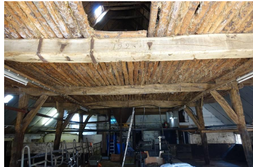
De deel naar het westen. Op de voorgrond de ankerbalk met jaartal 1926.
