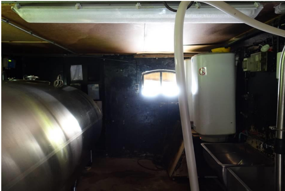
Bakhuis, zicht in de ruimte met de melktank.
