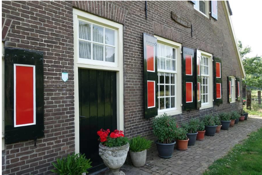
Zicht langs de onderbouw van de voorgevel (westgevel) van de boerderij.
