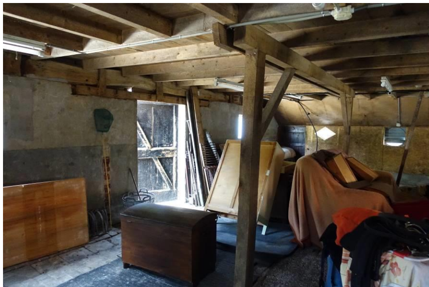
Jongveeschuur, de centrale ruimte met het jongere dekbalkgebint.
