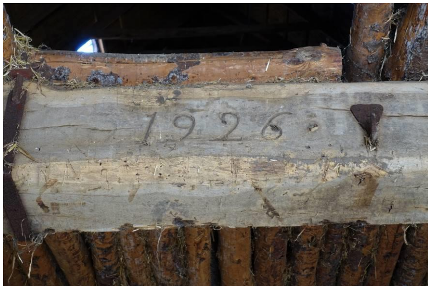
Detail van het ingekerfde jaartal 1926 in de ankerbalk.
