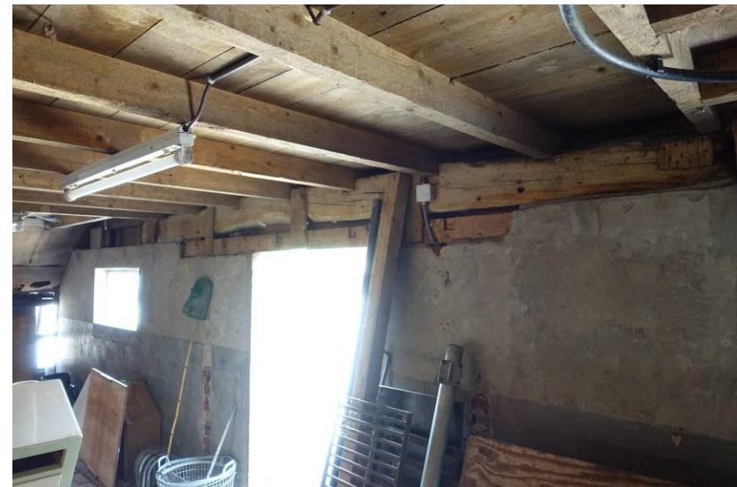
De binnenzijde van de noordelijke kopgevel van de kleine stal met boven de gepleisterde muur de behouden gebleven ankerbalk van het strijkgebint.
