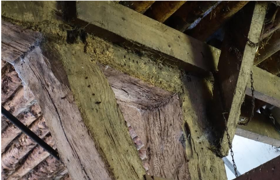
Vier gegutste ovaaltjes op de stijl, korbeel en ankerbalk van het vierde gebint.
