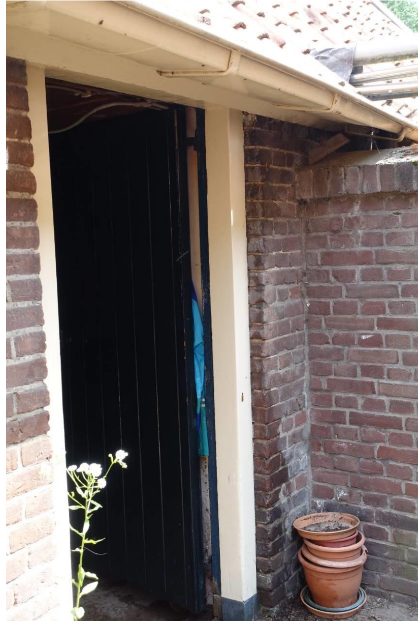
Deur in linker deel van de rechter zijgevel van het bakhuis.
