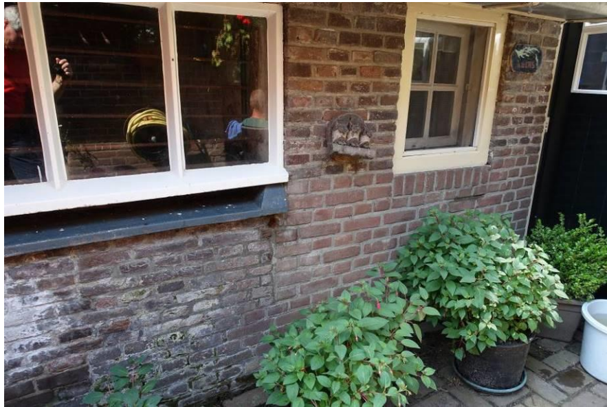
De overgang van woongedeelte naar bedrijfs gedeelte in de linker zijgevel van de boerderij, met in de jaren 50 binnen het oude gevelwerk ingeboet metselwerk.
