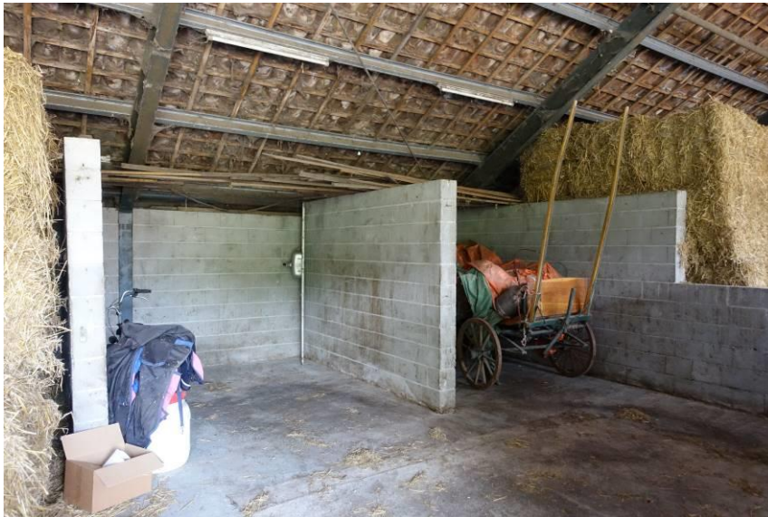
Betonstenen afschottingen aan de oostzijde in de werktuigenloods.
