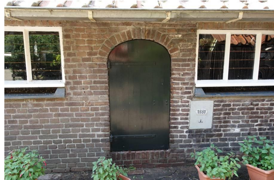
De linker mestdeur in de linker zijgevel van het bedrijfsgedeelte van de boerderij met links metselwerk van de uitbreiding van 1926.
