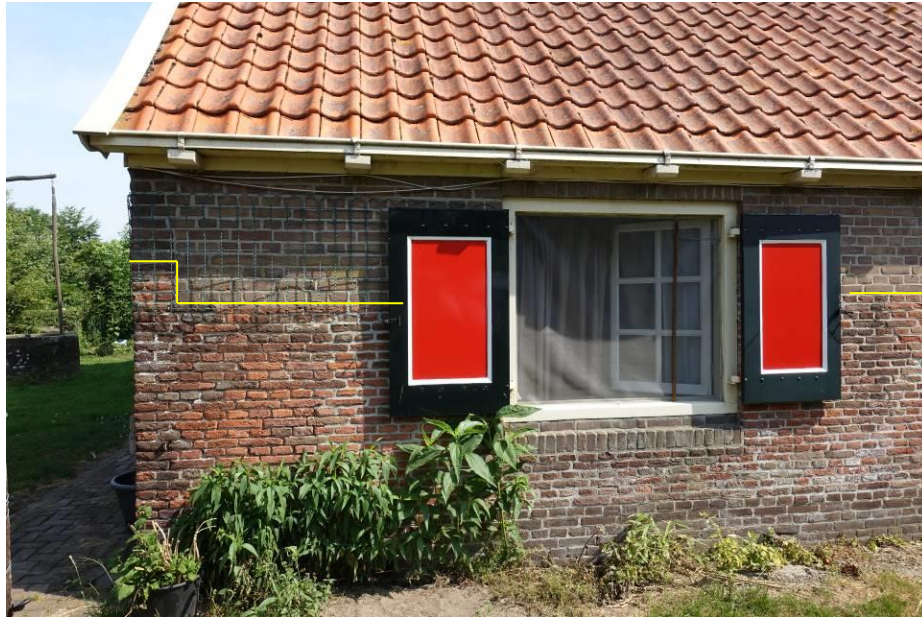
De zuidelijke zijgevel van het woongedeelte. Het metselwerk boven de gele lijn en het venster dateren uit de jaren 50. Bewerking F. Haans MAB 2017.
