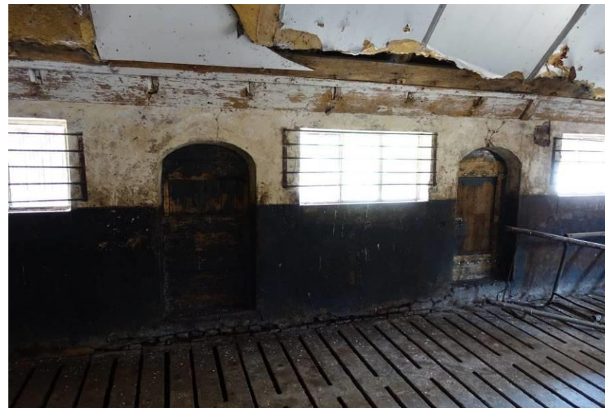
De binnenzijde van de noordgevel met grupstal en mestdeuren.
