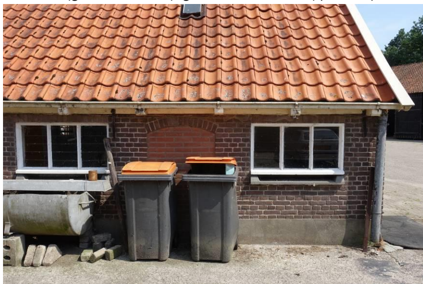
De rechter helft van de rechter zijgevel van het bedrijfsgedeelte van de boerderij.
