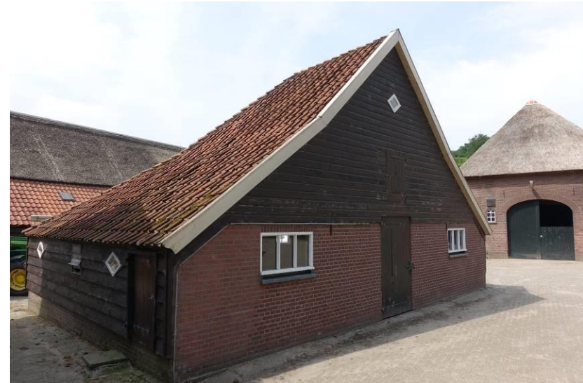
De noordelijke kopgevel van de kleine stal met in de onderste zone de naoorlogse gemetselde gevel.
