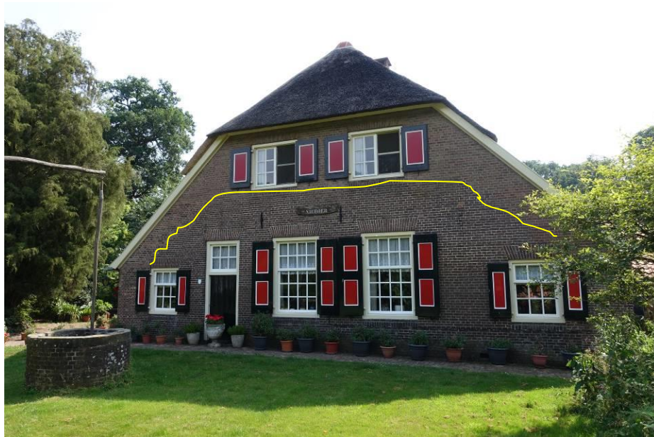
De voorgevel van de boerderij. Boven de gele lijn bevindt zich het naoorlogse metselwerk van de ophoging. Bewerking F. Haans MAB
