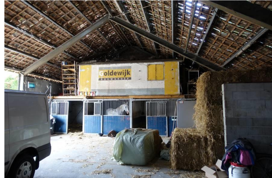
De werktuigenloods, interieur naar het noorden gezien.
