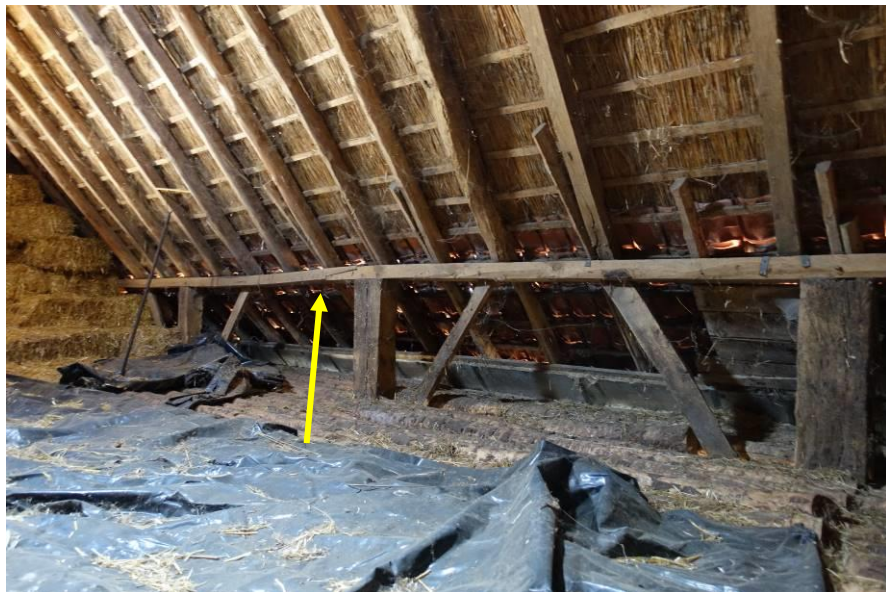
De hooizolder naar het zuidoosten gezien. De gele pijl wijst naar de overgang van het oude deel naar de uitbreiding uit 1926.
