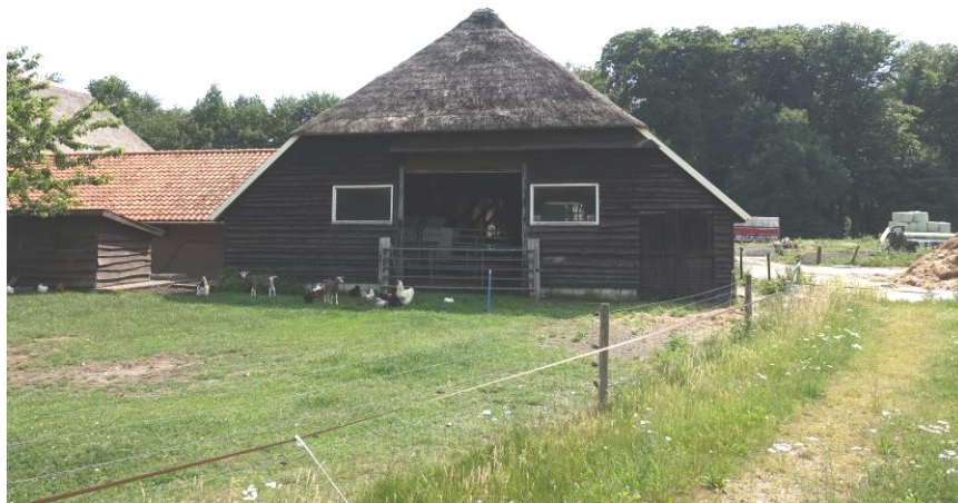
De westgevel (overzicht) van de koeienstal en links de melkstal.
