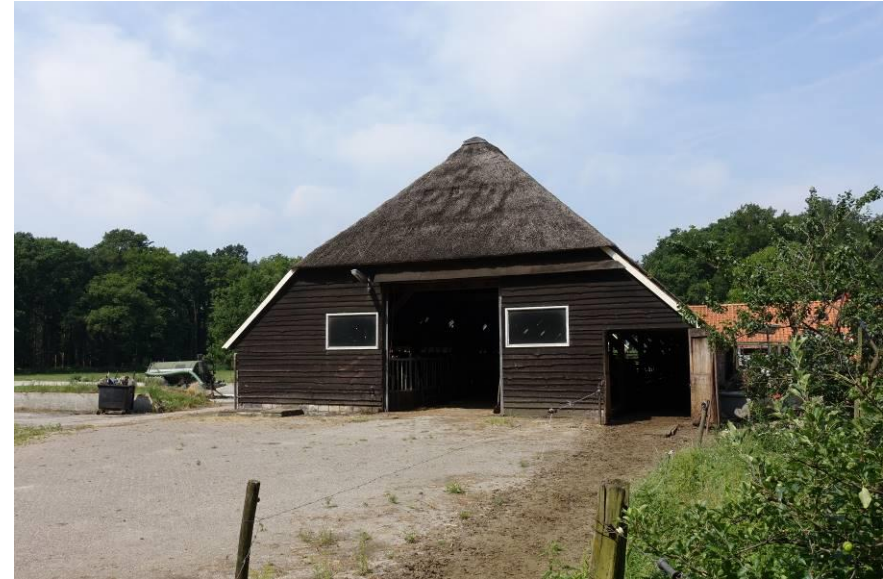
De oostgevel (overzicht) van de koeienstal.
