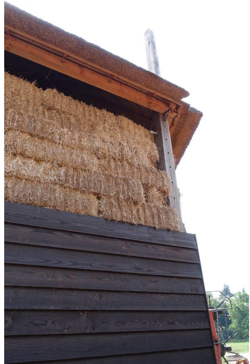
Detail van de noordwestelijke gevel van de vijfroedige schuurberg.
