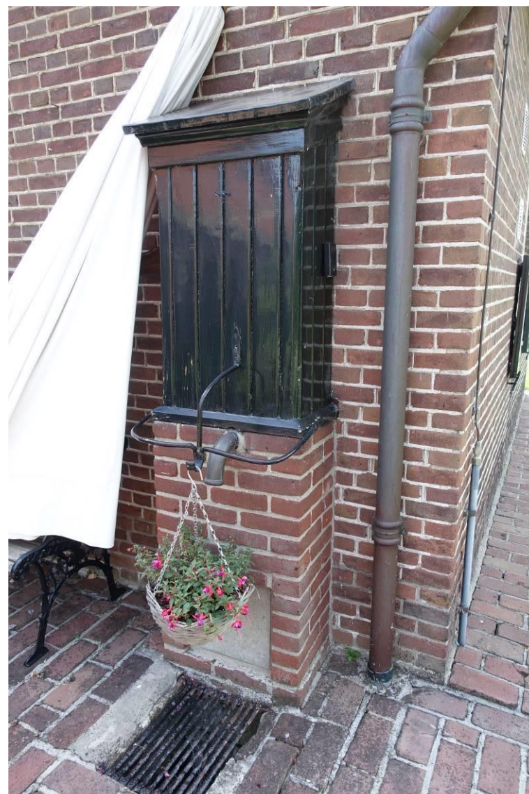
De later tegen de achtergevel van de enskamer gebouwde pomp
