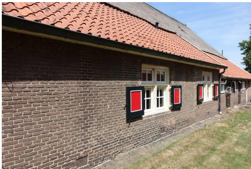
Bij het linker deel van de gevel van het voorhuis komt over de gehele hoogte ouder muurwerk voor
