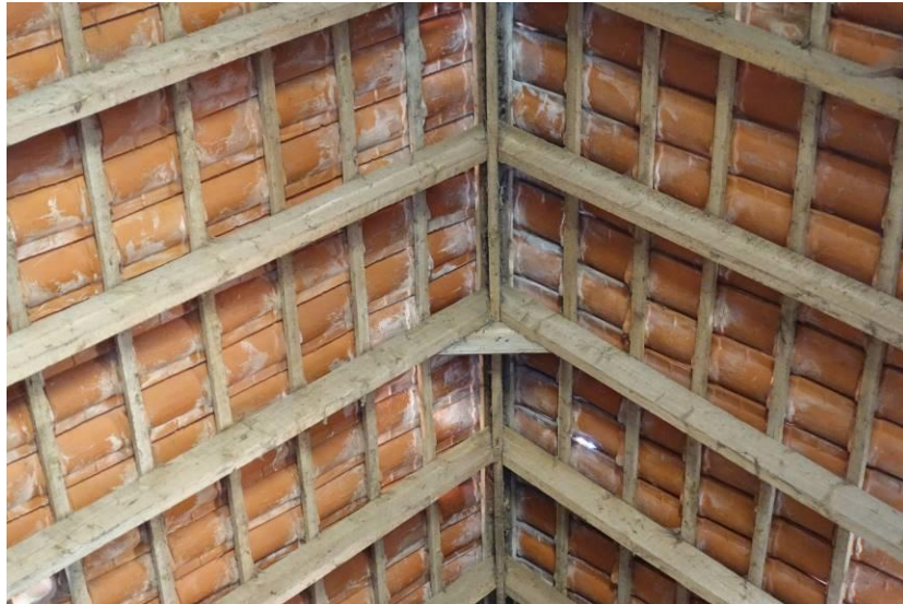
Detail aansluiting sporen in de nok
