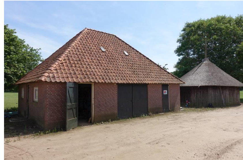
Overzicht westgevel van de garage/berging
