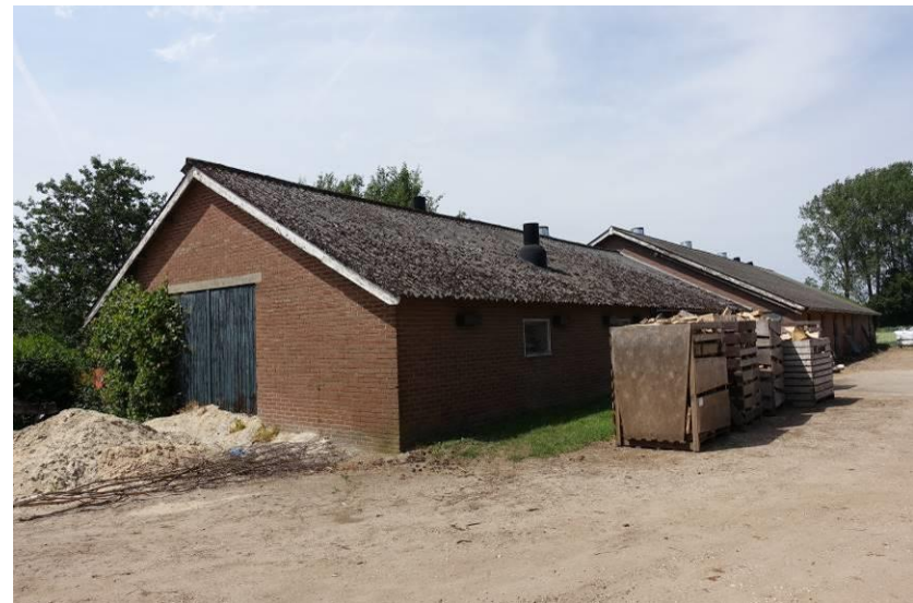
Deze in 1967 als aardappelopslag gebouwde schuur werd in 1977 volledig in gebruik genomen als varkensstal en in 1987 en 1996 uitgebreid
