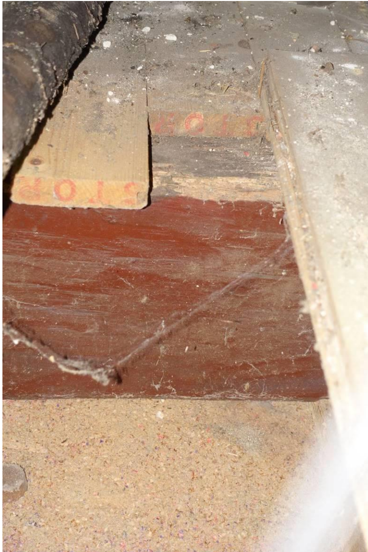
Detail van één van de ongeprofileerde balken van de verdiepingsvloer boven de voorkamer
