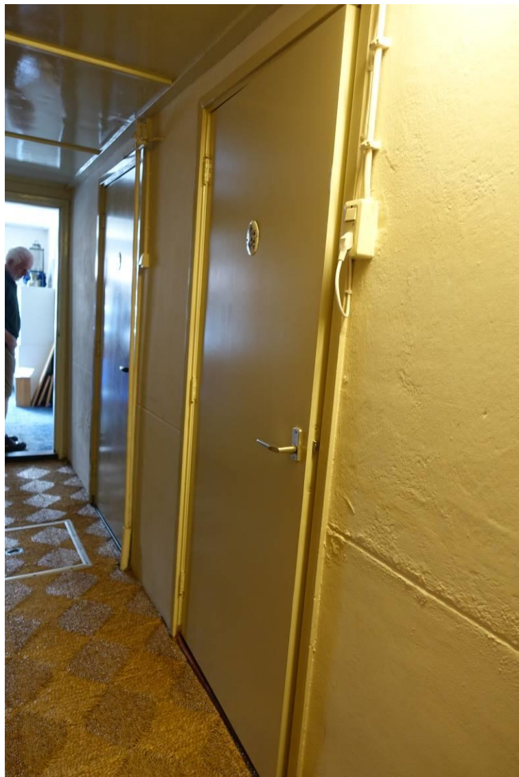
Toegangsdeuren van wc en douche in de achterwand van de dwarsgang
