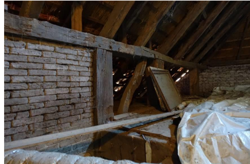
De zolder boven het voorhuis, gezien richting rechter zijbeuk met op de voorgrond de in halfsteens verband gemetselde muur
