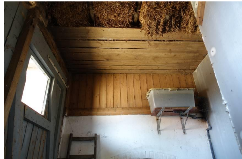
Deel van de slietenvloer van gehalveerd rondhout in het achterste gebintvak
