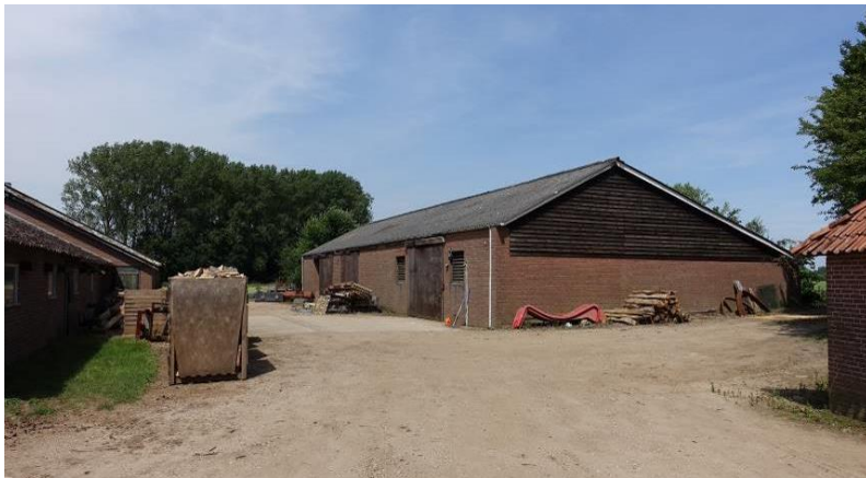
Overzicht van de in 1977 gebouwde aardappelopslag op de noordoosthoek van het erf
