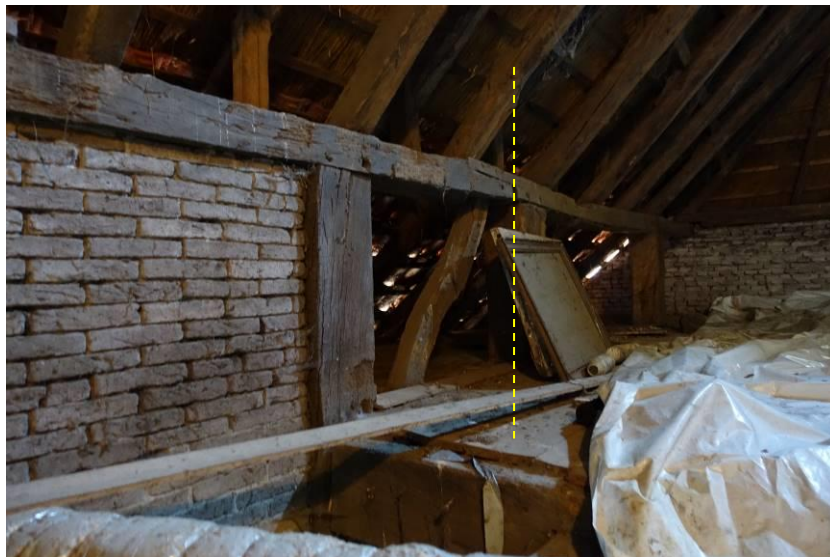
Zicht op de linkerzijde van de gebintconstructie boven het voorhuis. De stippellijn markeert de voorzijde van de (afgekapte) oudste gebintconstructie.
