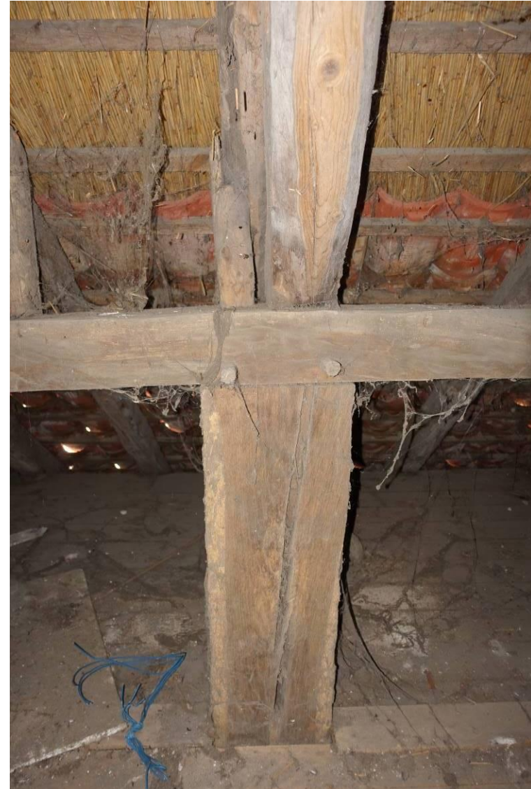
Gepende aansluiting van de gebintplaat boven het voorhuis op één van de gebintstijlen
