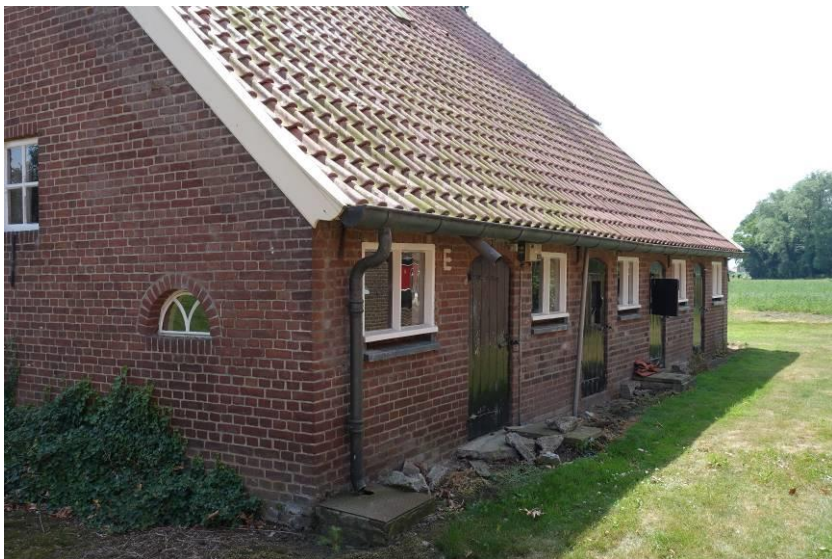
Overzicht van de naar de boerderij gerichte noordgevel
