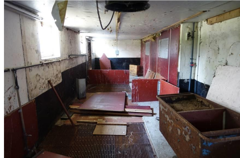
Zicht door de rechter zijbeuk richting de voorgevel
