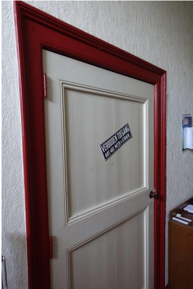
Gereconstrueerde opgeklampte deur van de opkamer in de linker gangwand
