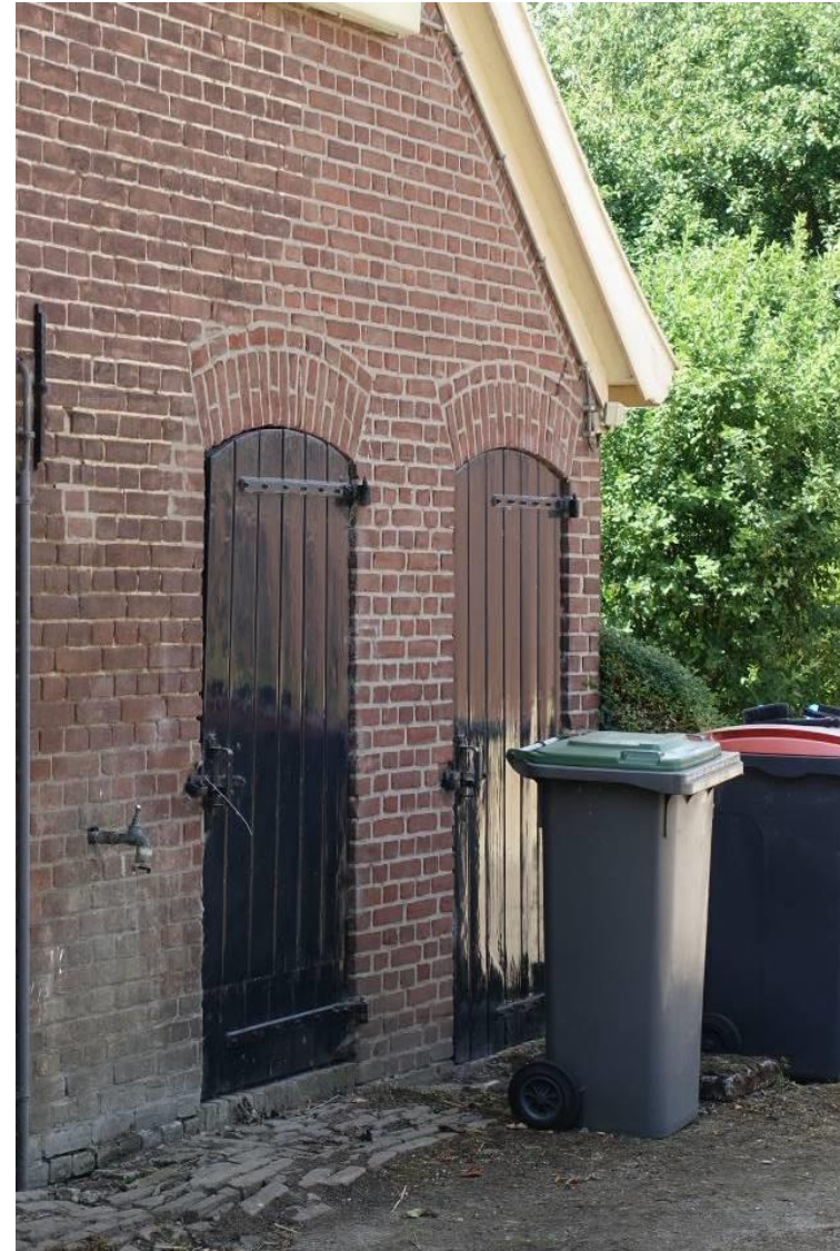
De rechter hoek van de achtergevel werd met de vernieuwing van de linker zijgevel ook vernieuwd
