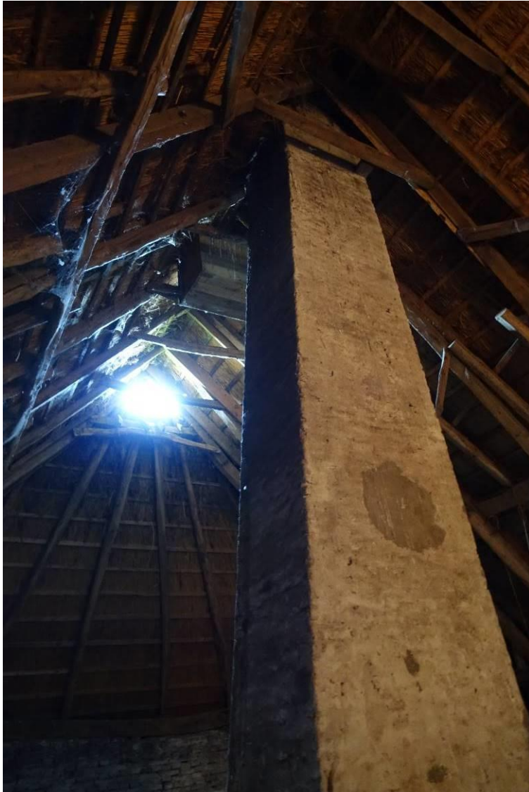
Vernieuwd rookkanaal boven de historische schouw van de voorkamer
