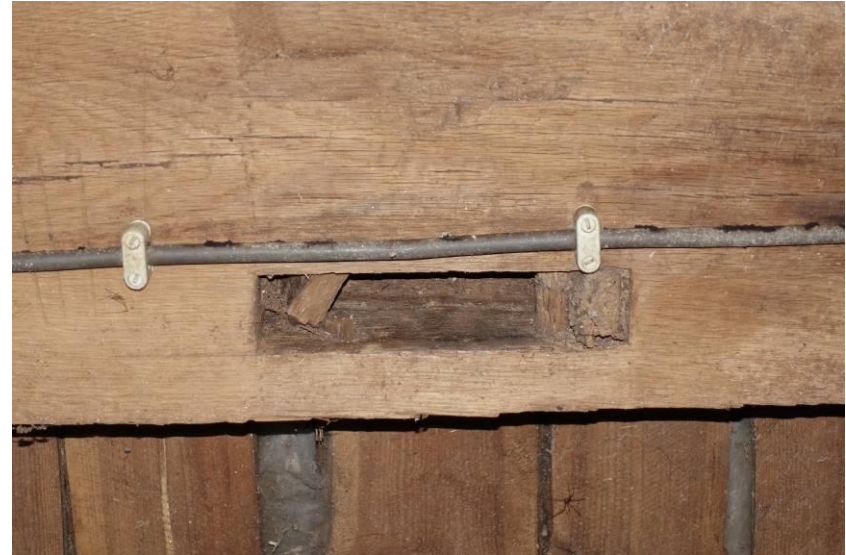
Detail van het pengat van één van de eerder onder de achterste ankerbalk aanwezige stijlen t.b.v. de aansluiting van het onderschoer
