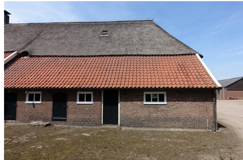
Het rechter deel van de rechter zijgevel, aansluitend op de achtergevel
