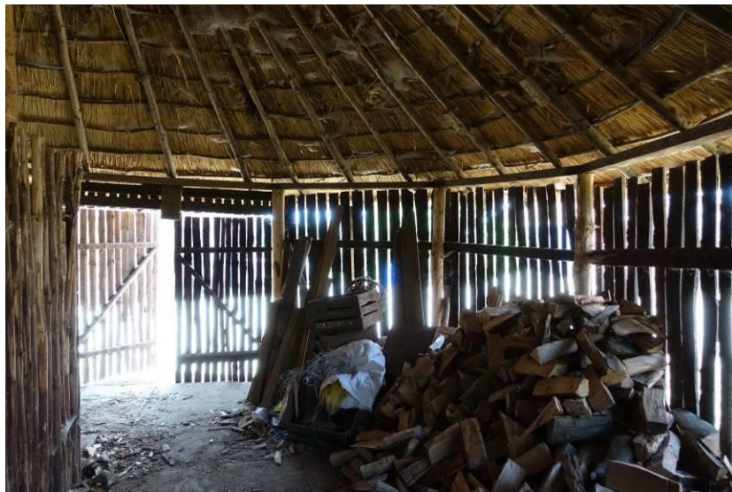
Interieur van de parapluberg
