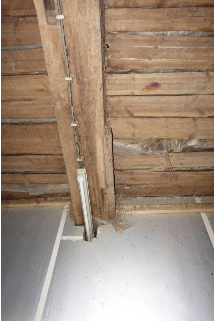
Onderzijde van de ankerbalk van het achterste gebint, met sporen van de vroegere opzet met een onderschoer en onder deze balk geplaatste deeldeuren
