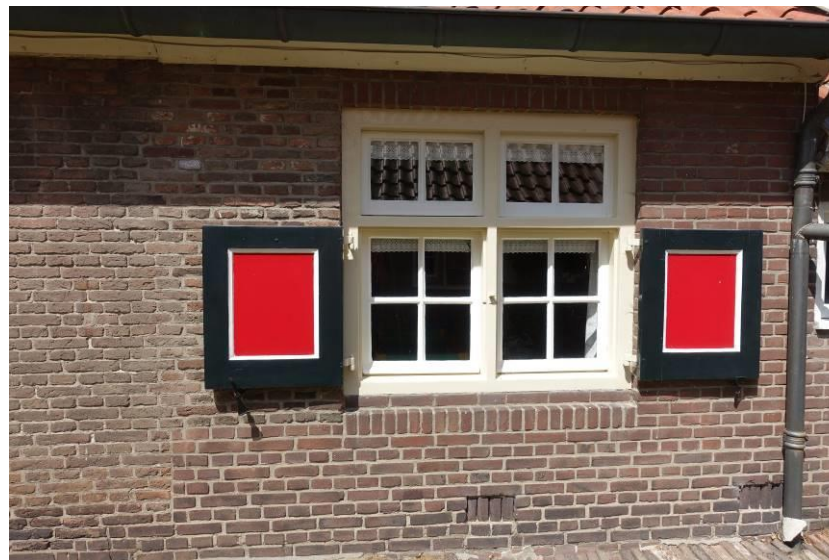
Overgang van het oudere muurwerk (links) op het vernieuwd muurwerk, direct links van het rechter venster in de voorhuisgevel
