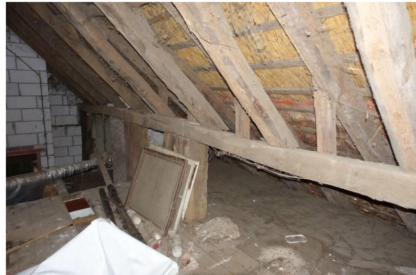
Zicht op de rechter zijbeuk van het voorhuis, met links de oudste gebintconstructie en rechts het deel dat behoort bij een uitbreiding
