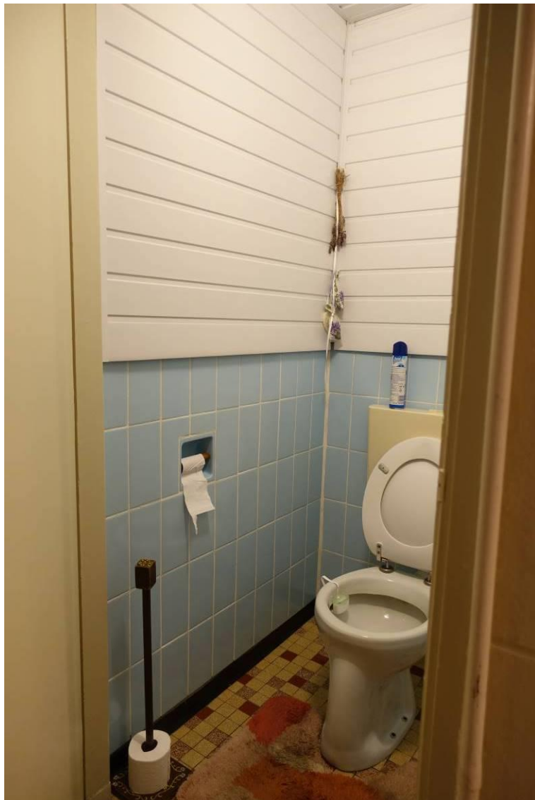
Tegelwerk en wandbekleding van toilet
