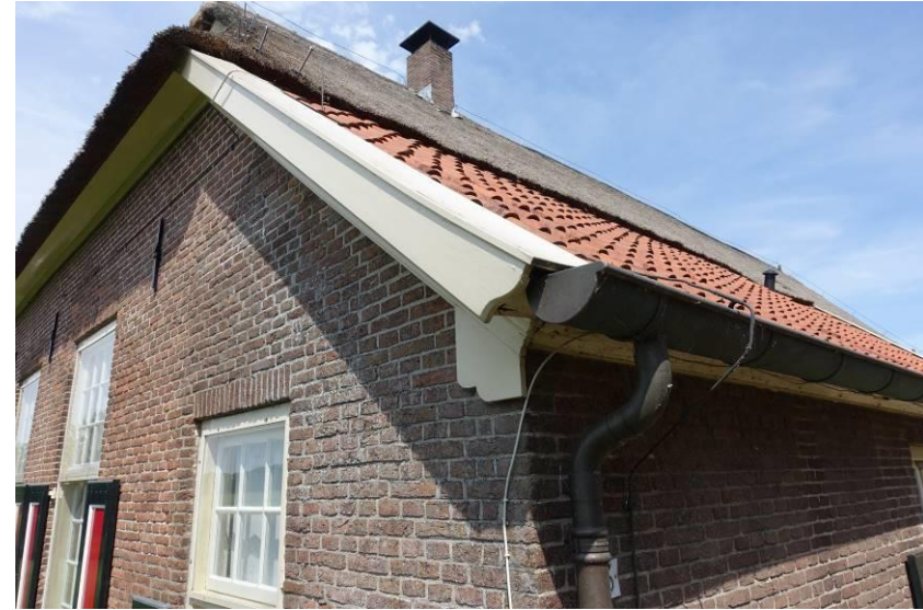
Detail van de rechter voorhoek van de boerderij. Bij het metselwerk zijn hier klezoren in het hoekverband toegepast
