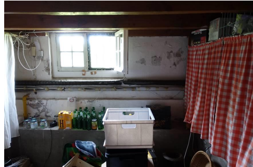
Overzicht voorwand kelder
