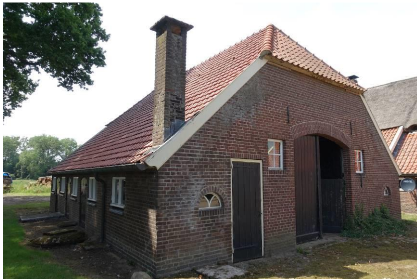
Zicht op de zuidoosthoek van de middenlangsdeelschuur
