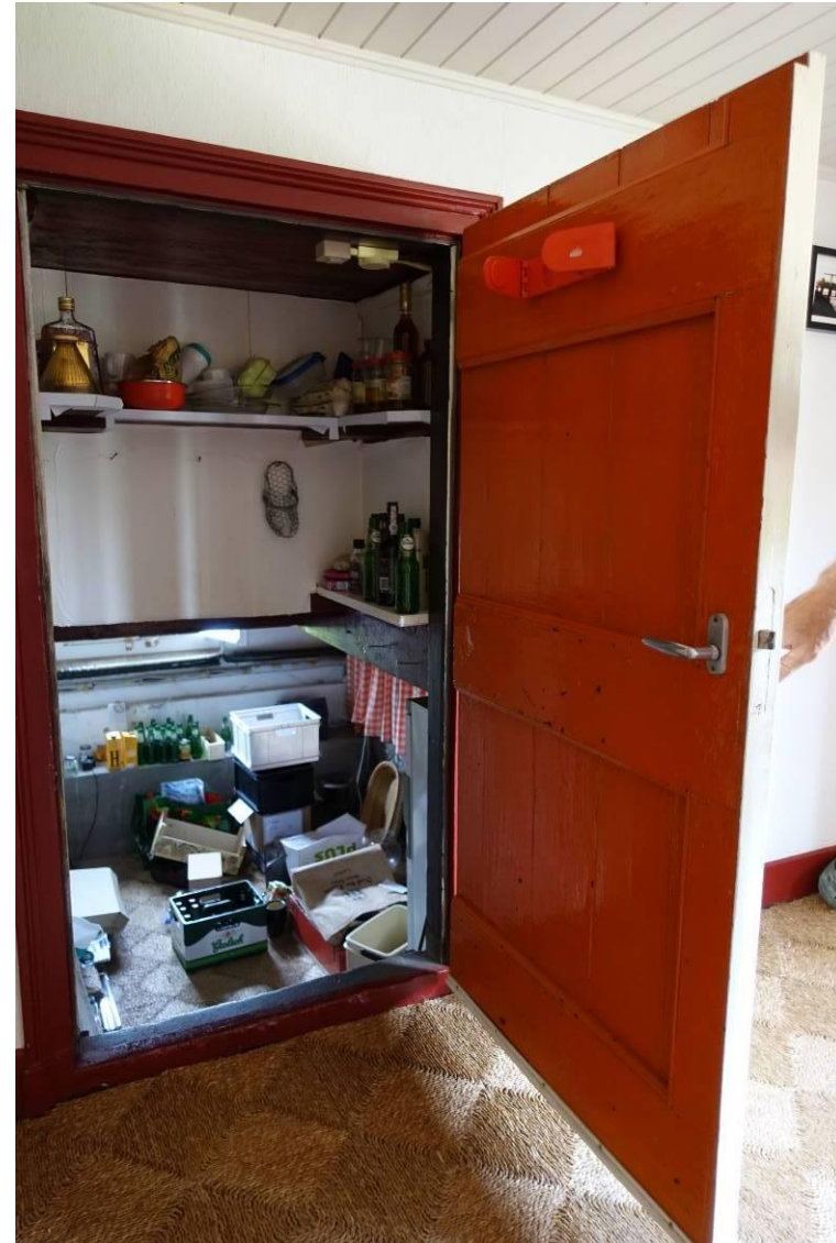
Vermaakte opgeklampte deur voor keldertoegang vanuit hal
