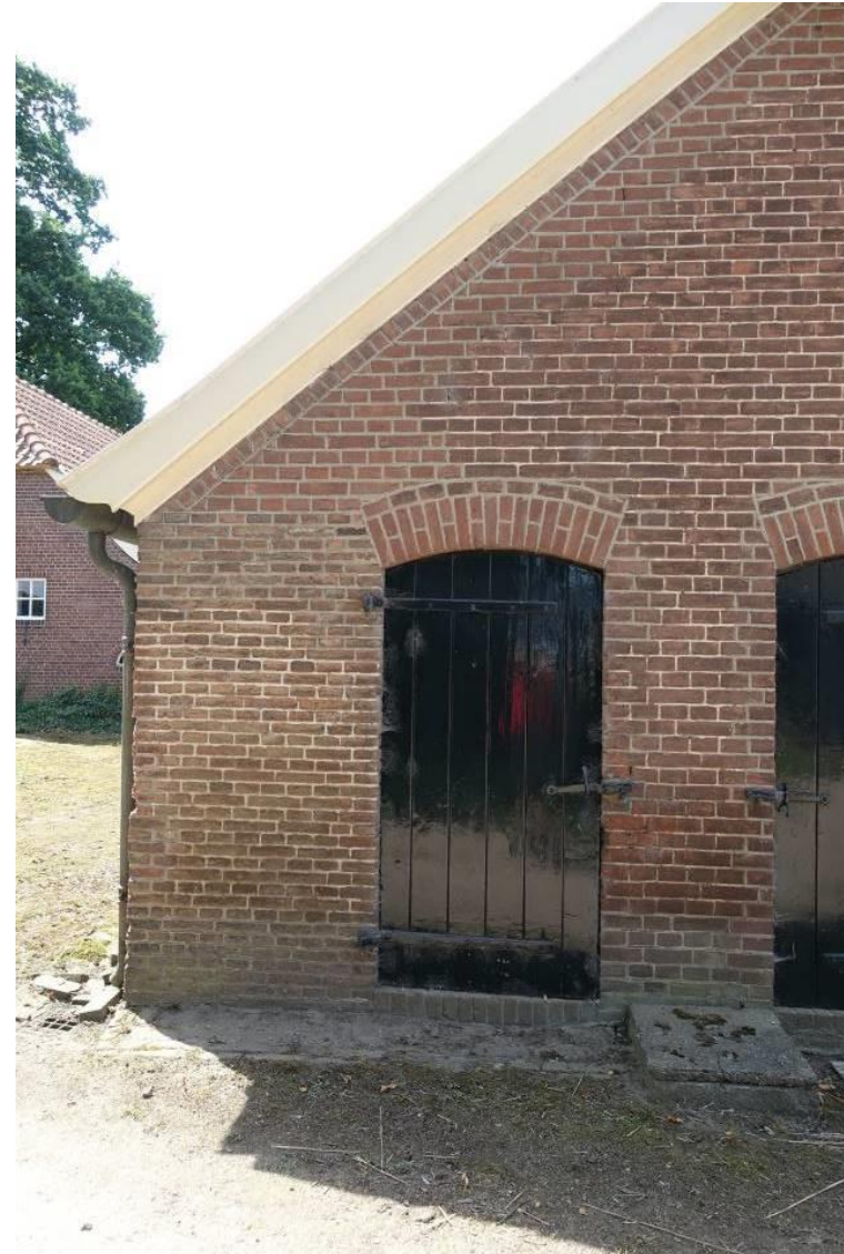
Linker gevelhoek van de achtergevel, waar in de onderzone ouder muurwerk bewaard is gebleven
