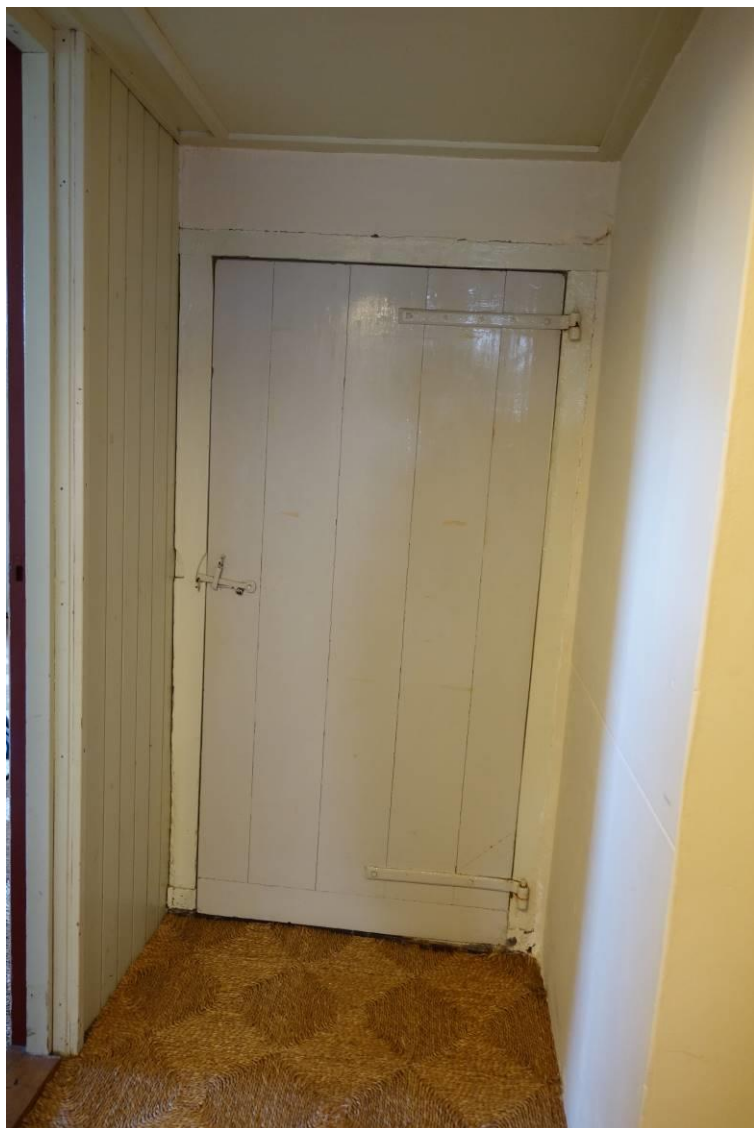
Oudere opgeklampte deur naar trapogang knechtenkamer
