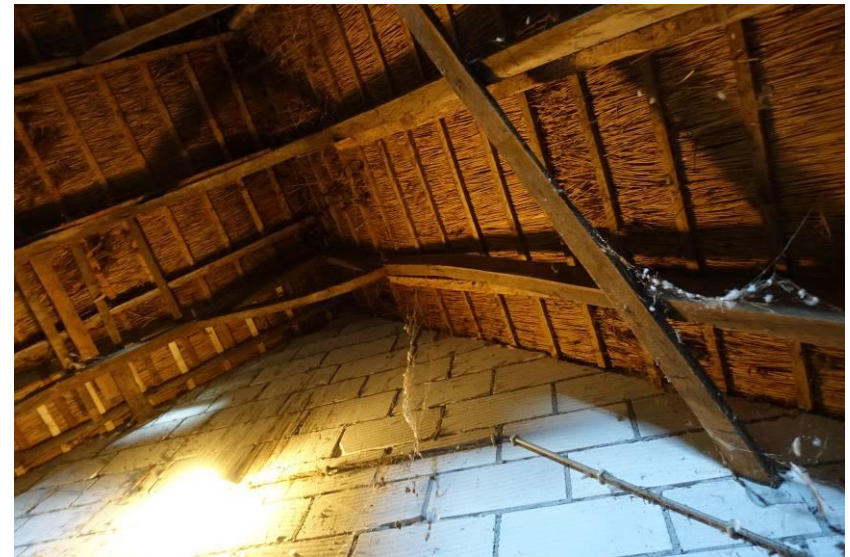
De in gasbetonblokken gemetselde scheidingsmuur tussen woongedeelte en bedrijfs gedeelte
