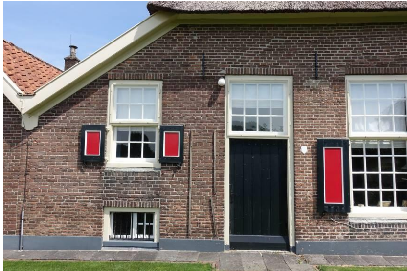
Linker deel van de voorgevel met ter plaatse van de opkamer vernieuwd metselwerk
