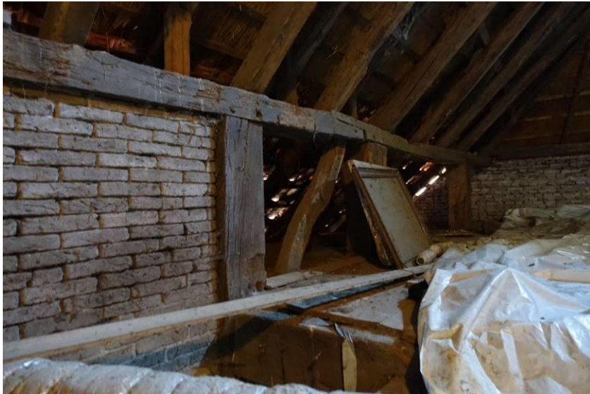
De midden op de foto zichtbare gebintstijl bevindt zich ter hoogte van de brandmuur en was eerder waarschijnlijk de voorste stijl binnen de voorgevel
