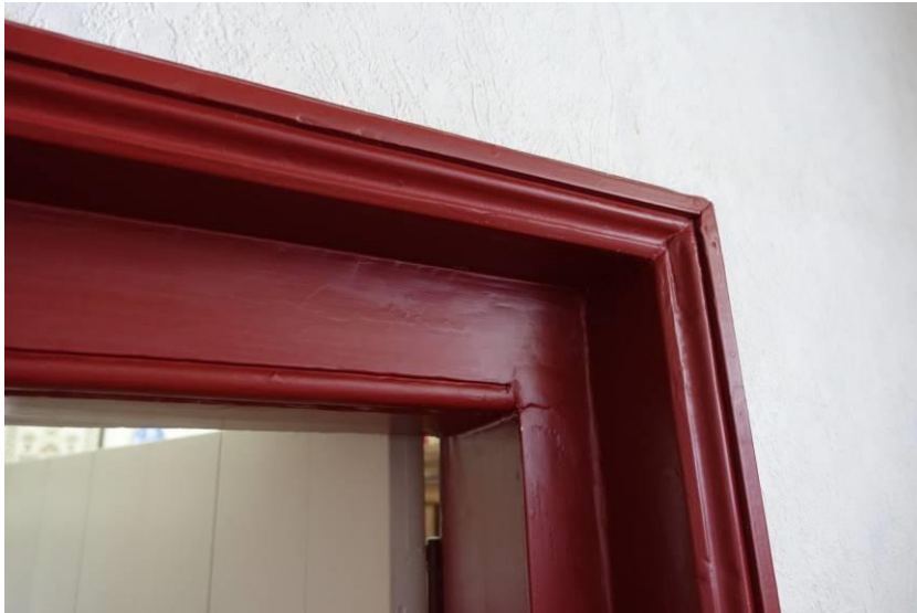
Detail omlijsting deurkozijn van de voorste slaapkamer
