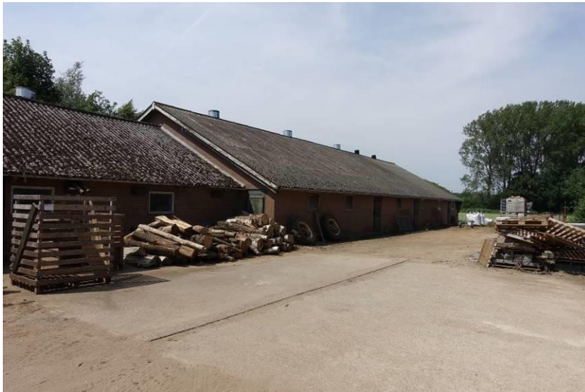
Overzicht van de varkensstal met het deels met Stelconplaten verharde terrein ten oosten van deze stal
