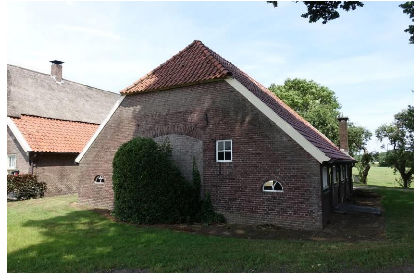
Overzicht westgevel van de middenlangsdeelschuur
