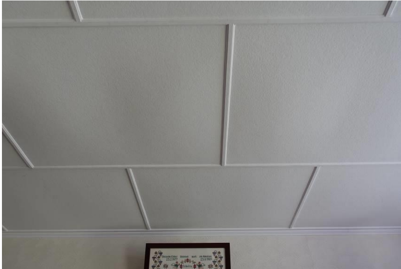
Plafond van zachtboardplaten boven de voorkamer
