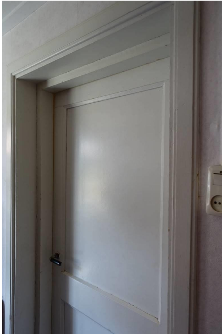
Opgeklampte deur met profilering als 'Bruynzeeldeuren'.
