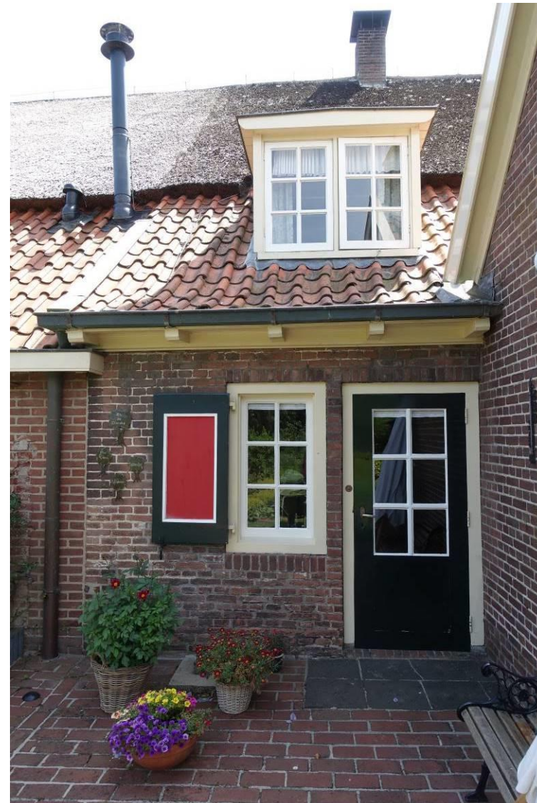
Deel van de linker zijgevel van het woongedeelte, direct achter de aangebouwde enskamer
