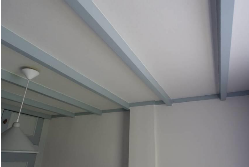
Jonge balklaag boven opkamer. Deze heeft geen constructieve functie
