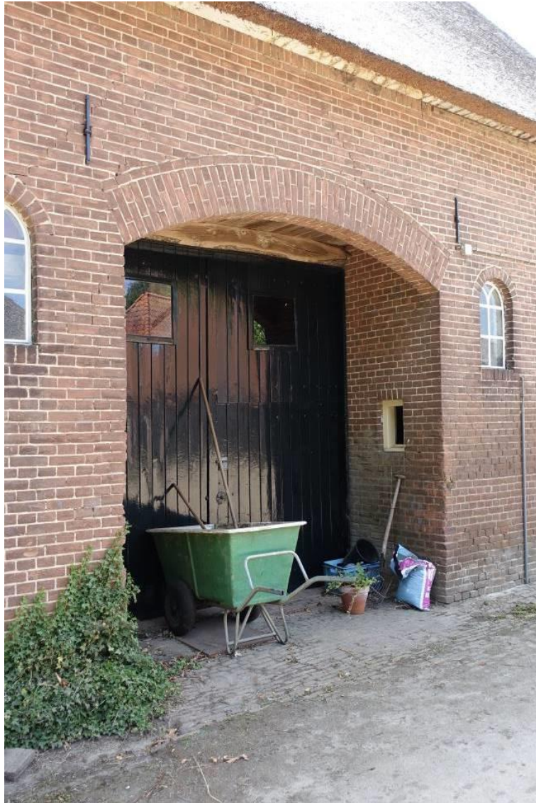
De huidige, uit de late 19 de eeuw daterende opzet met deeldeuren in een ondiep portaal is een latere variant van het onderschoer
