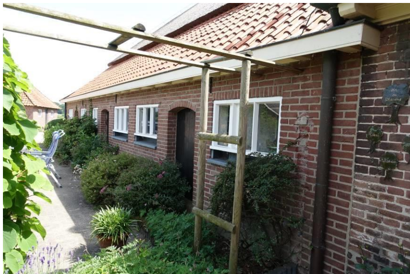
Overzicht van de geheel vernieuwde linker zijgevel van het bedrijfsgedeelte
