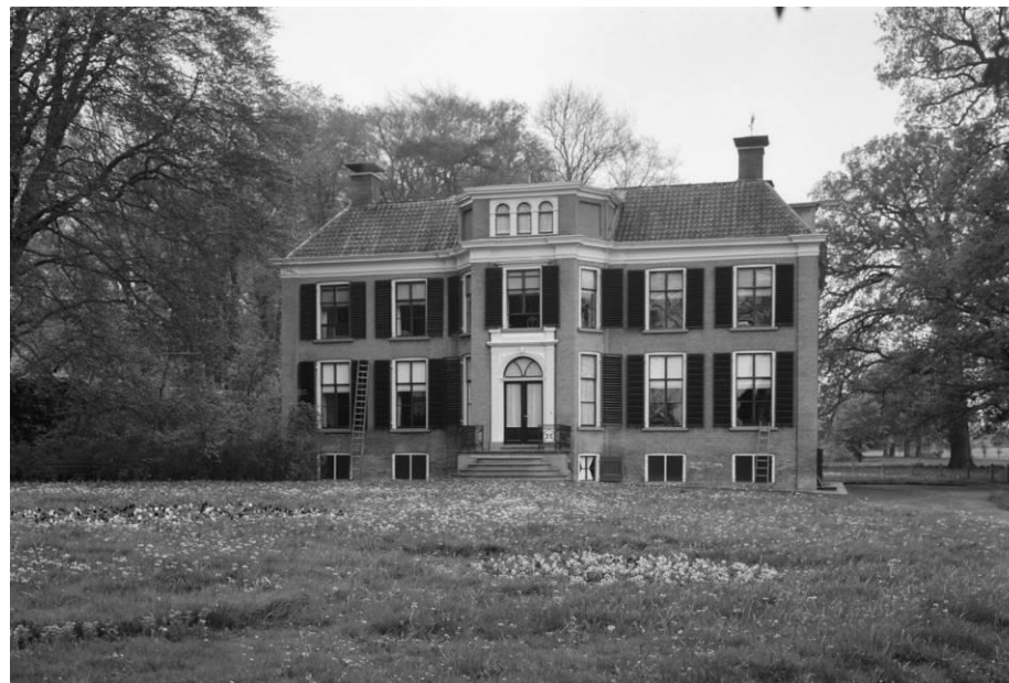
Het huis en voorplein gefotografeerd door G. Dukker in 1963 ten behoeve van de opname in het register van beschermde monumenten. Beeldbank RCE
