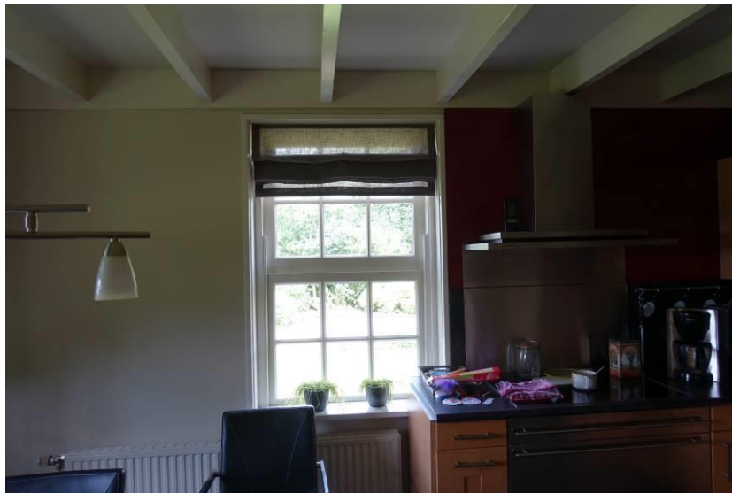
Vernieuwde enkelvoudige balklaag boven de begane grond van de enskamer
