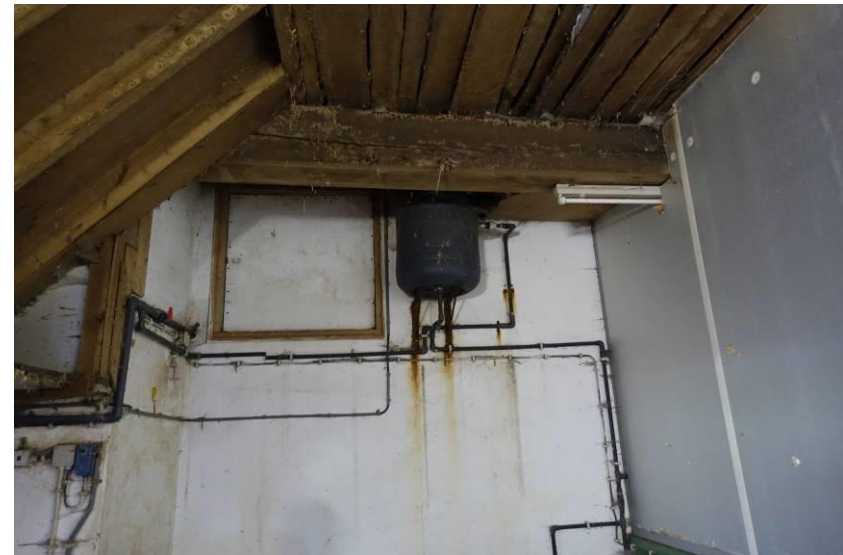
Scheidingsmuur tussen woongedeelte en bedrijfs gedeelte met direct onder de ankerbalk het toegangsluik tot de zolder boven het woongedeelte
