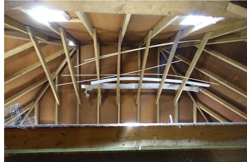
Overzicht dakconstructie van de garage/berging
