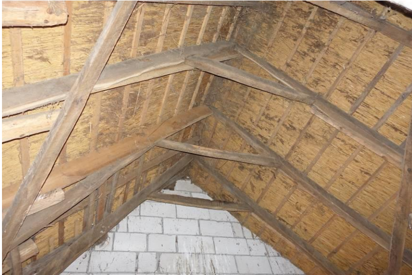
Eiken sporen met gepende haanhouten boven het voorhuis
