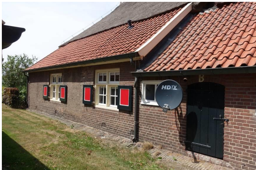
Middendeel van de rechter zijgevel met zowel bij het voorhuis als het achterhuis in de 20 ste eeuw vernieuwd muurwerk
