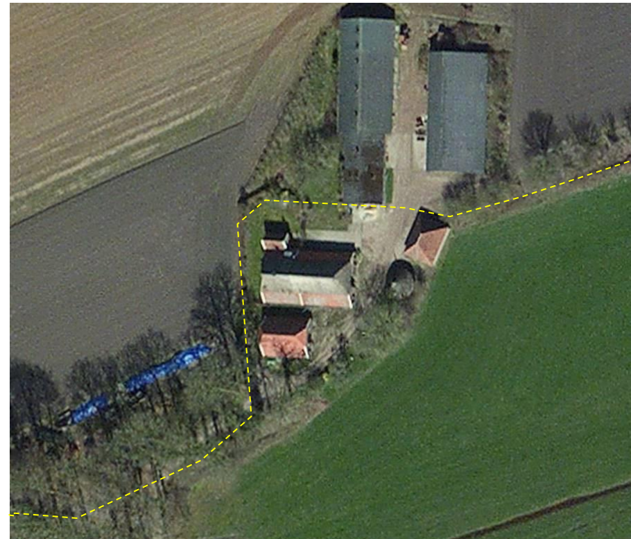
Overzicht van het erf van boerderijcomplex Scholten, met aan de zuidzijde het noordelijke uiteinde van de Velhorst, de hoofdlaan van het landgoed, die eindigt bij de boerderij. De stippellijn markeert de begrenzing van het beschermde complex. Alle binnen dit complex gelegen bouwwerken hebben ook een individuele monumentenstatus. Bron: Bing.com/maps
