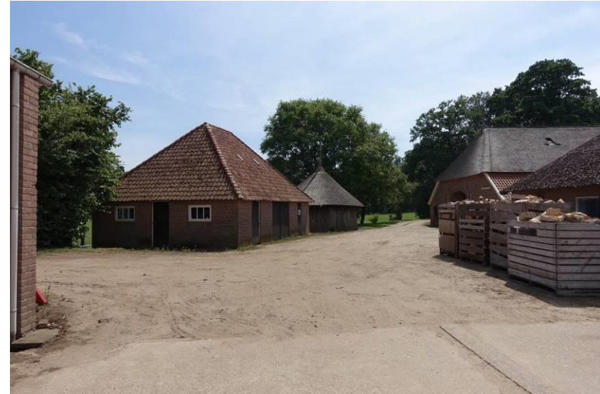
Overzicht vanaf het noordelijke deel van het erf in zuidelijke richting met centraal de garage/berging en parapluberg
