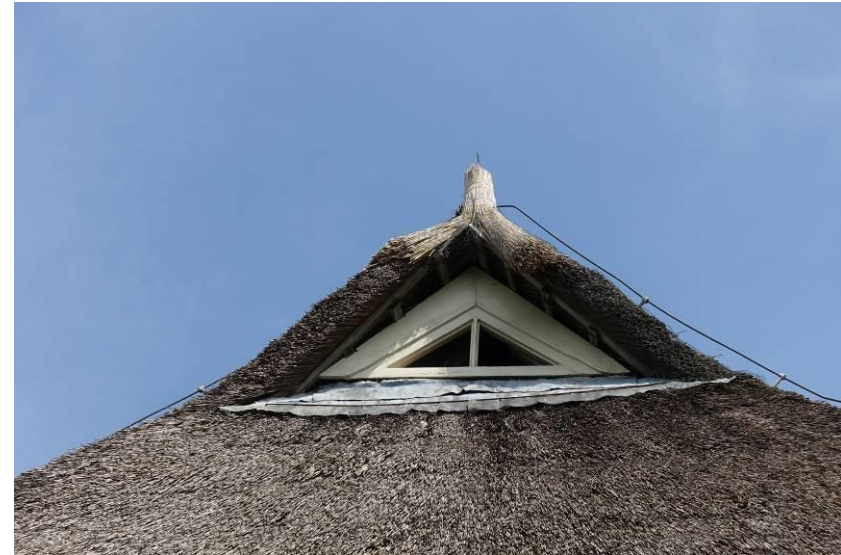
Detail nokeind boven de voorgevel, met hier aanwezig uilengat.
