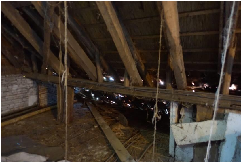
Bij de linker zijbeuk is een overeenkomstige uitbreiding van de constructie herkenbaar
