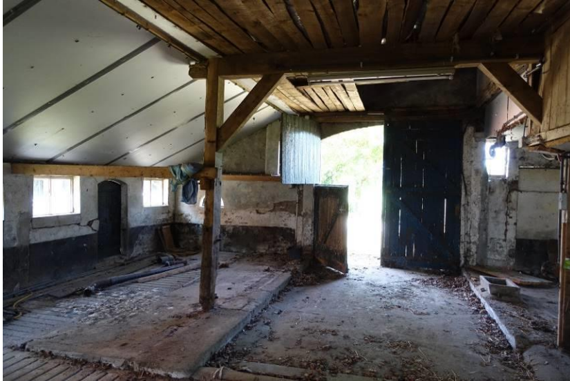
Overzicht interieur richting westgevel. Aansluitend op de deeldeuren is nog een deel van de oorspronkelijke deelvloer bewaard
