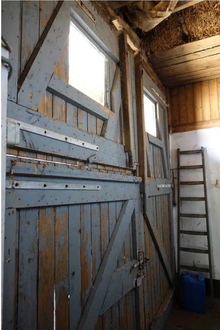
Overzicht vernieuwde deeldeuren (XXc)
