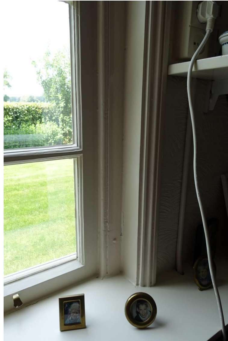
Detail omlijsting en vernieuwde vensterbank voorkamervenster
