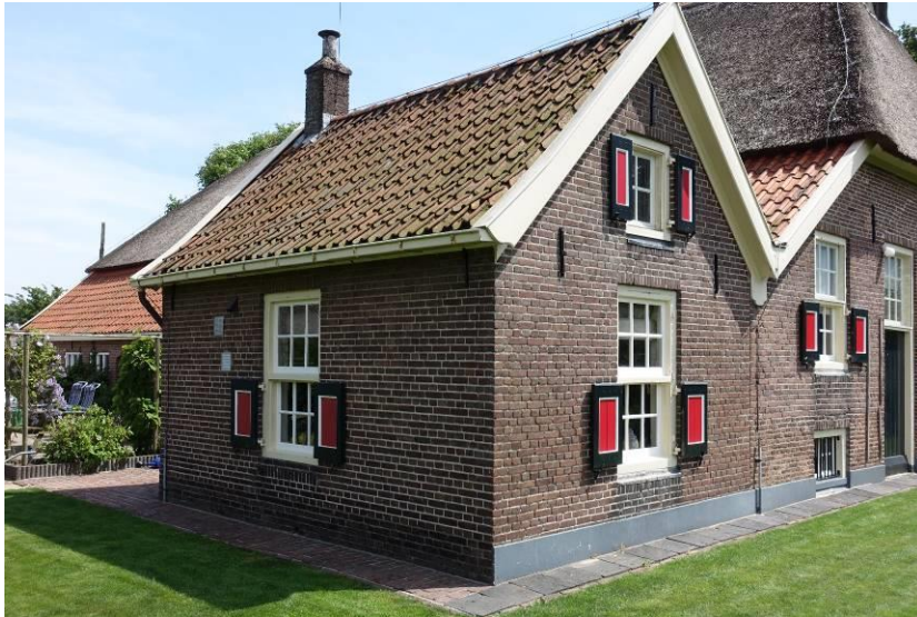
Overzicht voorgevel en linker zijgevel van de enskamer
