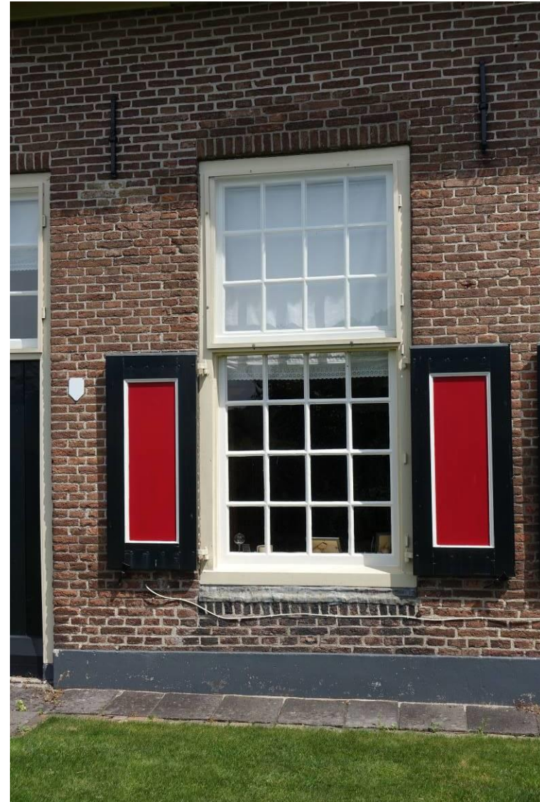
Detail van één van de opkamervensters. De huidige vensters zijn later in het oudere muurwerk ingevoegd
