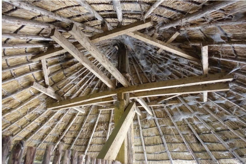
Overzicht dakconstructie van de parapluberg
