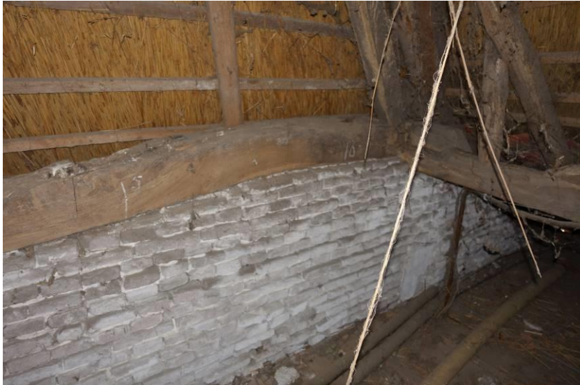
De behoorlijk onregelmatig gevormde muurplaat boven de voorgevel doet hergebruik van een onder onderdeel vermoeden
