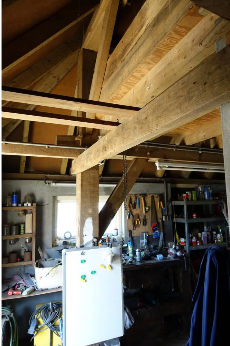
Zicht op de ankerbalkgebintconstructie van de garage/berging
