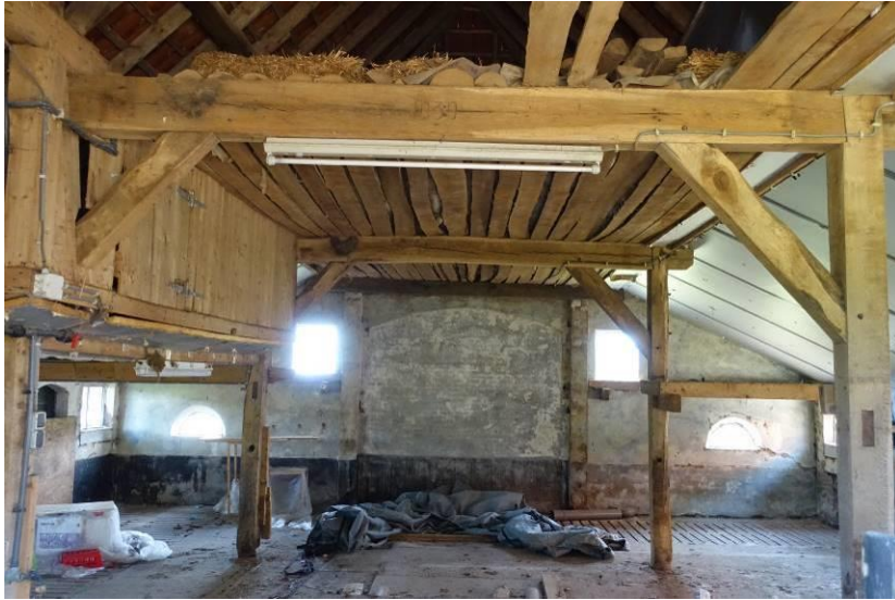
Overzicht van de ankerbalkgebintconstructie richting de westgevel
