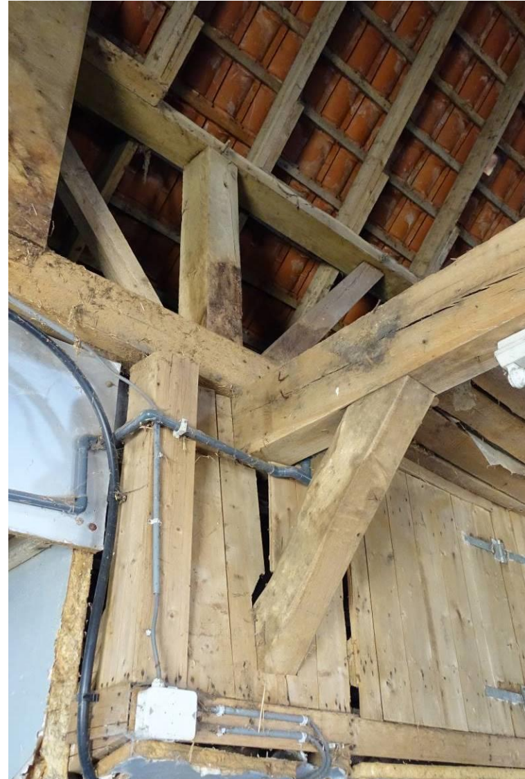
Detail van de oostelijke gebintstijl aan de zuidzijde
