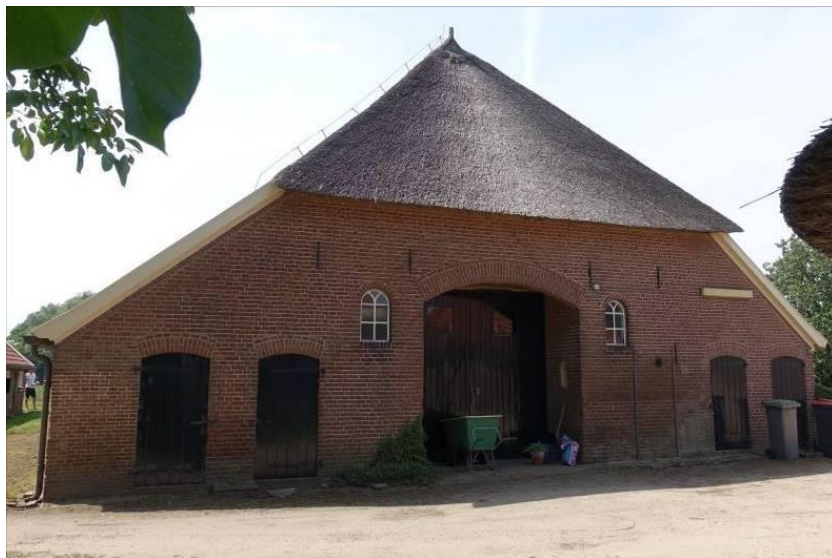
Overzicht van de achtergevel
