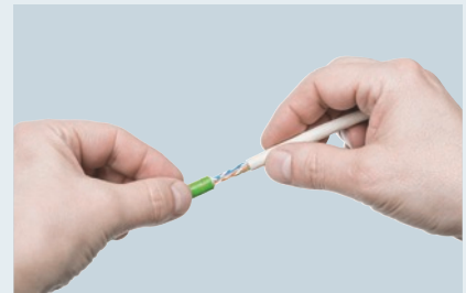
Außenmantel abnehmen und Geflechtschirm freilegen
