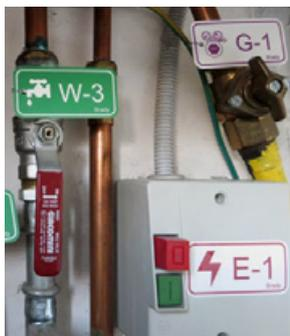
Las etiquetas para fuentes de energía se pueden usar para marcar los puntos de control de las fuentes de energía de sus instalaciones. Estas etiquetas ayudan a que el proceso de bloqueo sea más rápido, seguro y fácil.
