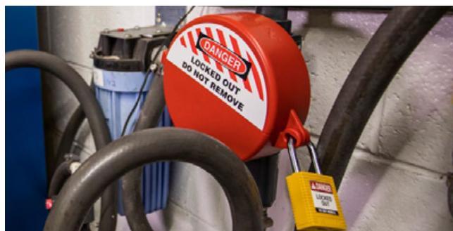
Ce dispositif de condamnation monobloc réglable permet un bon ajustement lors de la condamnation de vannes à boisseau sphérique avec poignée en T sur les tuyauteries en PVC.
