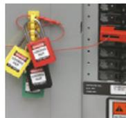
4. En cas de consignation de groupe, faites passer la clé par plusieurs boucles du rail de verrouillage et installez les cadenas. Aucune mâchoire n'est nécessaire ! (Non recommandé pour une utilisation avec des mâchoires à plusieurs cadenas.)
