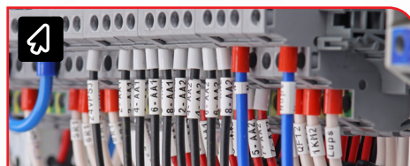
Empalmes y terminales de cable
