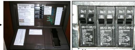
Sicherungskasten mit Schutzschaltern
