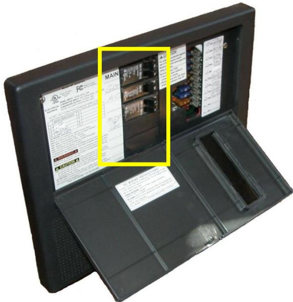
Jedes Wohnmobil hat einen Sicherungskasten welcher sich im Schlaf- oder Wohnzimmer befindet. Er enthält eine Reihe von 120 Volt Schutzschaltern. Falls ein elektrisches Gerät nicht mehr funktioniert, prüfen Sie erst die Schutzschalter.
