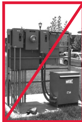
Puntal y tablero
