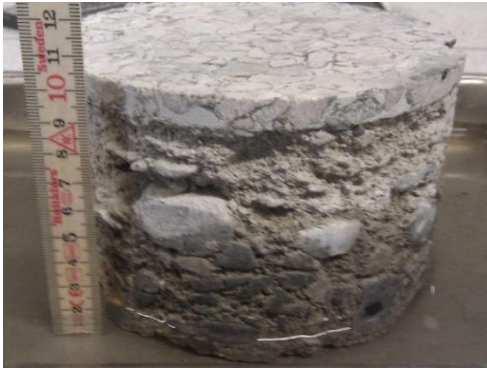
Figur 18 bärighetsproblem med vatten i väggroppen
