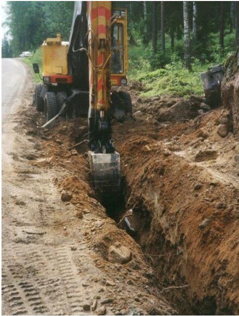
Figur 25 schakt för HydraWay dränering
