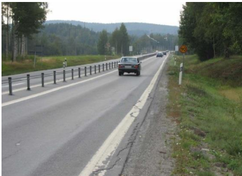
Figur 17,a,b bärighetsproblem med vatten i vägkroppen
