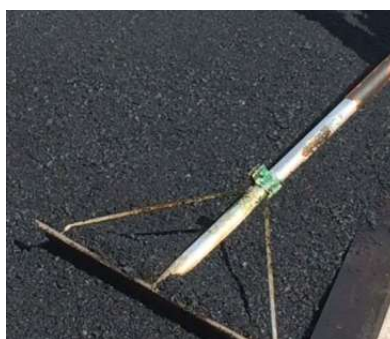
Raka ut massan till ett jämt lager
