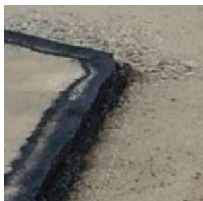
Raka och skarpa kanter mot gammal beläggning
