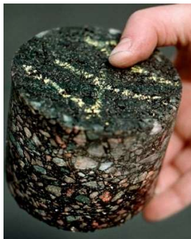
Asfaltprov av Highway Fix
