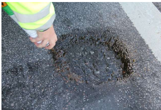
Limning med Reaktiv asfaltlim
