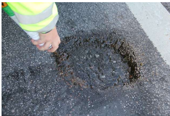
Limning med Reaktiv asfaltlim
