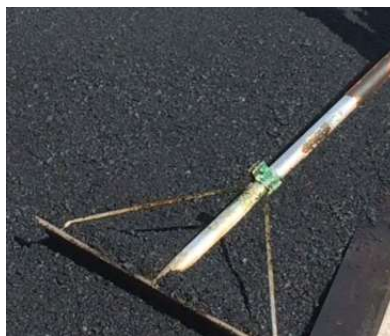
Raka ut massan till ett jämt lager
