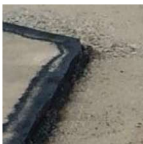
Raka och skarpa kanter mot gammal beläggning
