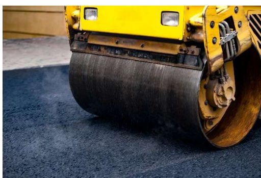
Handstamp för packning av mindre ytor
