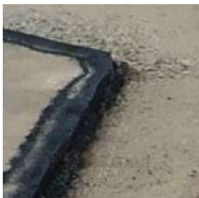
Raka och skarpa kanter mot gammal beläggning
