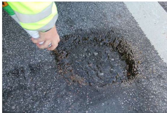
Limning med Reaktiv asfaltlim
