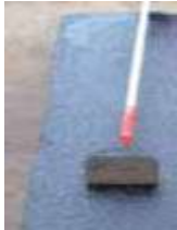
Försegling av skarv och ytor runt skada med emulsion
