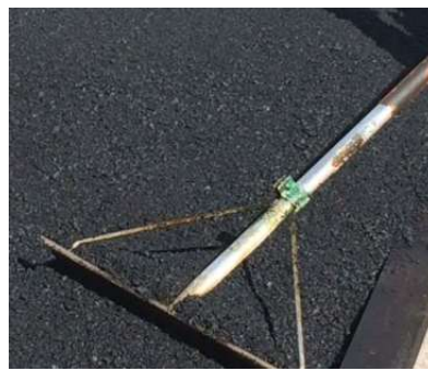
Raka ut massan till ett jämt lager
