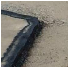
Raka och skarpa kanter mot gammal beläggning
