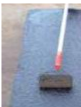
Försegling av skarv och ytor runt skada med emulsion
