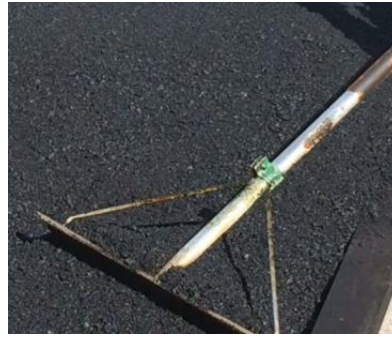
Raka ut massan till ett jämt lager
