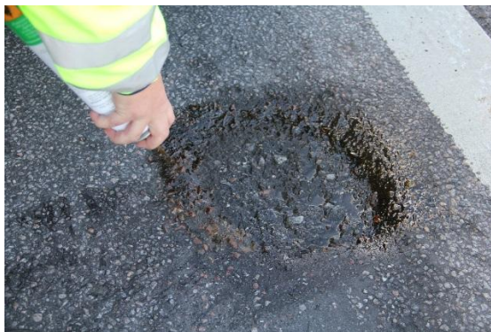
Limning med Reaktiv asfaltlim
