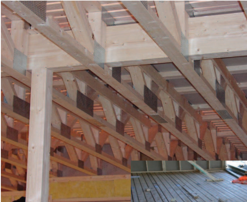
Gitterbjelke i bjelkelag med skjult bæring.
