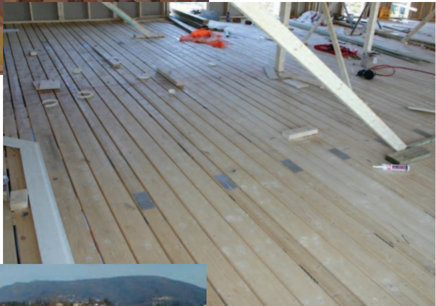
Gitterbjelke i bjelkelag med plattformgulv som arbeidsgulv i byggeperioden.
