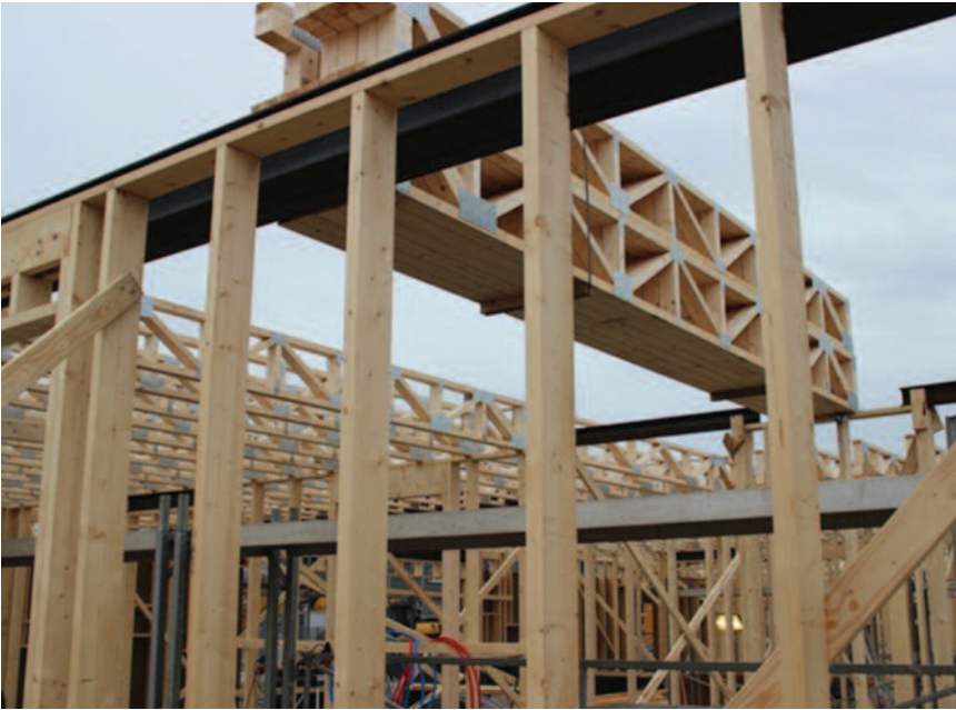
Montasje på byggeplass.
