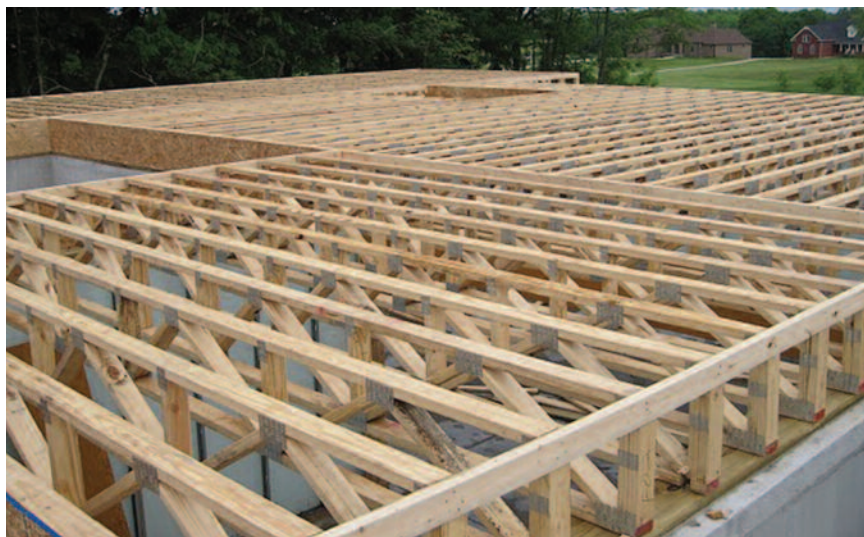
Gitterbjelker brukt som bjelkelag.
