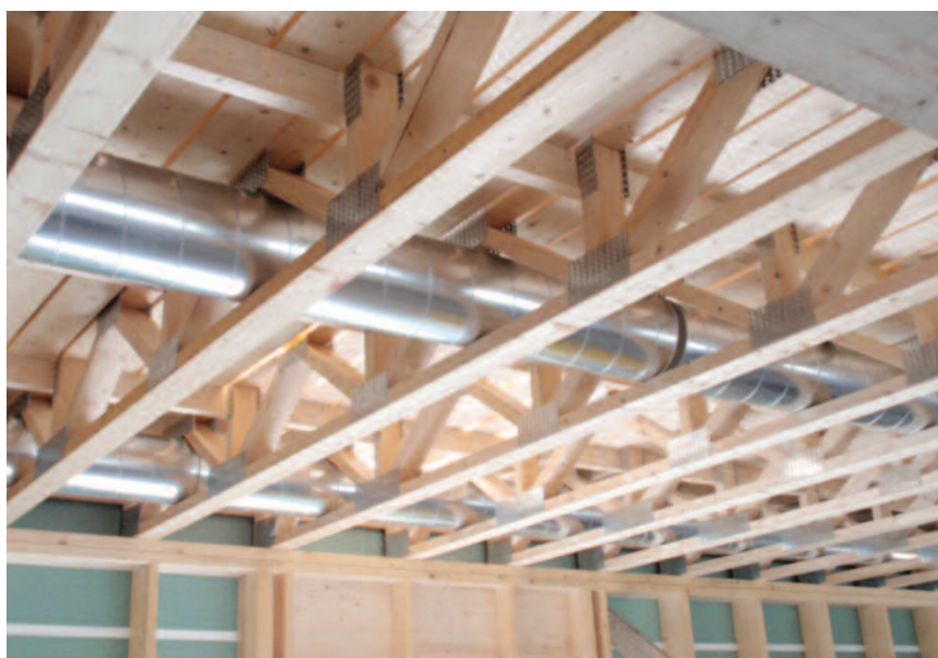
Gitterbjelker brukt som bjelkelag med føringsvei for tekniske installasjoner.
