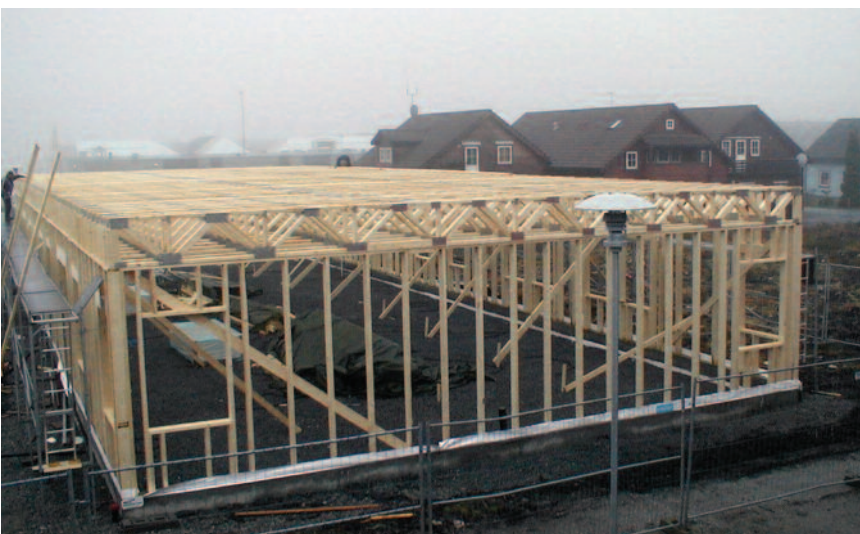
Gitterbjelker muliggjør lange spenn på bjelkelag.
