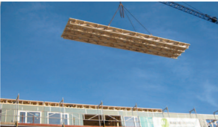
Montasje av gitterbjelker som prefabrikerte elementer.
