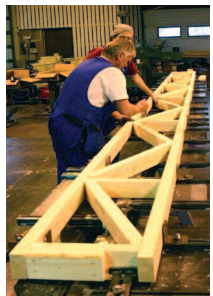
Produksjon av gitterbjelke i fabrikk.
