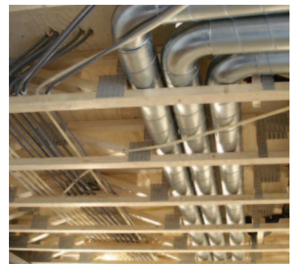
Gjennomføring av rør og installasjoner.
