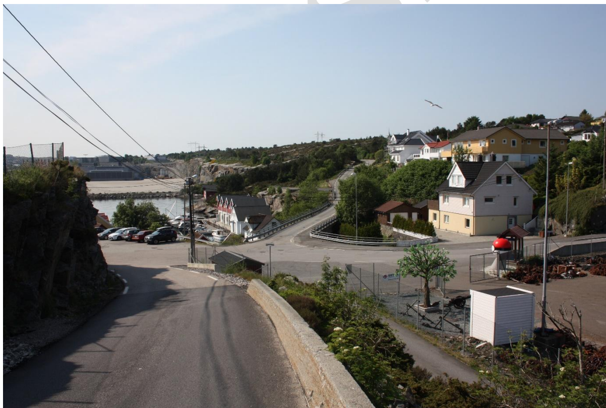
Figur 10. Planområdet sett frå fv224. Ei fjellskjering går langs med vegen ned krysset på Vindenes. Bak i bildet ser ein Vindenesvegen gå mot Landro. (Foto: Stracon AS)
