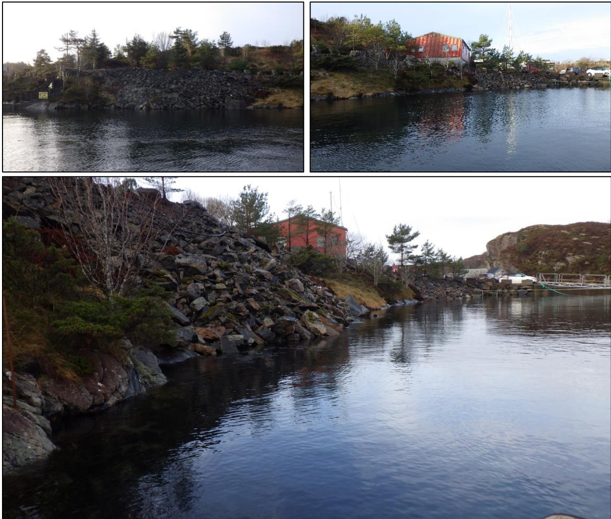
Figur 7. Oversikt over Utfyllingsområdet langs land ved Dalsneset. Steinfyllingen fortsatte ut i sjøen.
