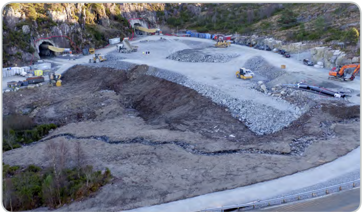
Nytt hovedreinsanlegg på Litle Sotra, Storanipa.
