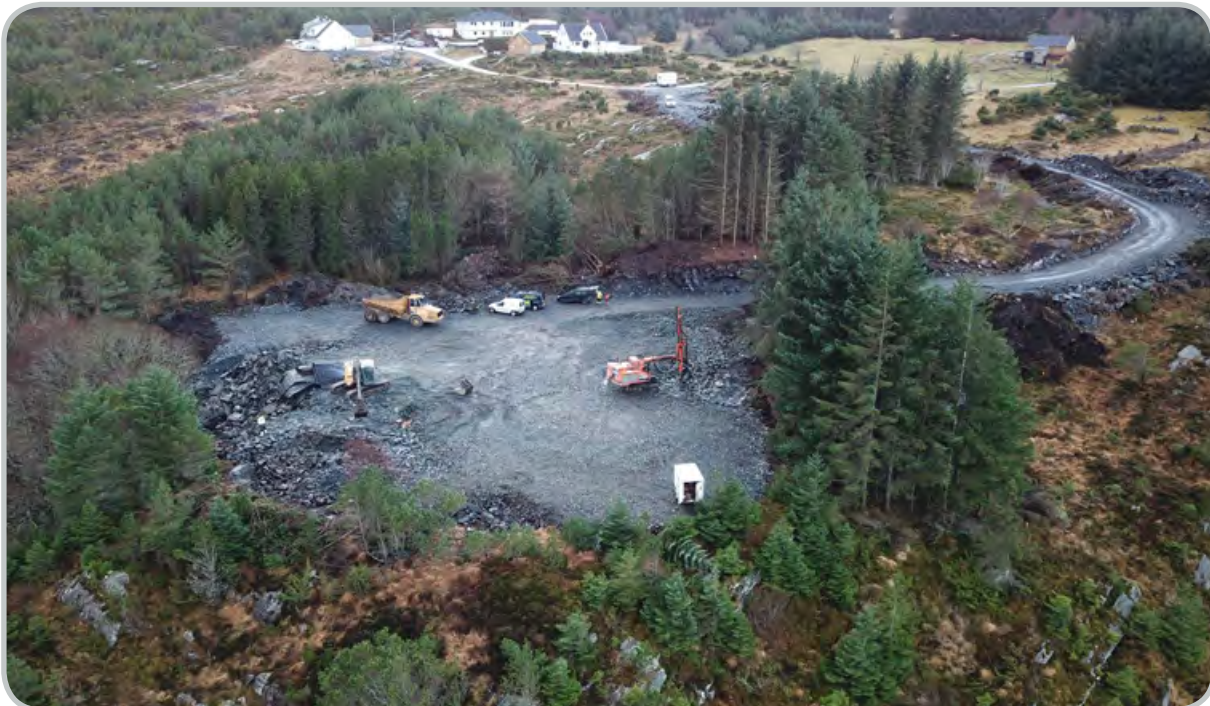
Tomt for reinseanlegg/prosessanlegg på Krekjebærneset på Ågotnes. Grunnarbeider er kontrahert og under planlegging sammen med selve bygget.
