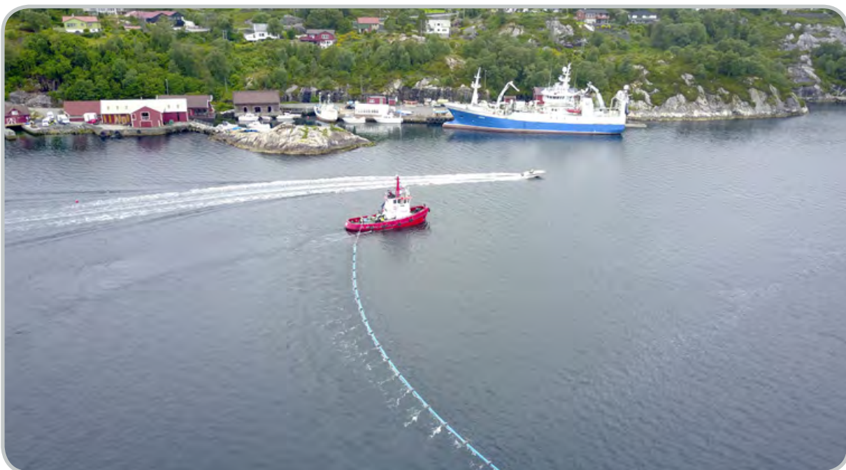
Kommunalt vatn til Lie og Liaskjæret, sjøleidning på veg mot Liaskjæret.
