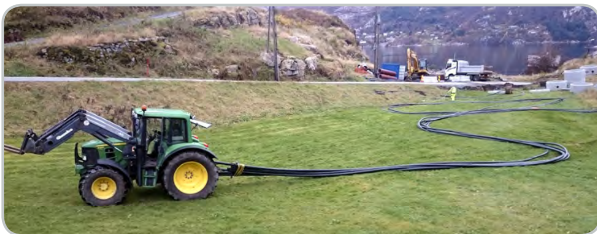
Gjenbruk av gamle ledninger fra Solsvik til midlertidig ledning for Bjørøy syd.
