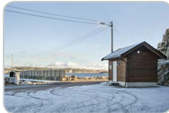
Turøyna, nytt ventilhus med trykkreduksjon og vassmålar med radiokommunikasjon inn til vårt kontrollanlegg.
