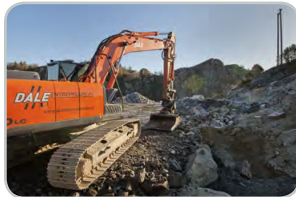
Høg aktivitet på Våge i samband med det nye reinseanlegget i fjellet på Storanipa.
