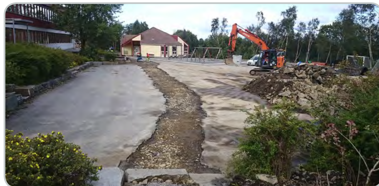
Graving ved Kolltveit skule, ny avløpsleidning frå Bildøy vest til Storanipa.
