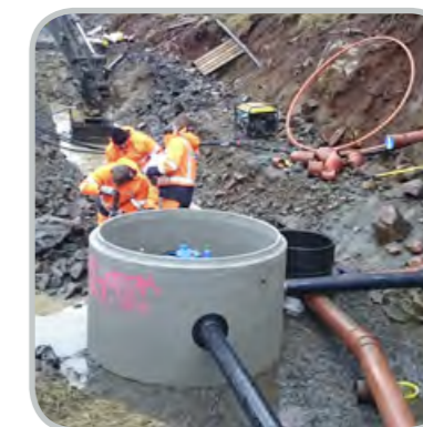
Legging av nye vatn- og avløpsleidningar Gangstøgarden for sanering av gamle anlegg og tilknytning av nytt bustadfelt på Gangstøgarden.
