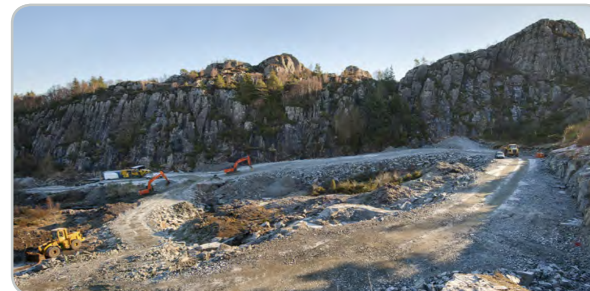
Våge, nytt reinseanlegg i fjellet i Storanipa.
