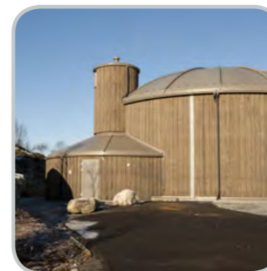
Steinsfjellet høgdebasseng ved turvegen mellom Foldnes og Hjelteryggen.
