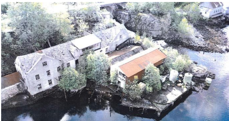
Figur 1, den gamle fabrikk
