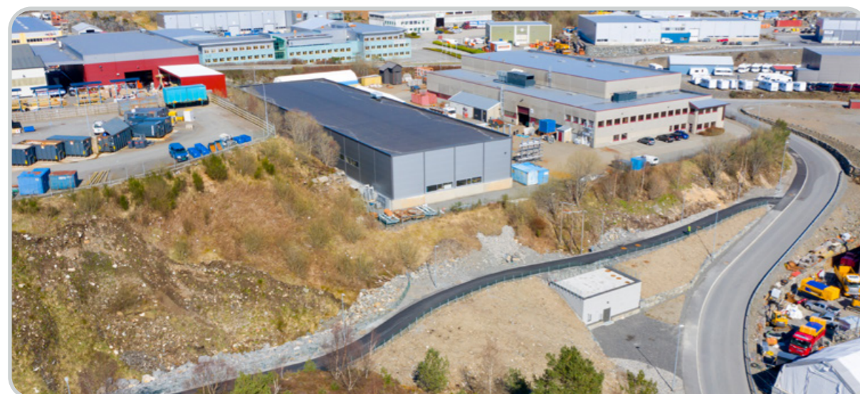
Smålonane pumpestasjon og ny gangveg gjennom dalen til Lonavegen.
