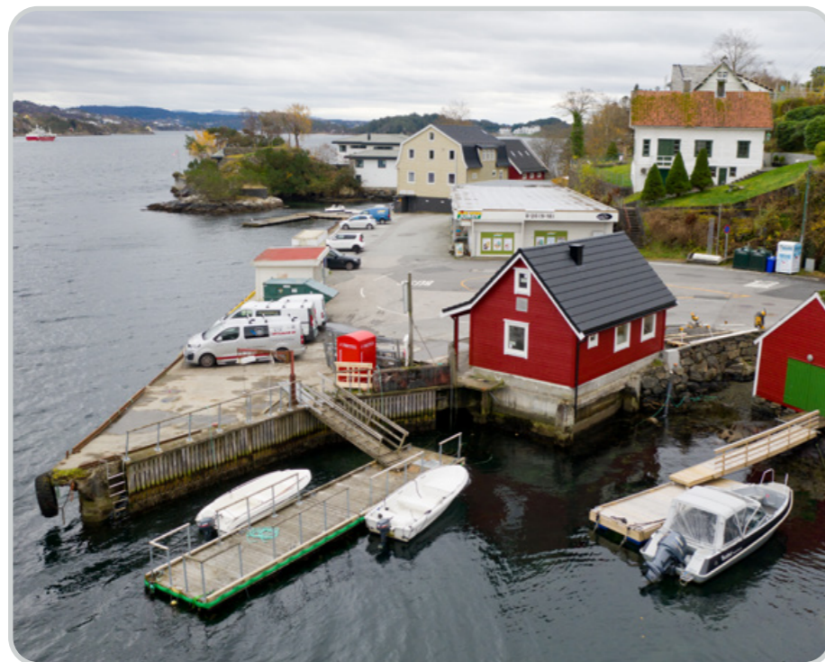
Brattholmen, reinsanlegg bygd om til pumpestasjon.
