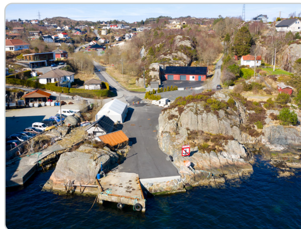
Valen, reinseanlegg bygd om til pumpestasjon.
