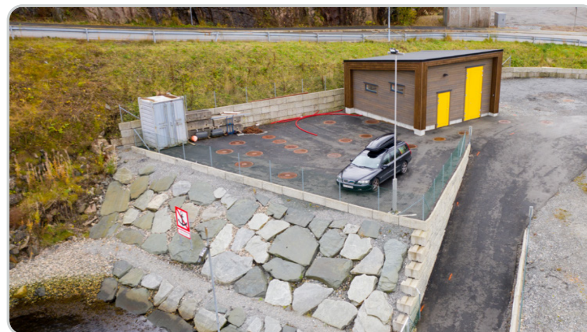
Søre Bildøyna, ny pumpestasjon.
