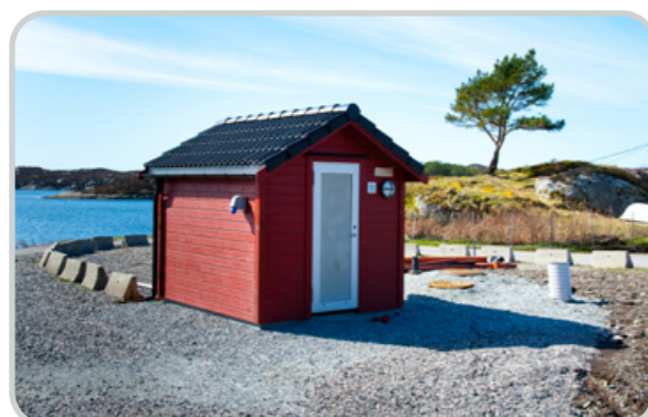
Angeltveitsjøen, slamavskiljar bygget om til pumpestasjon.
