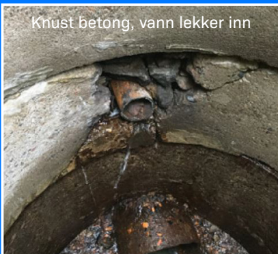
Reparasjon av knust betong
