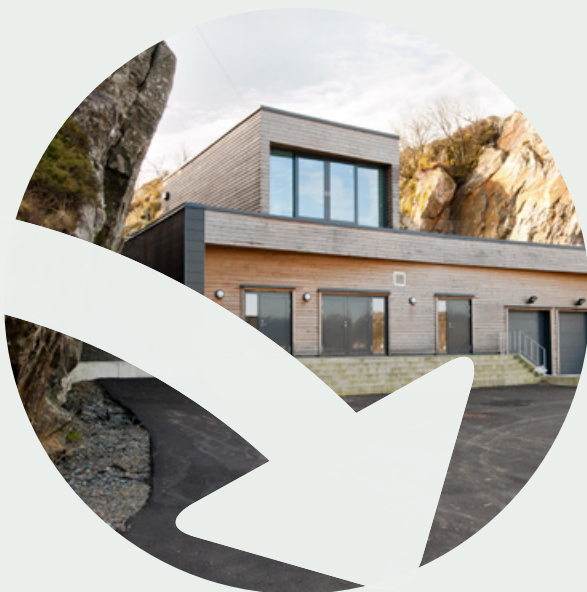
Møvik avløps- reinseanlegg
