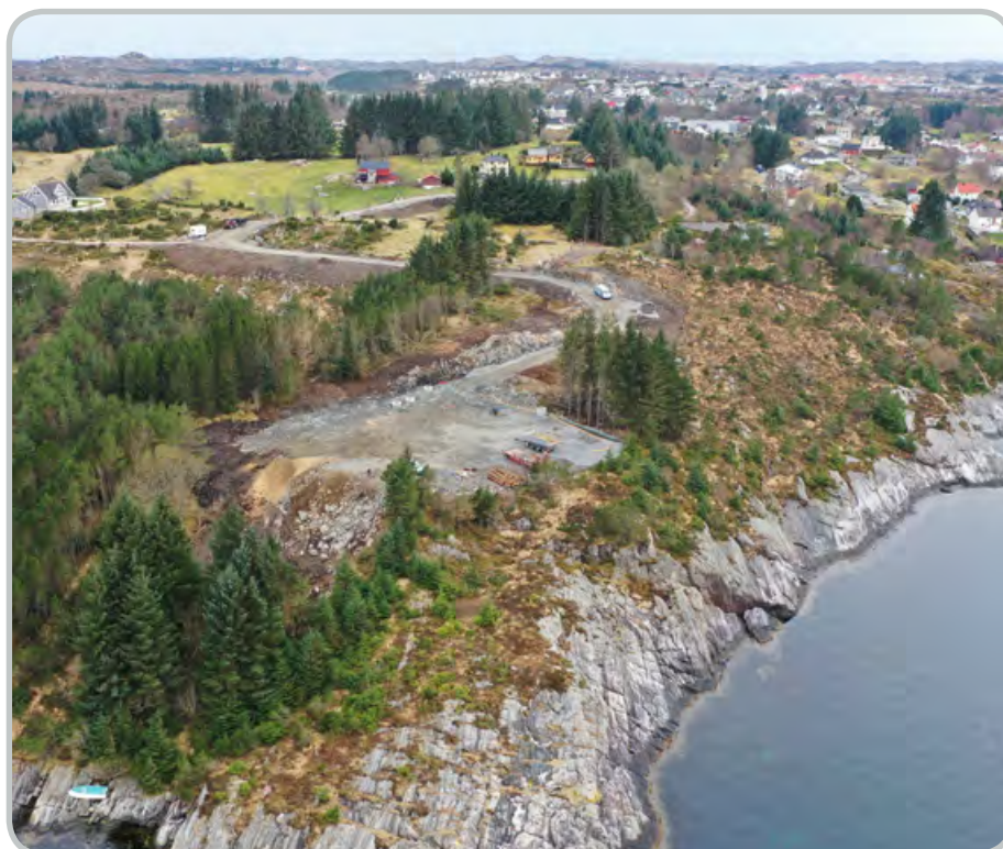
Grunnarbeid godt i gang for reinseanlegg på Krekjebærneset.
