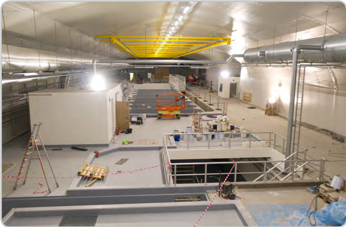
Anlegg i fjellhall i Storanipo på Våge.
