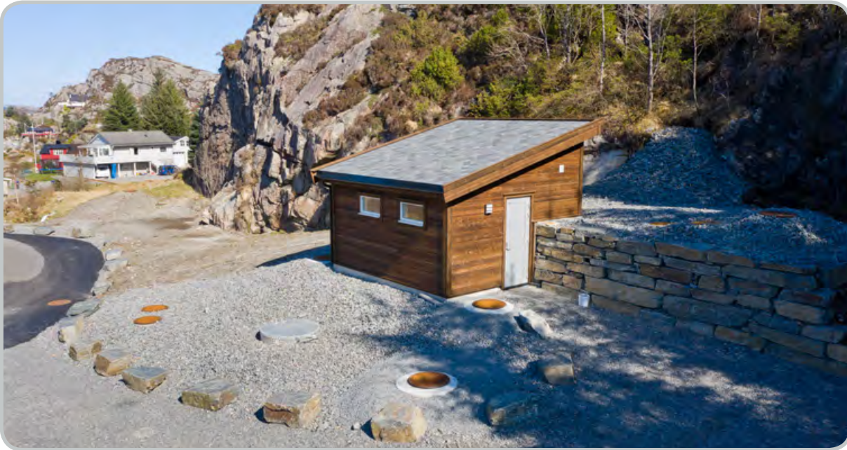
Nytt reinseanlegg på Kallestadvika.
