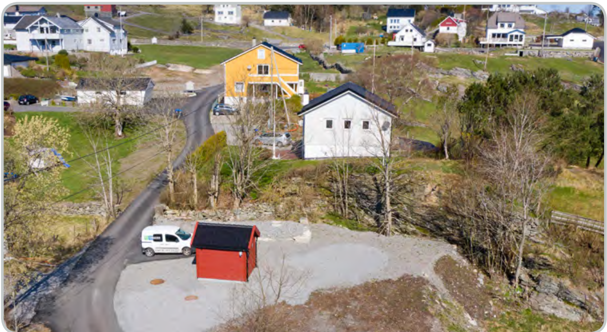
Pumpestasjon sør på Kallestad pumper avløp til avløpreinseanlegg i Kallestadvika.
