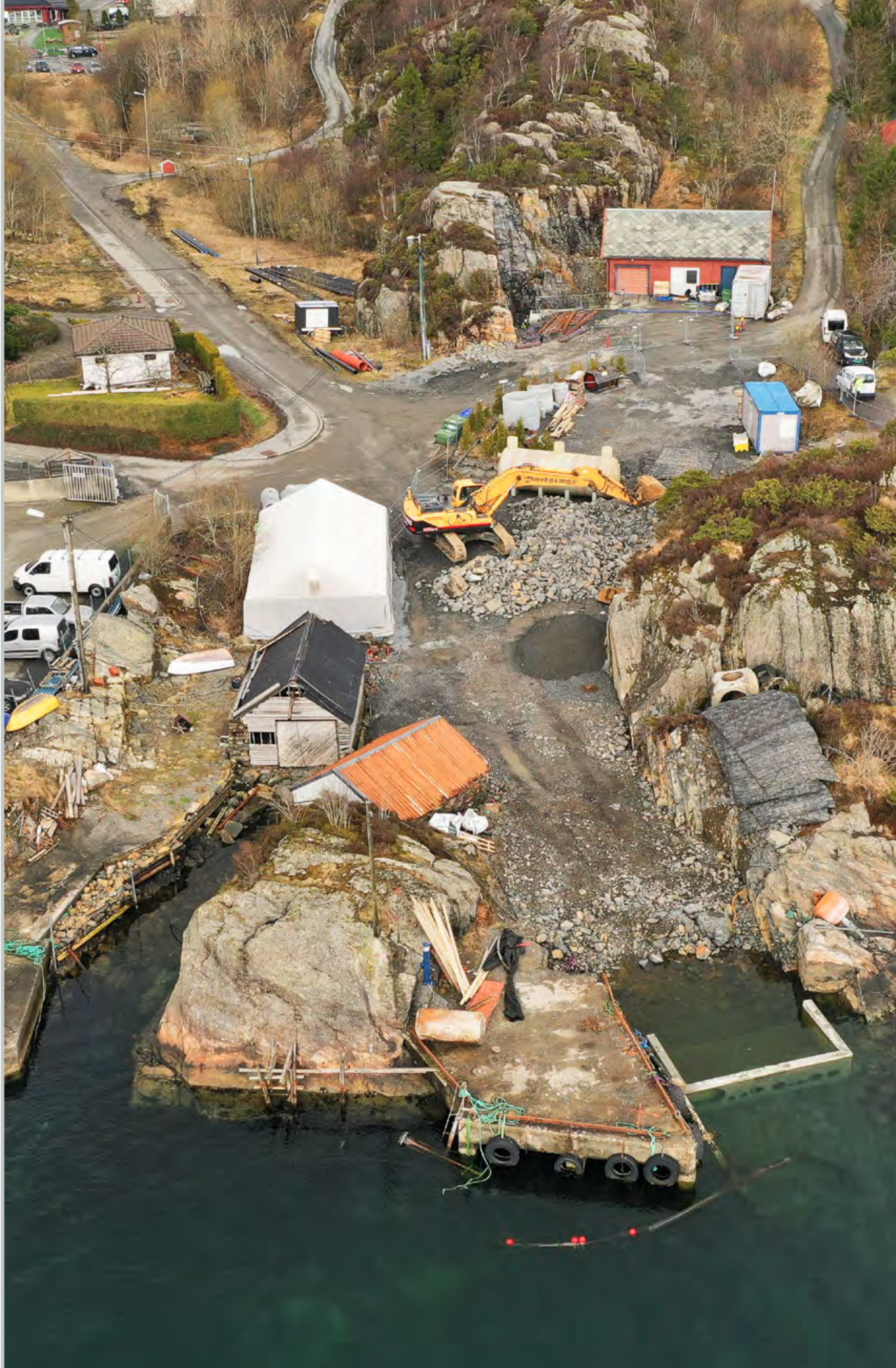
Ombygging av avløpsanlegg i Valen.
