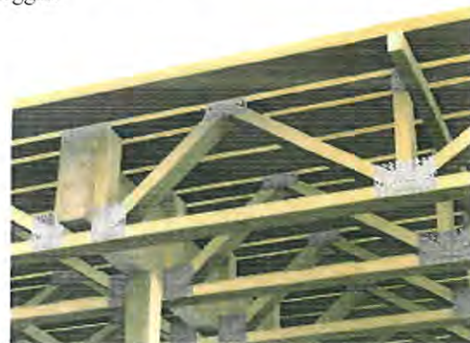
Fig 6. Gitterbjelkelag med tverrgående bærebjelke understøttet av søyle
