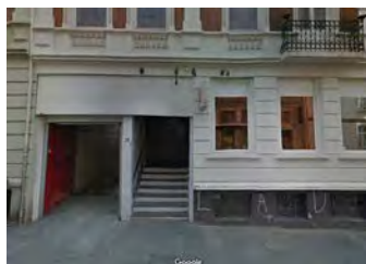
2 - Eksisterende portrom i prosjektet
