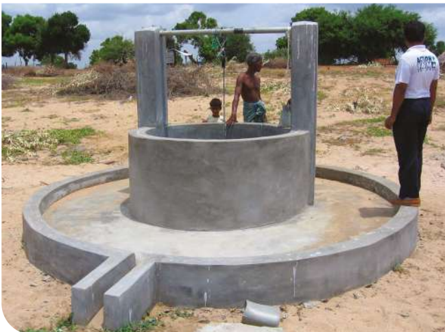
Action contre la Faim en train de construire des puits pour fournir de l’eau potable au Sri Lanka, 2006
