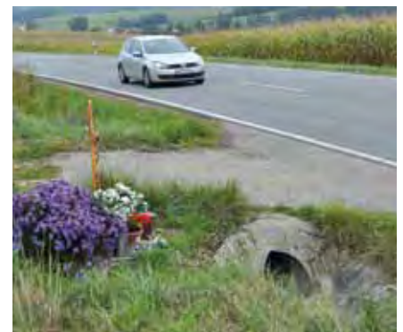
Tiefe Entwässerungsgräben mit Einbauten sind gefährliche Hindernisse im Seitenraum.
