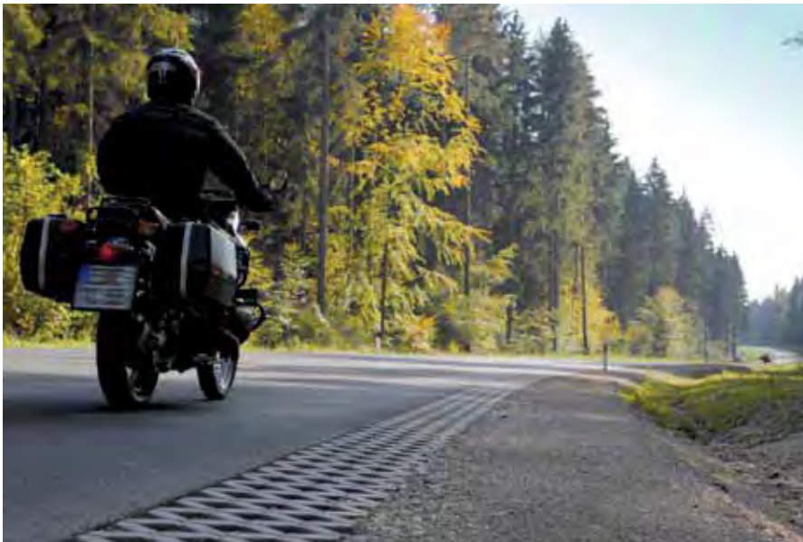
Verstärkung der Bankette durch Betonformsteine
