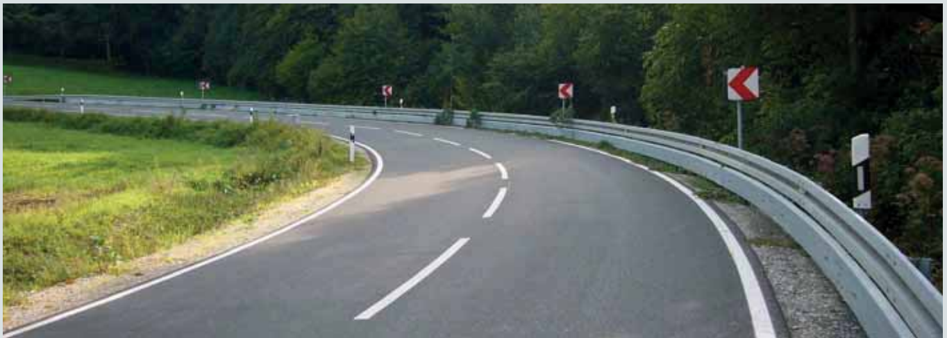
Schutzplanke mit Unterfahrschutz
