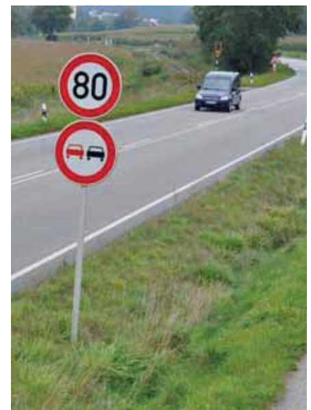
Einseitig durchgezogene Fahrstreifenbegrenzung verdeutlicht Überholverbot
