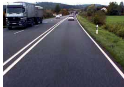
2+1 Querschnitt zul. Höchstgeschwindigkeit: 100 km/h Rechter Seitenraum: Sicherheitsraum 0-3m (1*) Linker Seitenraum: Sicherheitsraum 0-3m (1*) Mitteltrennung: Doppelte Fahrbahnbegrenzung (1*)
