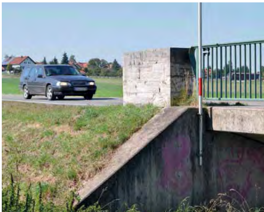
Gefährliche Hindernisse am Fahrbahnrand: Langholzstapel, Betonpfosten, Holzmast, Brückengeländer aus Beton
