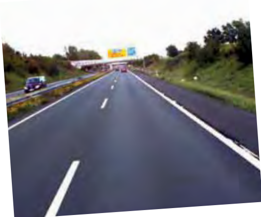
Zweibahniger Querschnitt zul. Höchstgeschwindigkeit: 120 km/h Re. Seitenraum: Sicherheitsraum 7-10m (2*) Linker Seitenraum: Sicherheitsraum 7-10m (2*) Mitteltrennung: Schutzplanke (4*)
