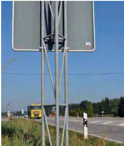
Aufgelöster, umfahrebarer Schildermast
