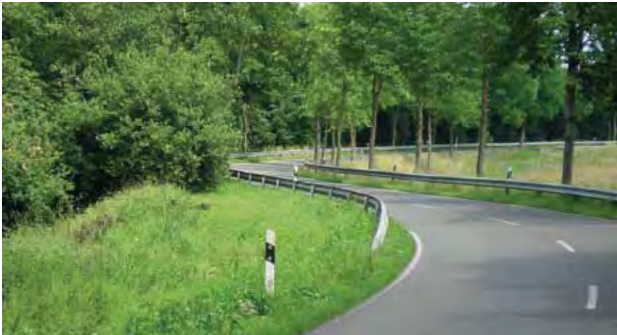
Gefährlich für Motorradfahrer: Schutzplanken ohne Unterfahrerschutz
