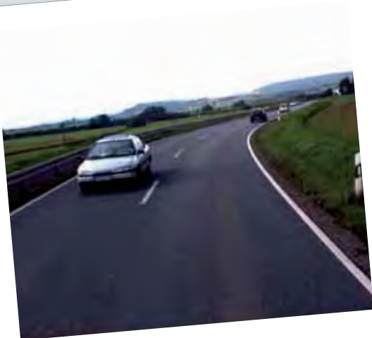
Einbahniger Querschnitt zul. Höchstgeschwindigkeit: 100 km/h Re. Seitenraum: Sicherheitsraum 10m (4*) Linker Seitenraum: Schutzplanke (4*) Mitteltrennung: Leitlinie (1*)
