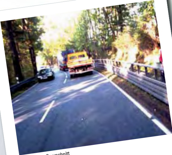
Einbahniger Querschnitt zul. Höchstgeschwindigkeit: 80 km/h Rechter Seitenraum: Schutzplanke (4*) Linker Seitenraum: Schutzplanke (4*) Mitteltrennung: Leitlinie (2*)
