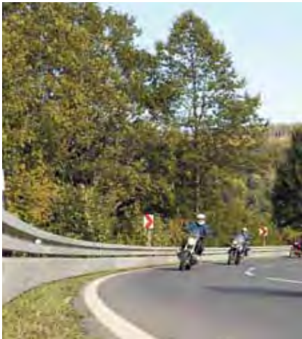
Schutzplanke mit Unterfahrerschutz
