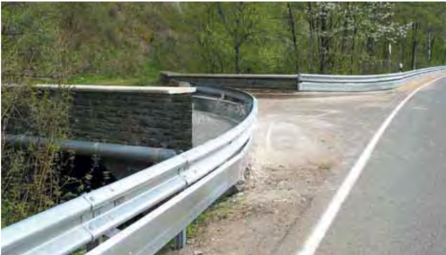
Schutzplanke vor Brückengeländer
