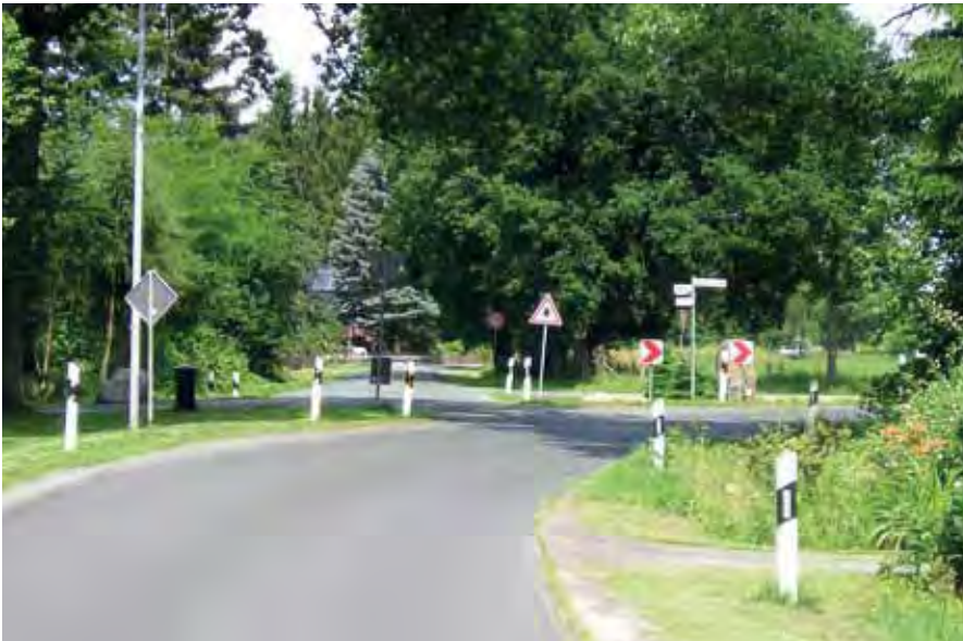
Schlecht erkennbare Kurve
