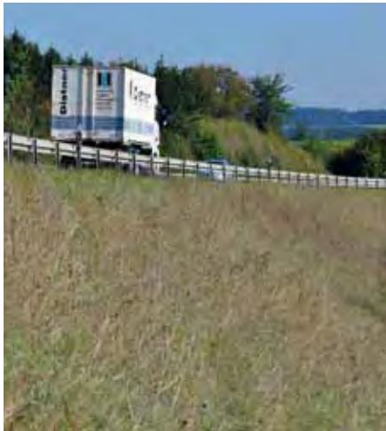
Straße in Dammlage mit Schutzplanke
