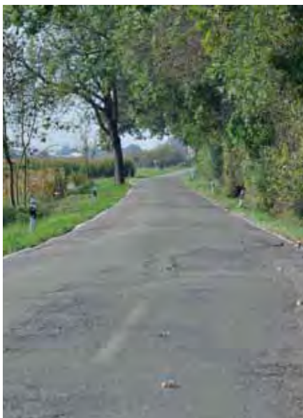
Schlechte Erkennbarkeit der Linienführung bei Nacht wegen mangelhafter Fahrbahnmarkierungen
