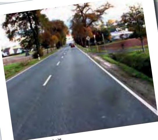
Einbahniger Querschnitt zul. Höchstgeschwindigkeit: 80 km/h Rechter Seitenraum: Sicherheitsraum 0-3m (2*) Linker Seitenraum: Sicherheitsraum 0-3m (2*) Mittelrennung: Leitlinie (2*)
