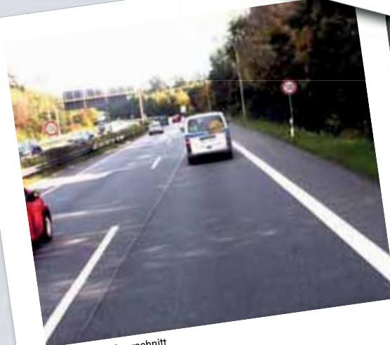
Zweibahniger Querschnitt zul. Höchstgeschwindigkeit: 130 km/h Rechter Seitenraum: Sicherheitsraum 0-3m (1*) Linker Seitenraum: Schutzplanke (4*) Mitteltrennung: Schutzplanke (4*)
