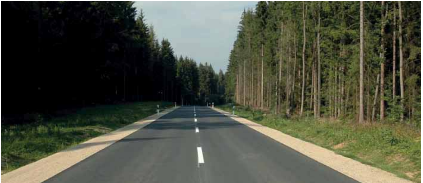
Neue Landstraße mit Leitlinie aber ohne Fahrbahnbegrenzung
