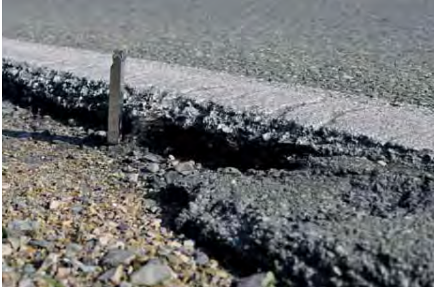
Unfälle vorprogrammiert: 5 cm Höhenversatz zwischen Fahrbahnrand und Bankette
