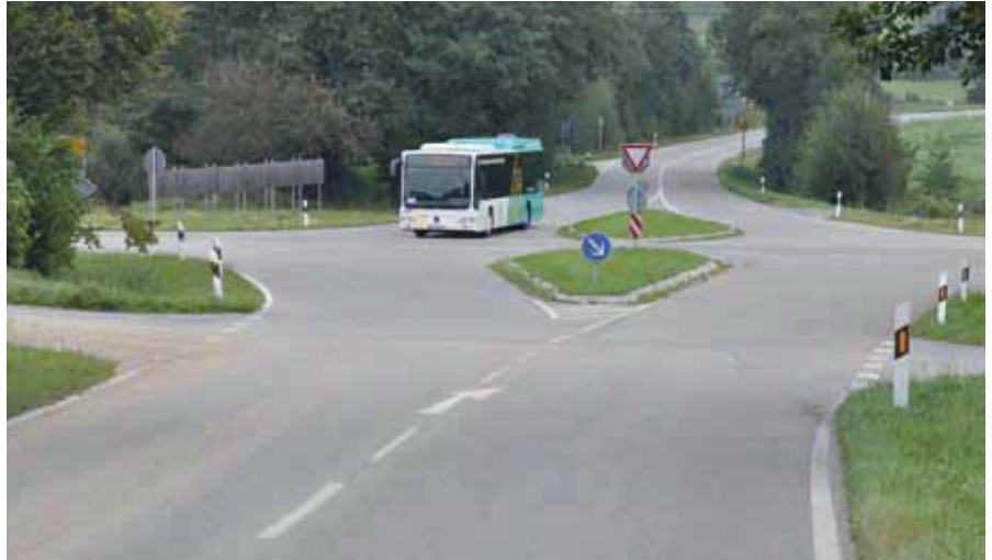
Übersichtliche Kreuzung auf einer Landstraße. Fahrbahnnteiler verdeutlichen die Wartepflicht
