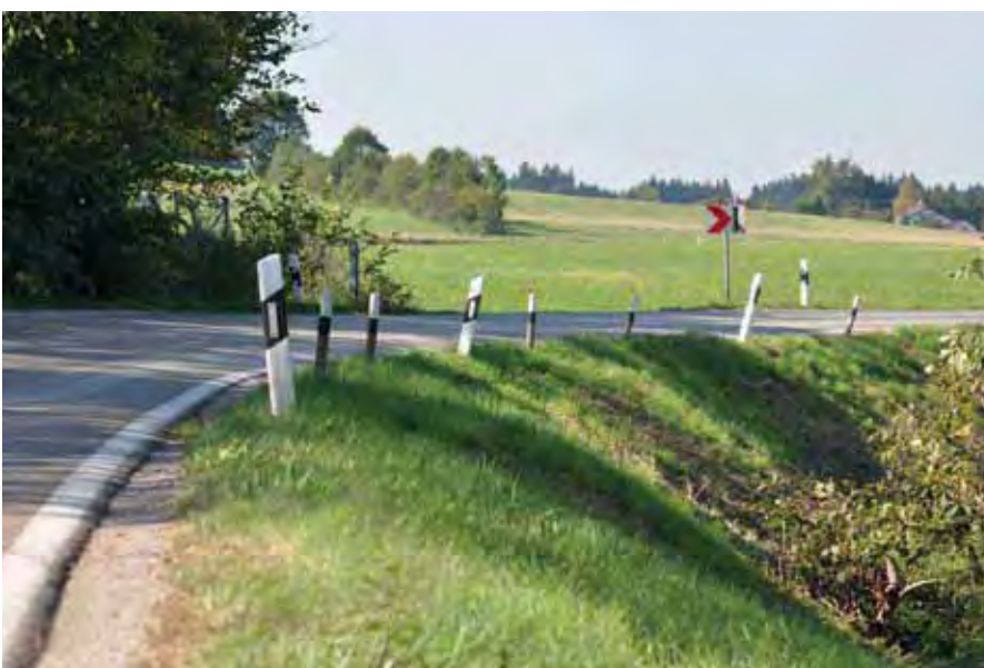
Improvisierte Kurvenmarkierung mit gestrichenen Holzpfosten
