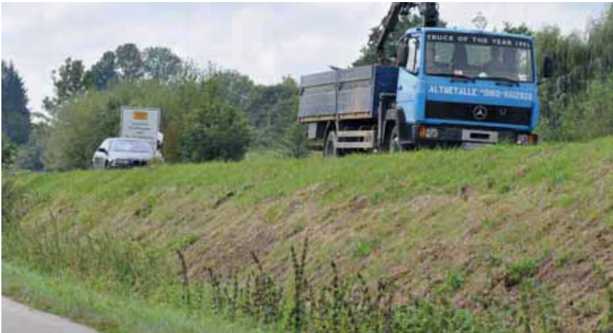
Absturzgefahr: Straße in Dammlage ohne Absicherung
