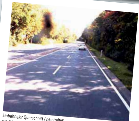
Einbahniger Querschnitt zul. Höchstgeschwindigkeit: 100 km/h Rechter Seitenraum: Sicherheitsraum 0-3m (1*) Linker Seitenraum: Sicherheitsraum 0-3m (1*) Mitteltrennung: Leitlinie (1*)
