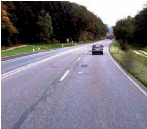
2+1 Querschnitt zul. Höchstgeschwindigkeit: 80 km/h Rechter Seitenraum: Sicherheitsraum 3-7m (2*) Linker Seitenraum: Sicherheitsraum 7-10m (3*) Mitteltrennung: Doppelte Fahrbahnbegrenzung (2*)
