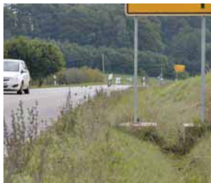
Tiefe Entwässerungsgräben mit Einbauten sind gefährliche Hindernisse im Seitenraum.
