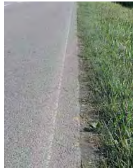
Völlig verwitterte Fahrbahnbegrenzung
