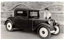
1931 DKW F1 mit Zweitaktmotor und Frontantrieb
