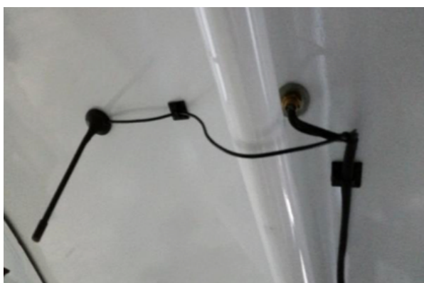
Bild 14: Montage WiFi-Antenne Dach-innenseite
