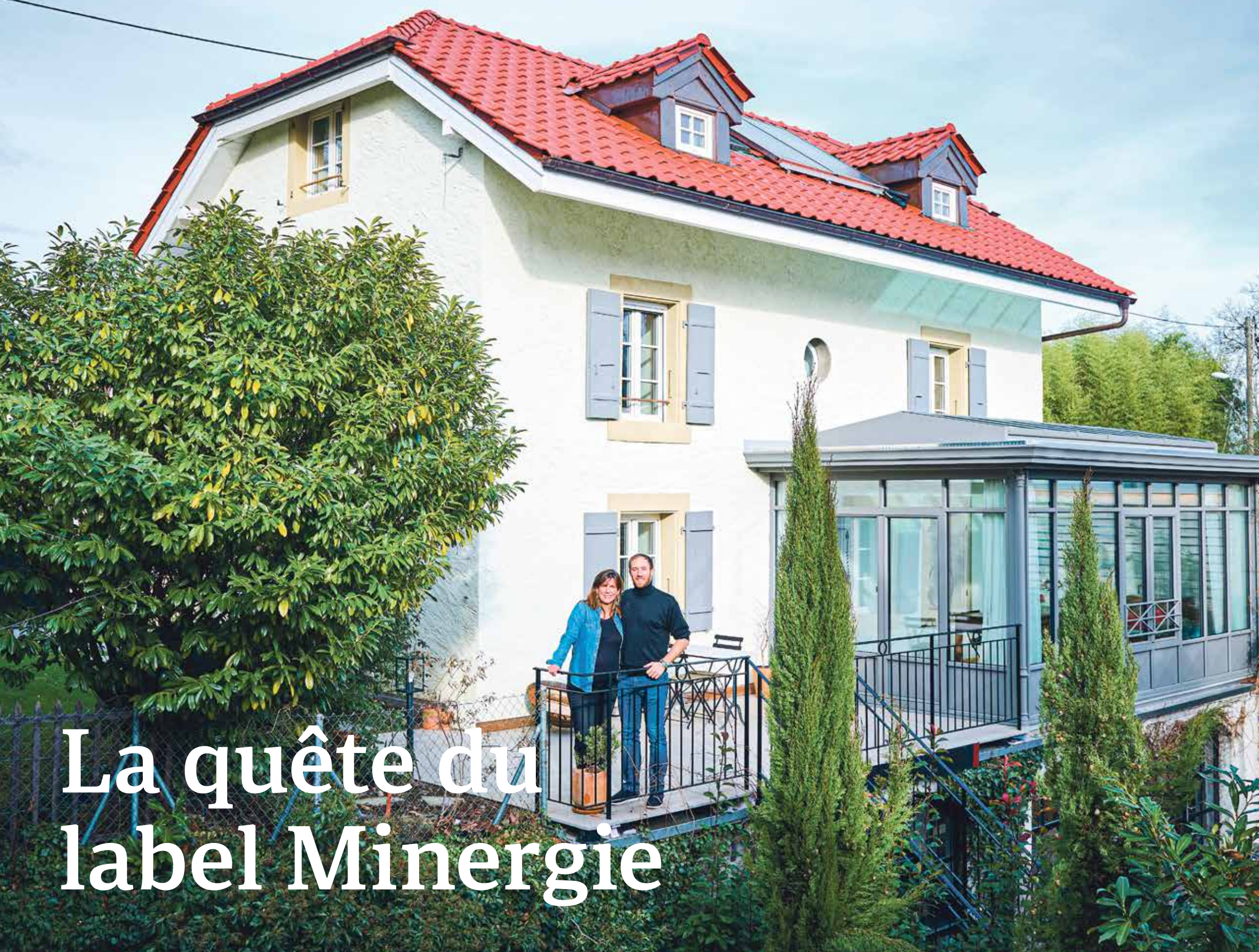
Morgan et Virginia Rosier ont rénové leur maison, vieille de 150 ans, selon les exigences du label Minergie.
