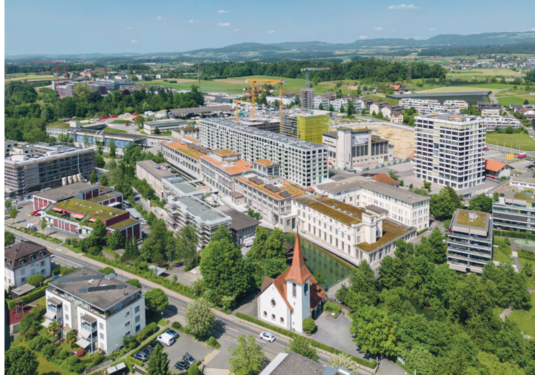
Le projet intégré et zéro CO 2 du quartier Papierer de Cham (ZG) exploite différentes sources d'énergie locales et soulage le réseau de distribution.
