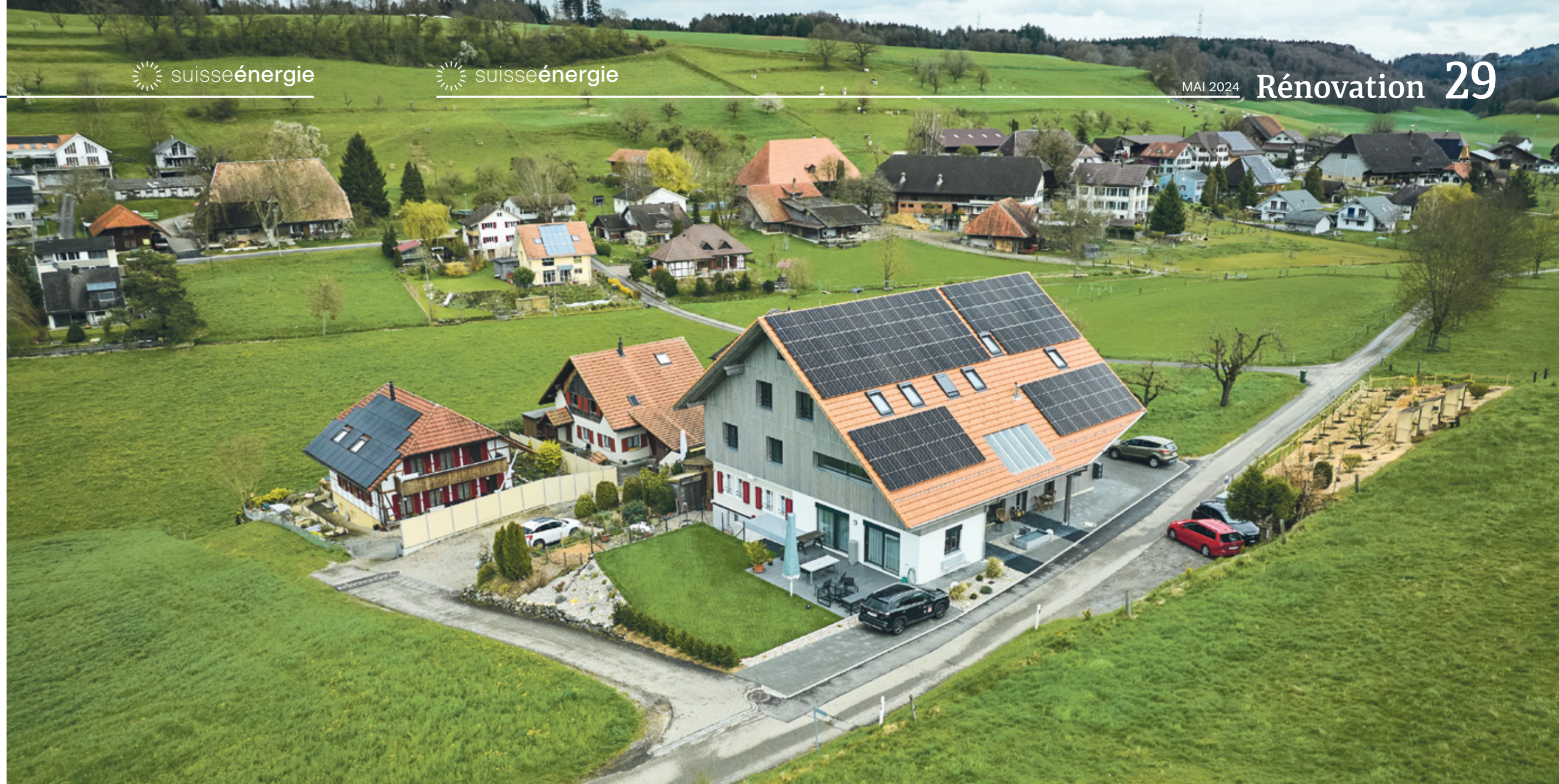
Le côté sud du toit en pignon est équipé de panneaux photovoltaïques: leur puissance maximale est de 30 kilowatts.
