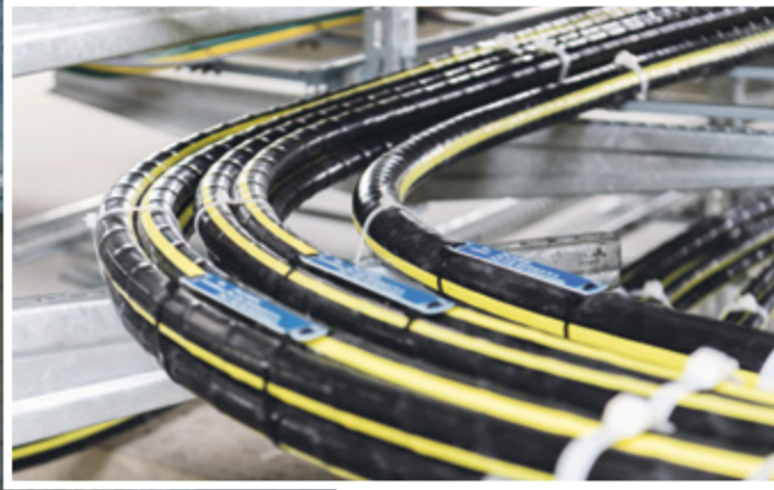
Les champs de sondes et l'eau fluviale captée alimentent les pompes à chaleur d'un réseau de chaleur et de froid.
