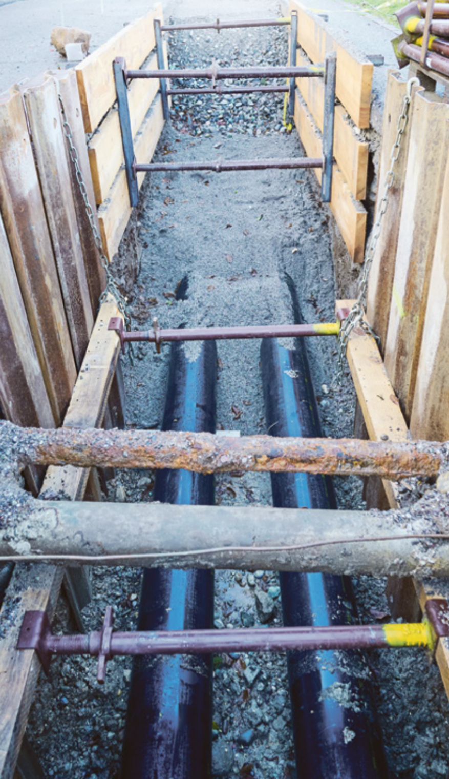
A Fehraltorf, les conduites du réseau à distance se précisent. Les premières maisons devraient être alimentées dès l'automne.
