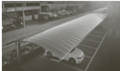
PARKPLATZ FÜR ELEKTROAUTOS MIT FLEXIBLEN SOLARMODULEN Produkt: Flisom AG, Niederhasli
