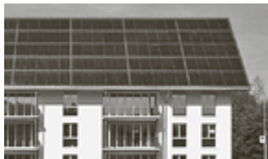
MFH OBERBURG Produkt: Jenni Energietechnik AG, Oberburg bei Burgdorf
