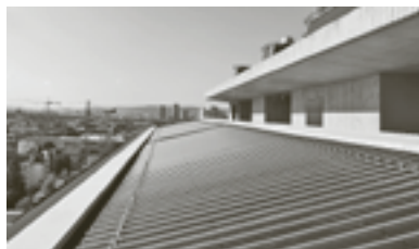
HOHES HAUS WEST, ZÜRICH Architektur: Loeliger Strub Architektur GmbH, Zürich Produkt: Conergy, Hamburg
