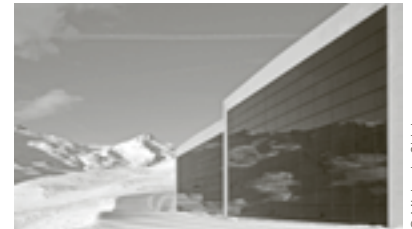
SKISTATION SANKT MARTIN, LAAX Produkt: NICE Solar Energy GmbH, Schwäbisch Hall (D) Vertrieb: Solarmarkt GmbH, Aarau
