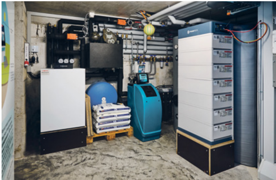
Der Technikraum im Untergeschoss, wo Wärmepumpe, Strom- und Wärmespeicher installiert sind.
