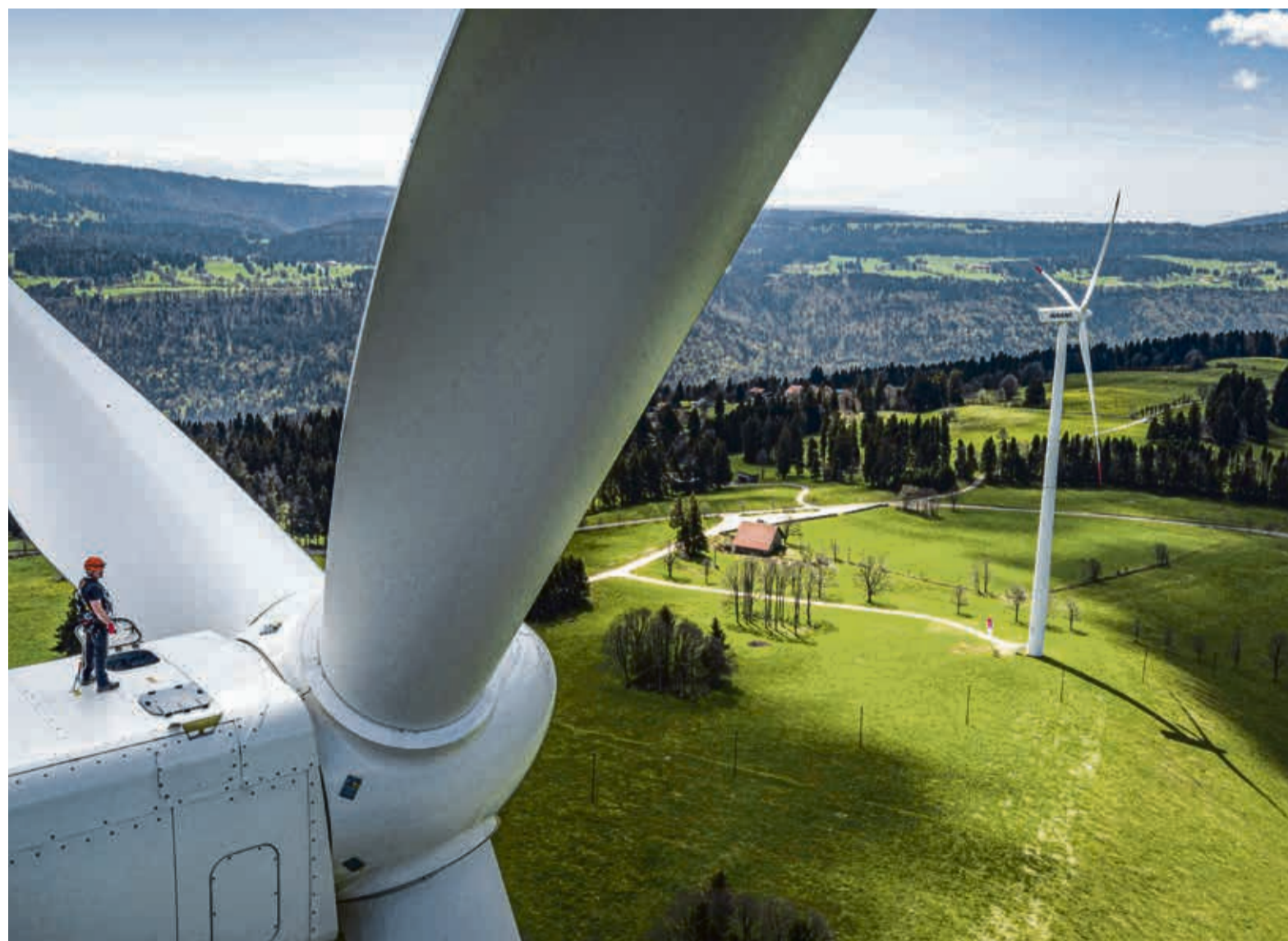
Wichtiges Element der Energiestrategie 2050: Windenergieanlagen sollen 7 Prozent des Strombedarfs decken.
