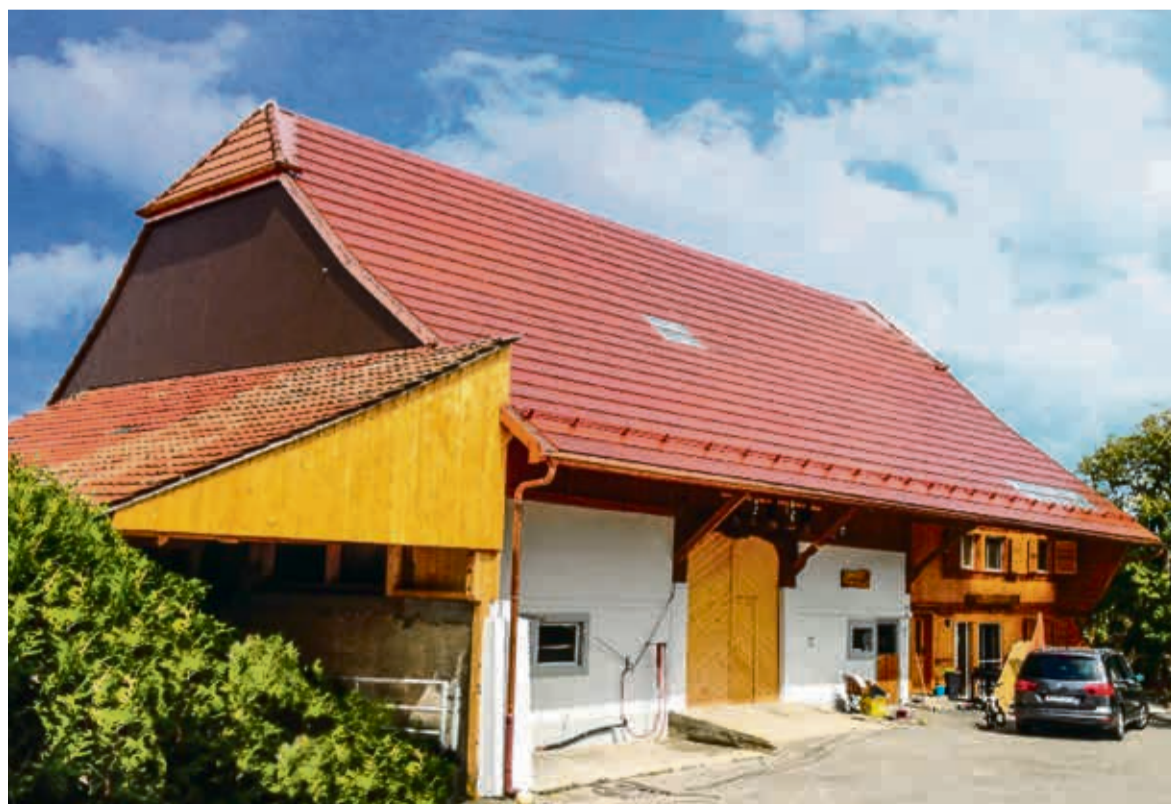
Getarnt: Die Ziegel auf diesem 1859 gebauten Bauernhaus in Ecuwillens (FR) haben es in sich: Es sind PV-Module, die speziell für denkmalgeschützte Objekte entwickelt wurden.
