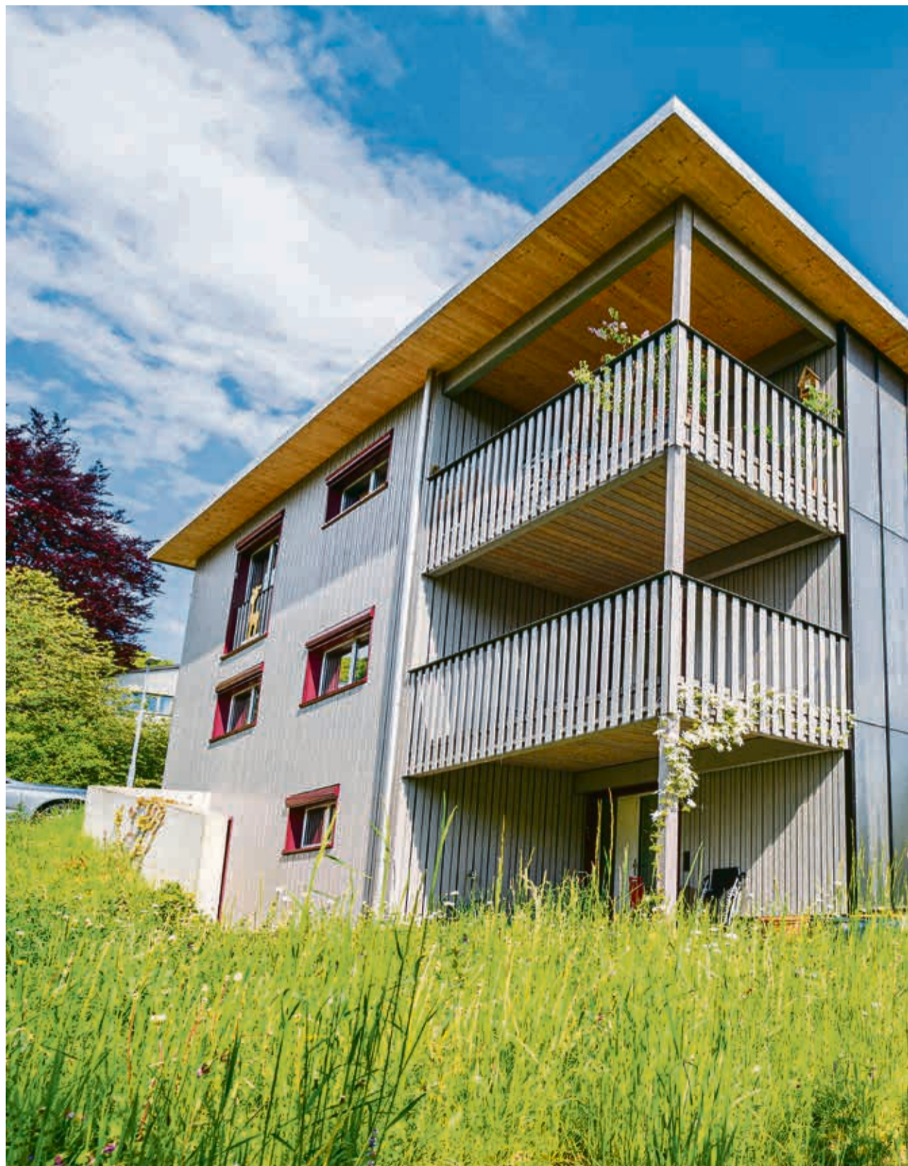
Neu drei statt eine Wohnung im Haus: Die Besitzerin kann im Haus bleiben und von Mieteinnahmen profitieren.
