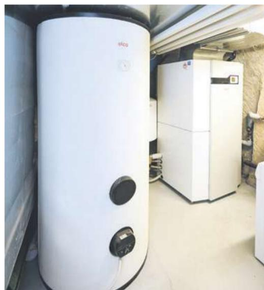
Il nuovo impianto di riscaldamento: una pompa di calore aria-acqua installata all'interno (a destra) con accumulatore per il solare termico.
