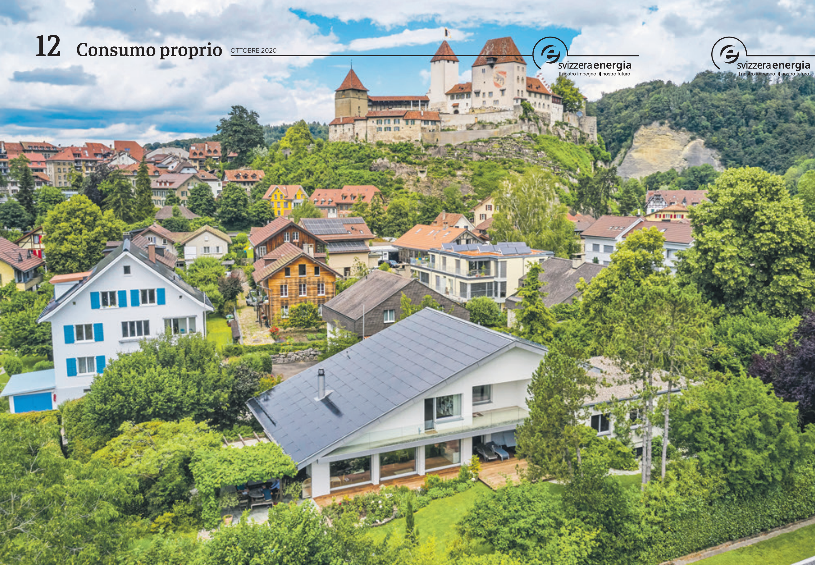
Sopra i tetti del quartiere si erge il castello di Burgdorf, mentre sul tetto della casa degli Schober un impianto solare integrato che nel 2017 ha sostituito un rivestimento in eternit.
