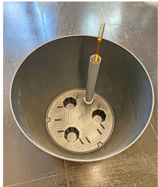
Tubo integrato per facilitare la sostituzione dell'indicatore del livello dell'acqua (foto: Andres Ernst)
