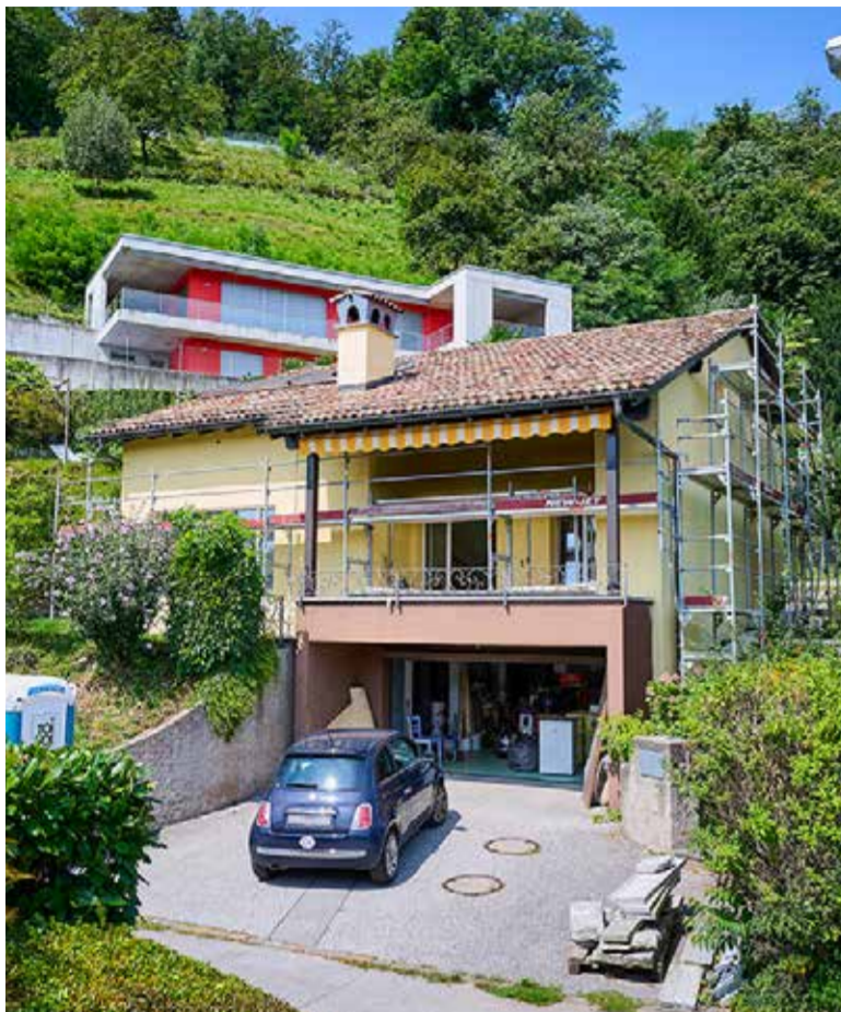
Il rinnovo della casa di Michela Sormani e Daniele Grespi è in fase di completamento.
