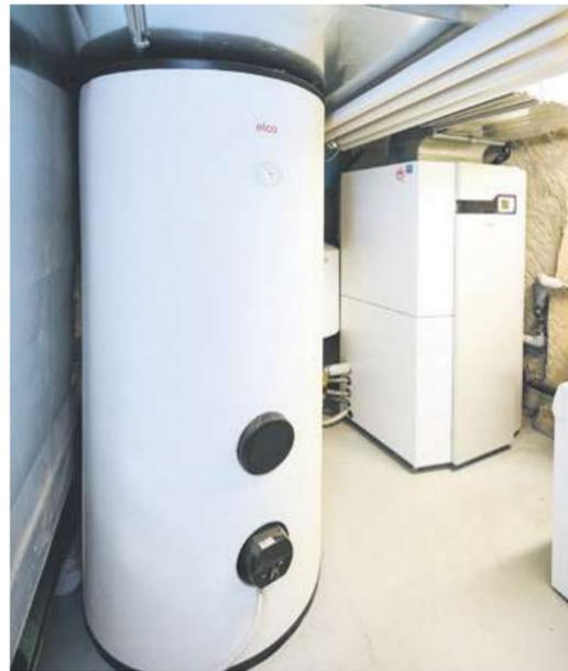
Le nouveau système de chauffage: une pompe à chaleur air-eau à l'intérieur (à droite) avec réservoir pour l'énergie solaire thermique.
