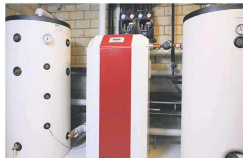
Transformer l'énergie solaire en chaleur stockée: avec une pompe à chaleur (au centre) et des réservoirs d'eau, c'est possible. Photo: Gerry Nitsch
