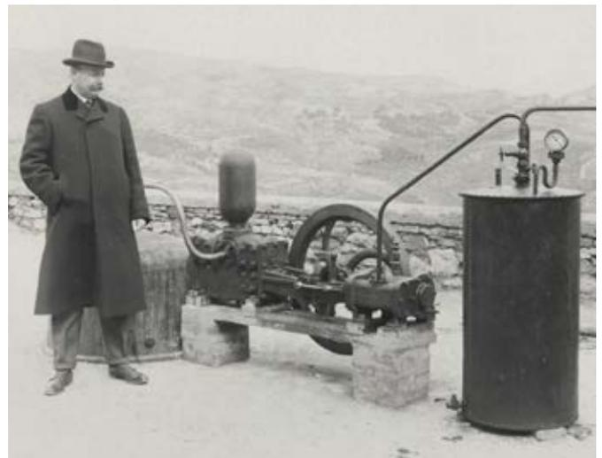
Larderello 1904: Turbina alimentata con vapore geotermico, accoppiata ad una dinamo con la quale, per la prima volta nella storia, fu prodotta energia elettrica. Fonte: Enel Green Power
