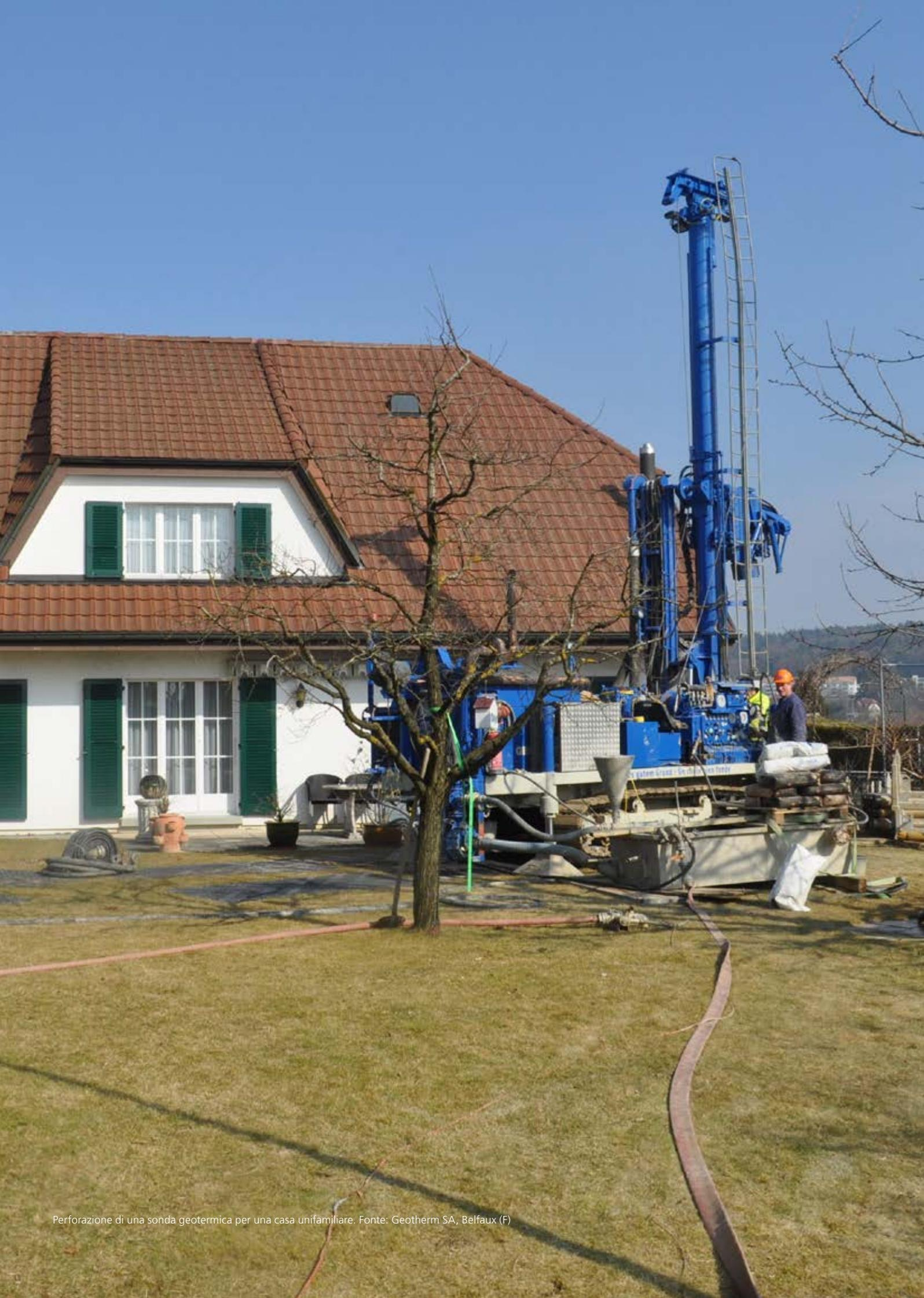
Perforazione di una sonda geotermica per una casa unifamiliare. Fonte: Geotherm SA, Belfaux (F)
