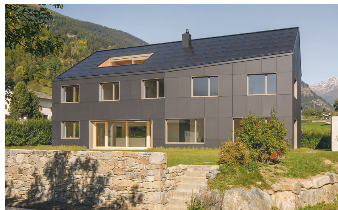
Das Winter-Plusenergiehaus Sol'CH in Poschiavo (GR) ist ein prämiertes Paradebeispiel der integrierten Photovoltaik. Die ganze Gebäudehülle, also inklusive Nordfassade, besteht aus PV-Modulen.
