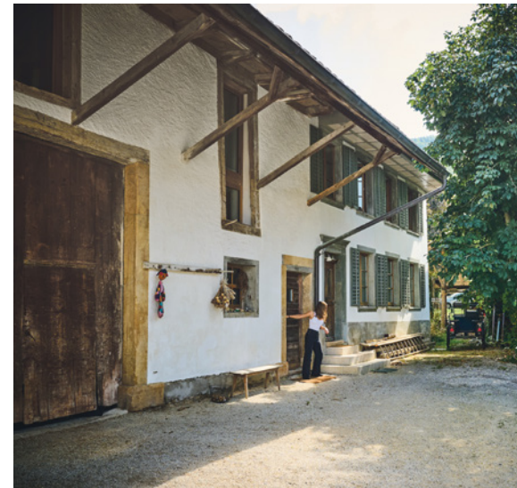
Die historisch bedeutende Südfassade des Oltinger Bauernhauses wurde lediglich aufgefrischt.
