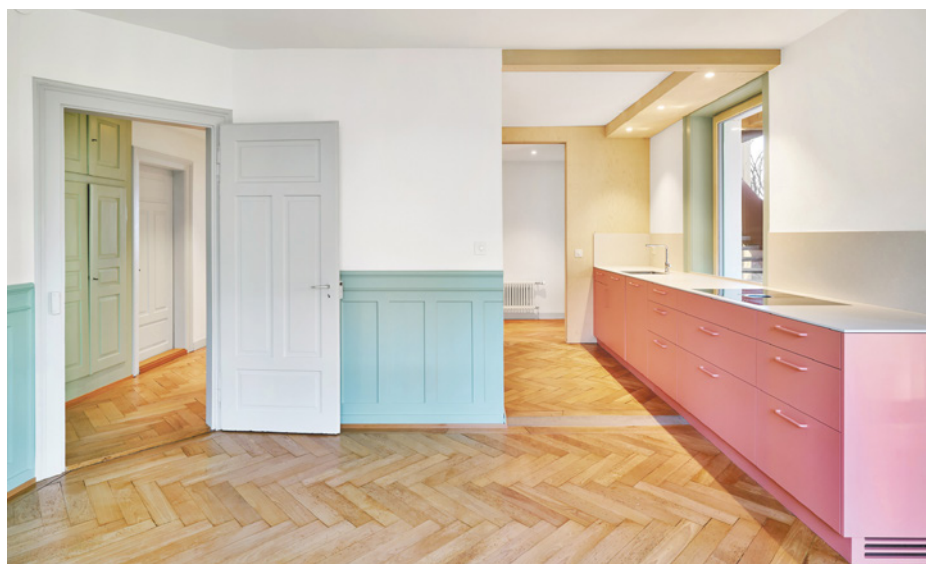
Treppenstufen wurden zu Türschwellen umfunktioniert, der Fischgratparkett war unter einem Spannteppich versteckt. Foto: ©baubüro in situ ag, Fotograf: Martin Zeller
