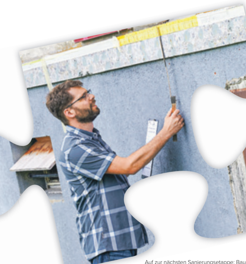
Auf zur nächsten Sanierungsetappe: Bauingenieur Andy Schütz legt oft selbst Hand an.
