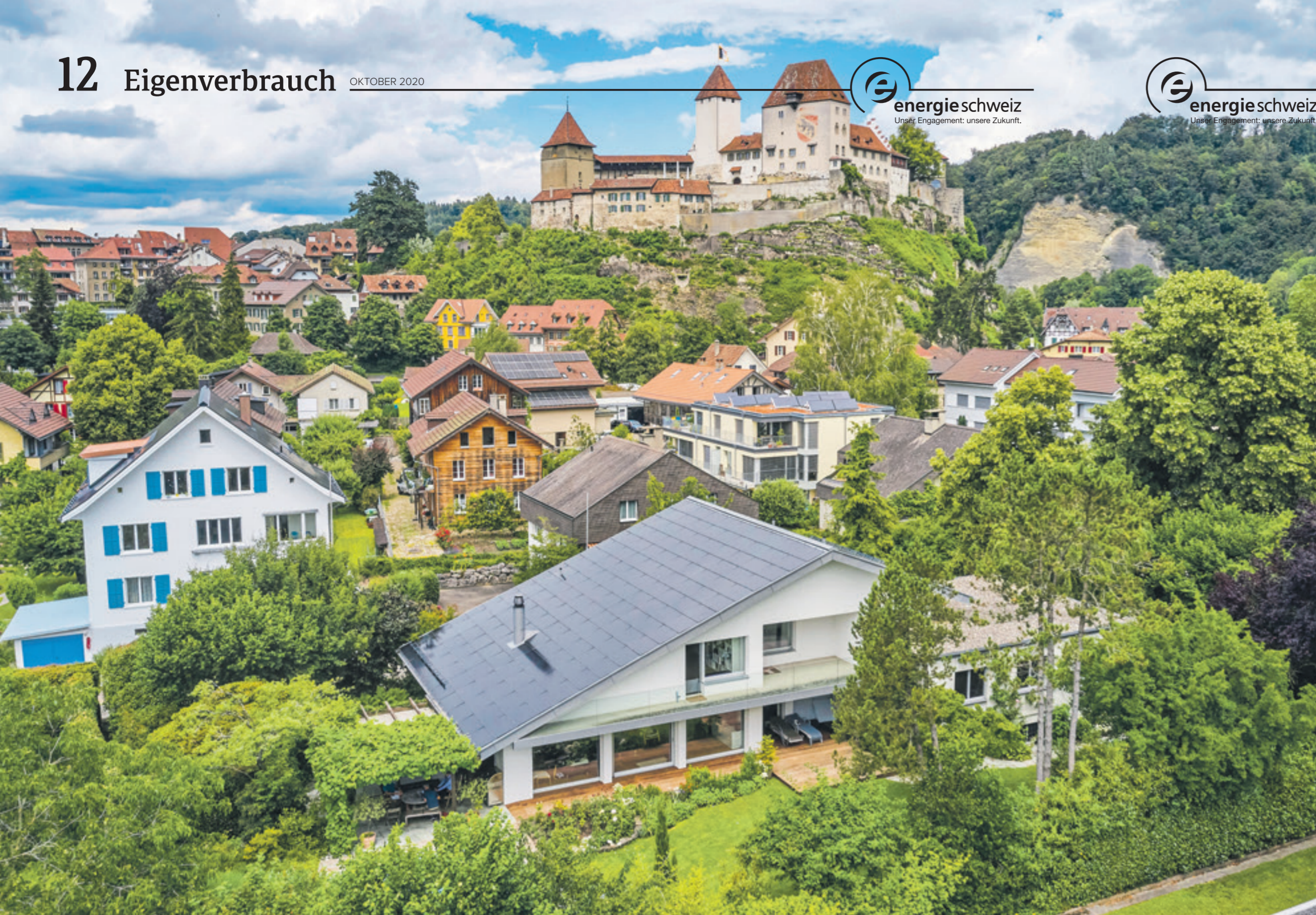
Über den Dächern des Quartiers das Schloss Burgdorf, auf dem Dach von Schobers Haus eine Indach-Solaranlage. 2017 wurde damit ein Enternitdach ersetzt.
