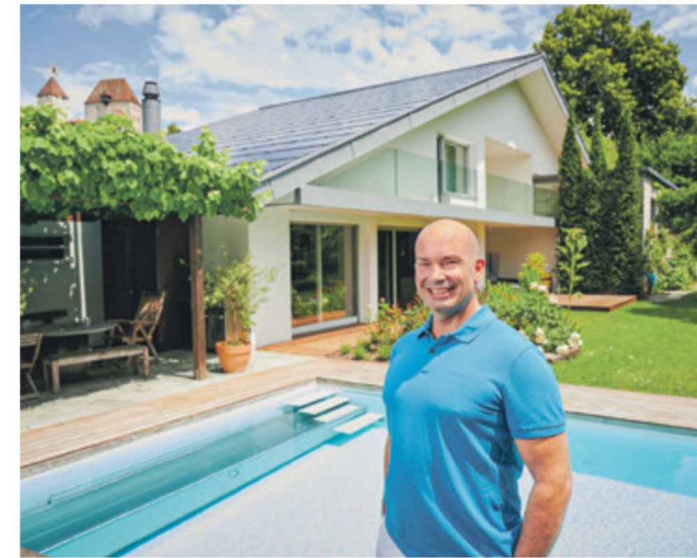
Die PV-Anlage heizt auch Ted Schobers Pool – allerdings erst, wenn der übrige Energiebedarf gedeckt ist.
