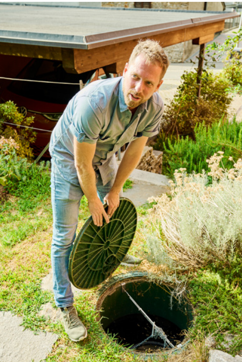
Alberto Conelli ha fatto interrare un serbatoio da 3000 litri, nel quale raccoglie l'acqua piovana dal tetto.
