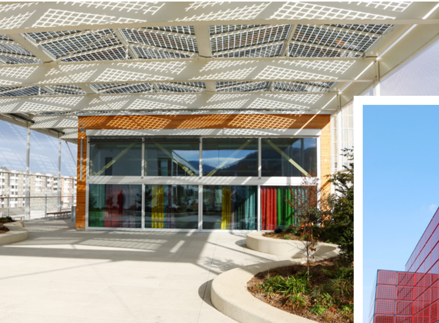
Sul tetto della Scuola elementare Allmend a Zurigo-Wollishofen un campetto per tutte le stagioni è stato dotato di un impianto FV integrato.
