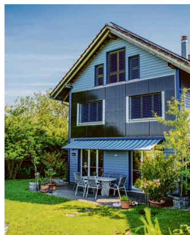
Classico: sulla facciata solare della casa di Jegenstorf (BE), citata nell'articolo, sono riconoscibili le classiche strisce sui moduli FV.
