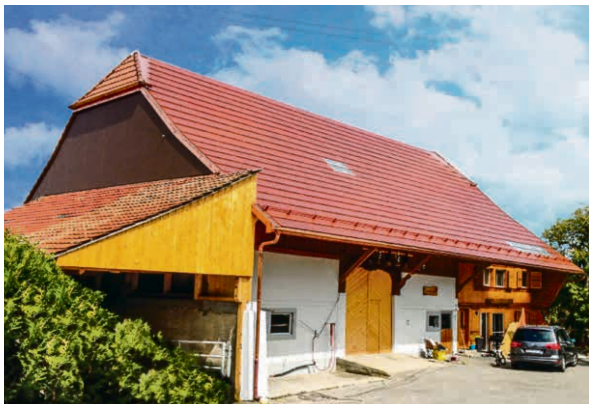
Mimetizzato: i mattoni di questa casa colonica costruita nel 1859 a Ecuwillens (FR) hanno una caratteristica particolare: sono moduli fotovoltaici sviluppati appositamente per gli edifici storici protetti. Foto: Solar Agentur Schweiz
