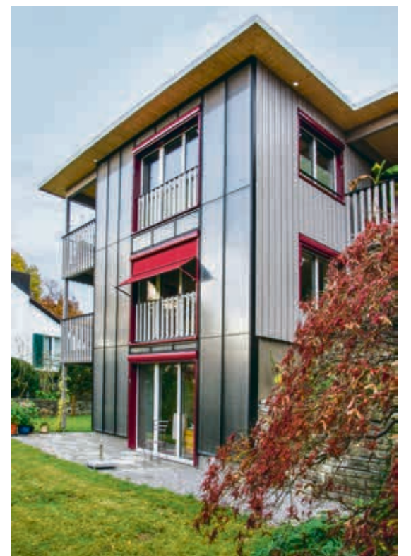
Impianto solare sulla facciata sud.
