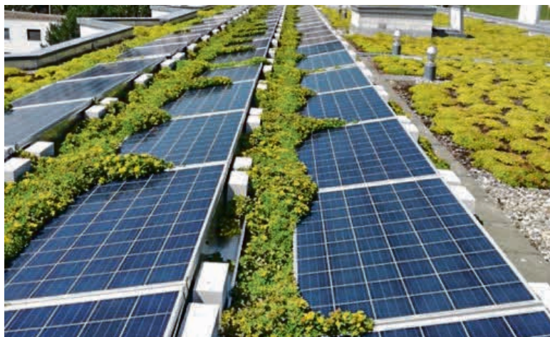
Possono apparire belli, ma compromettono la resa energetica degli impianti fotovoltaici: piante ombreggianti su pannelli solari.
