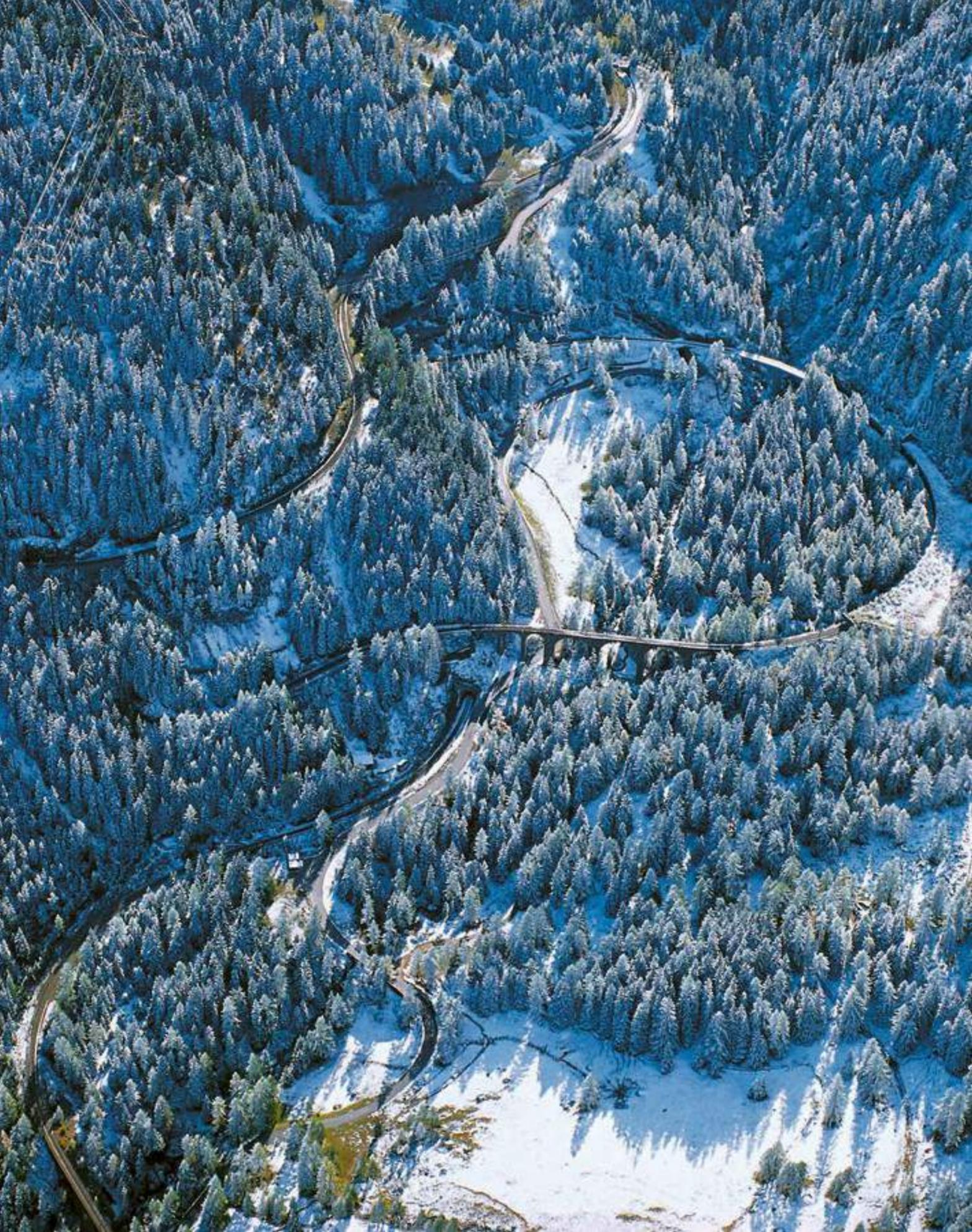
Questa scelta ingegneristica è stata dettata dall'esigenza di avere un raggio di curva non superiore a 100 metri. Il fatto che, alla fine del ponte, il treno entra in una galleria che si apre a strapiombo al centro della parete, aumenta ancor di più il fascino di questa costruzione spettacolare.
