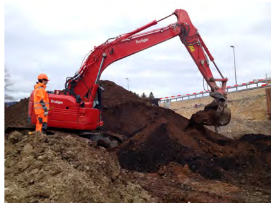
Abb. 22: Radiologische Überwachung der Aushubarbeiten in einer ehemaligen Deponie, die möglicherweise mit Radium kontaminierte Abfälle enthält.
