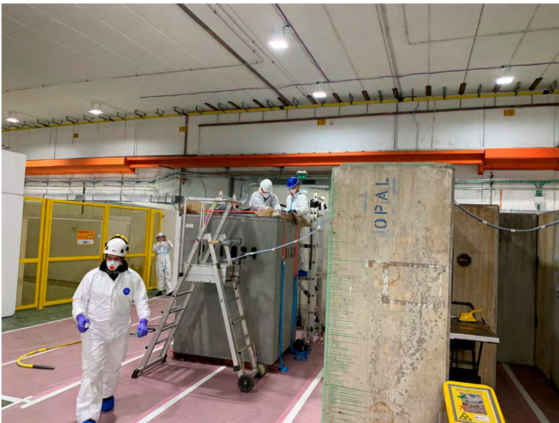
Abb. 7: Konditionierung des ersten Targets des n-TOF-Experiments im CERN, mit Unterstützung des Paul Scherrer Instituts (PSI), zur Vorbereitung des Transports ins Bundeszwischenlager.
