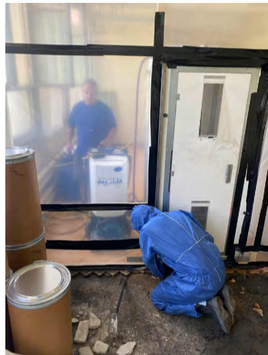
Abb. 23: Sanierung einer mit Radium und polyzyklischen aromatischen Kohlenstoffen (PAK) kontaminierten ehemaligen Uhrenfabrik.
