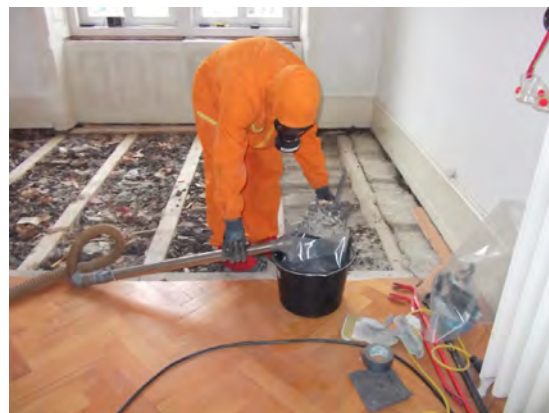
Abb. 19: Radiumsanierung in einer Wohnung.
