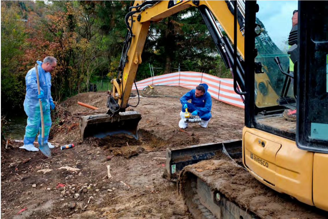
Abb. 25: Schlusskontrolle des BAG zur Überprüfung, ob die Dekontamination erfolgreich war.
