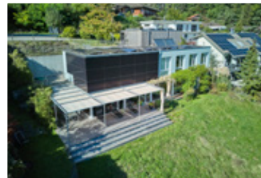
Jürg Beriger a fait recouvrir de panneaux solaires la façade sans fenêtre de sa maison à Lostorf (SO).
