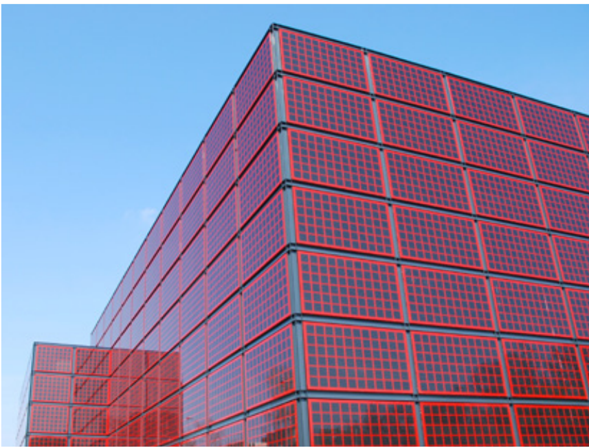
Le Data Center de l'EPFL à Ecublens (VD) attire le regard avec sa façade rouge et noire composée de panneaux photovoltaïques.
