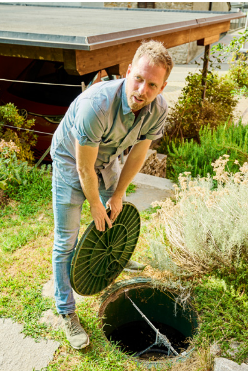
Alberto Conelli a fait enterrer un réservoir de 3000 litres dans le sol, dans lequel il collecte l'eau de pluie du toit.
