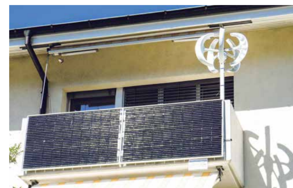
Mit einer ganzjährig betriebenen 600-Watt-PV-Anlage lassen sich etwa 10 Prozent des Strombedarfs in einem Vier-Personen-Haushalt decken.
