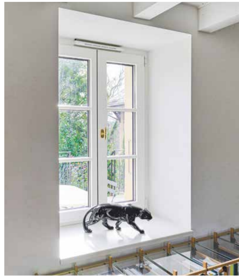
Chic verpackt: 30 cm zusätzliche Dämmung und dreifach verglaste Fenster mit Lüftungselement darüber.
